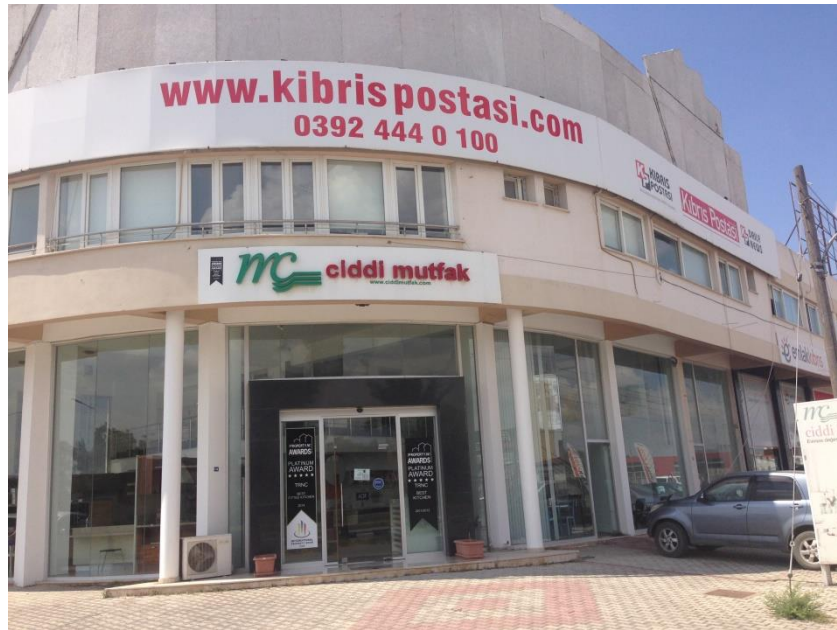
Görsel EK-3.4. Kıbrıs Postası gazetesi binası.
