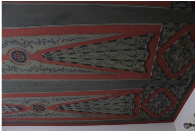
Fotoğraf 177 2 no'lu oda restorasyon sonrası
