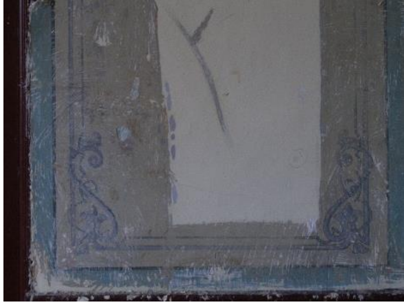
Fotoğraf 94 Duvar süslemeleri detayı
