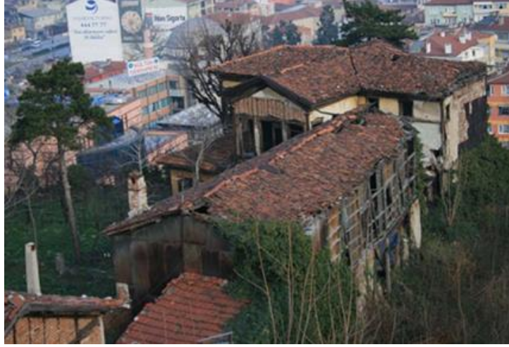
Fotoğraf 212 Restorasyon öncesi yapı (Kapar, 2008)
