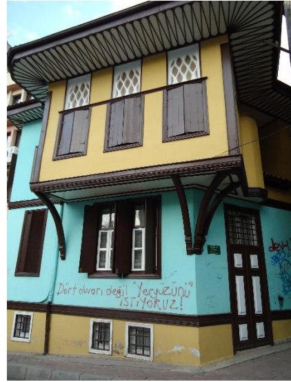
Fotoğraf 47 Yapının dıştan görünümü
