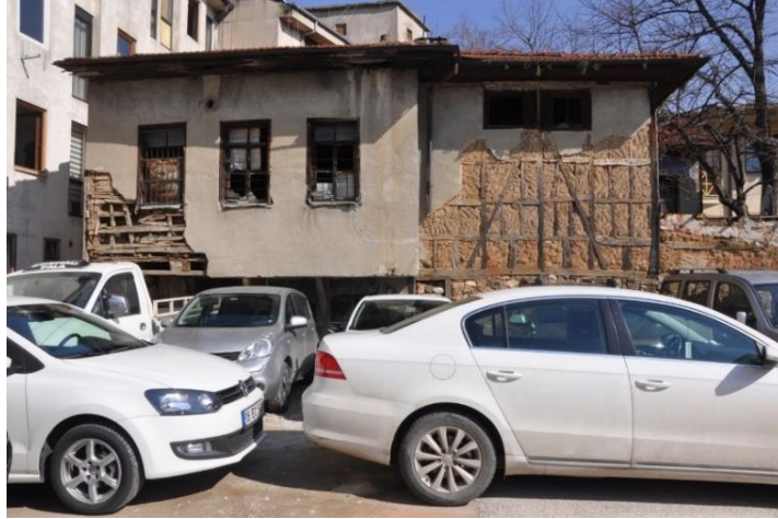
Fotoğraf 160 Yapının dıştan görünümü
