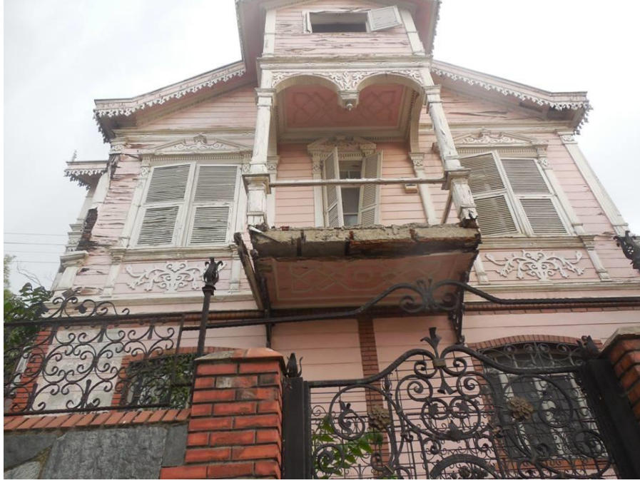
Fotoğraf 237 Yapının dıştan görünümü
