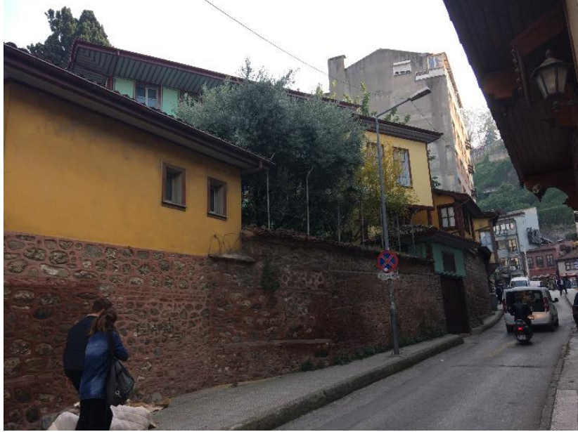
Fotoğraf 294 Yapının dıştan görünümü
