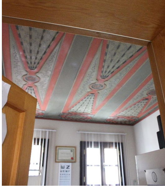
Fotoğraf 176 2 no'lu oda restorasyon sonrası
