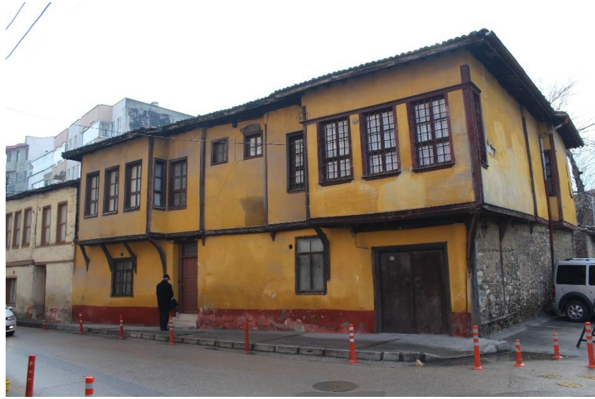
Fotoğraf 178 Yapının dıştan görünümü
