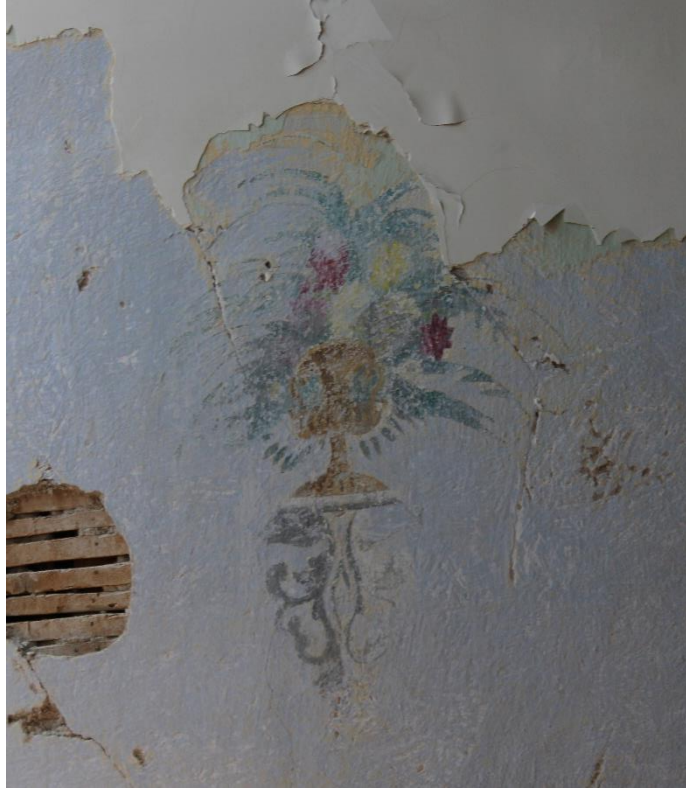
Fotoğraf 142 Giriş katındaki duvar yüzeyi detayı
