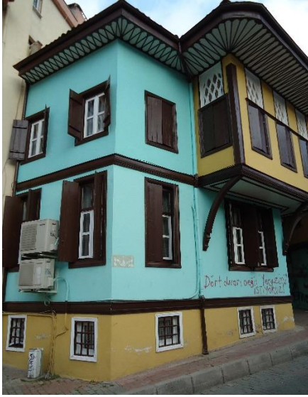
Fotoğraf 46 Yapının dıştan görünümü
