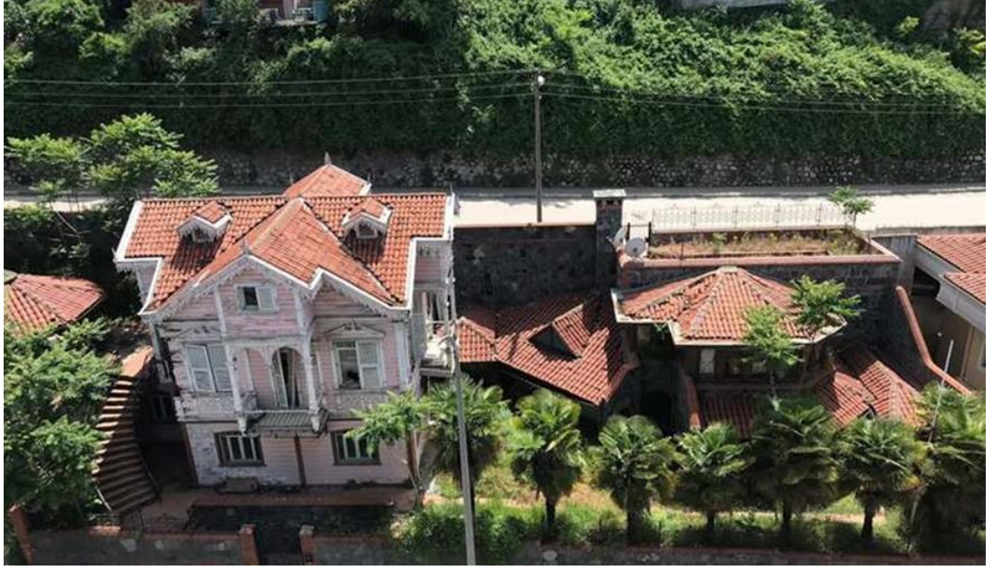
Fotoğraf 235 Yapının dıştan görünümü
