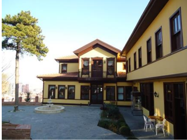
Fotoğraf 213 Restorasyon sonrası yapı
