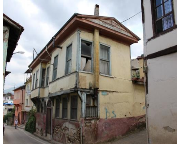
Fotoğraf 203 Kuzeydoğu cephesinden görünüm
