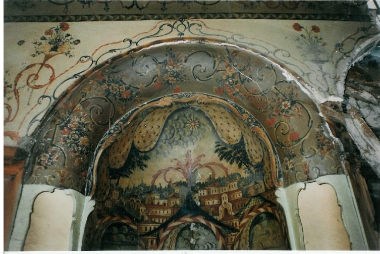
Fotoğraf 251 Restorasyon öncesi niş ve etrafındaki süslemeler
