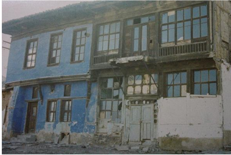
Fotoğraf No 1 Yapının cepheden görünümü
