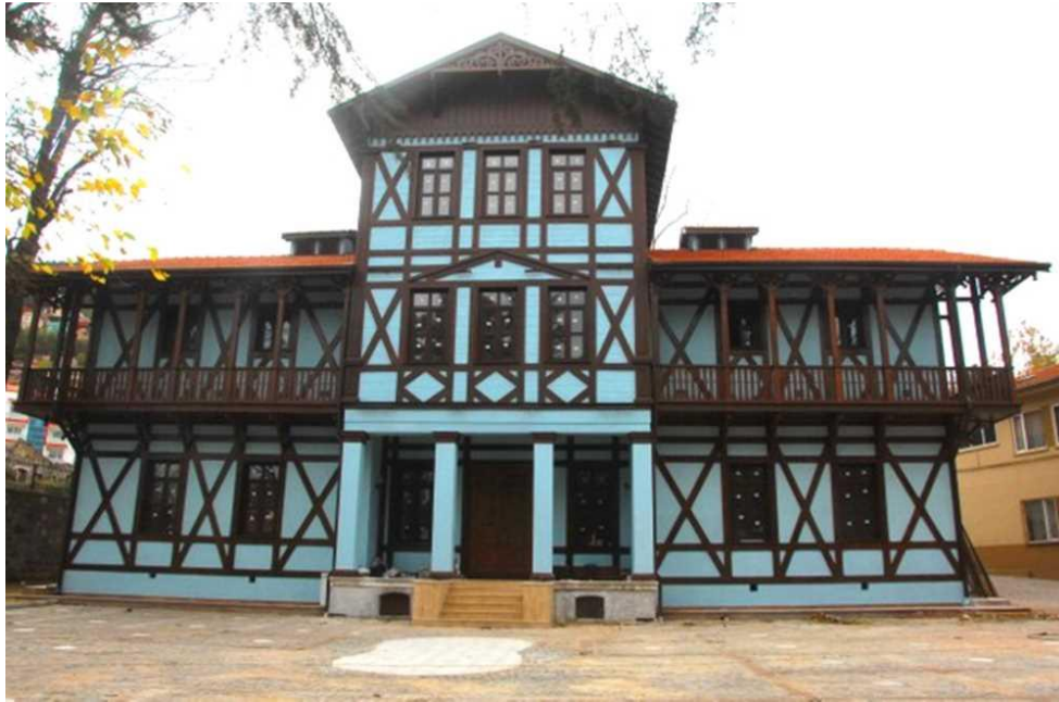
Fotoğraf 338 Yapının dıştan görünümü
