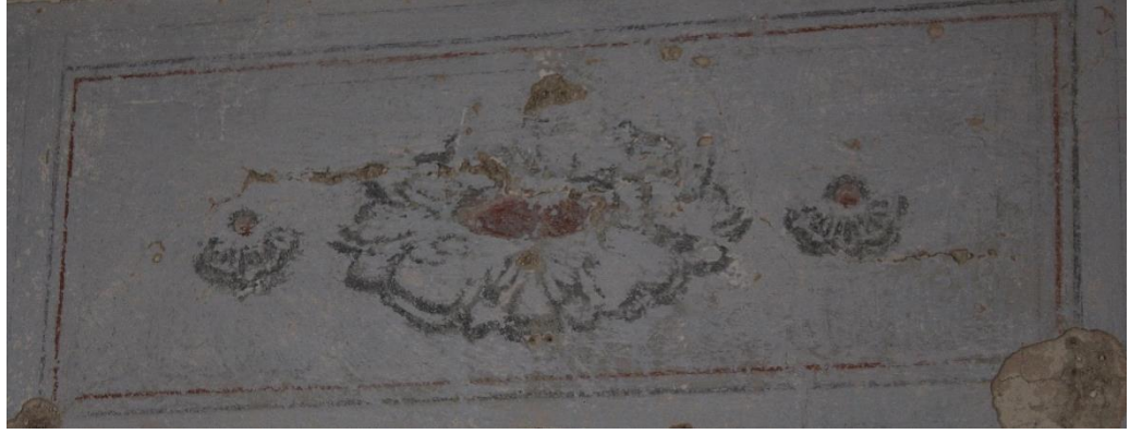
Fotoğraf 141 Giriş katındaki kapı alınlığı
