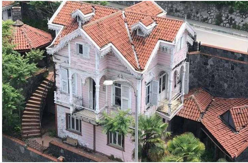
Fotoğraf 236 Yapının dıştan görünümü
