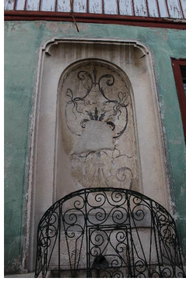
Fotoğraf 295 Tevhidhâne cephesindeki niş
