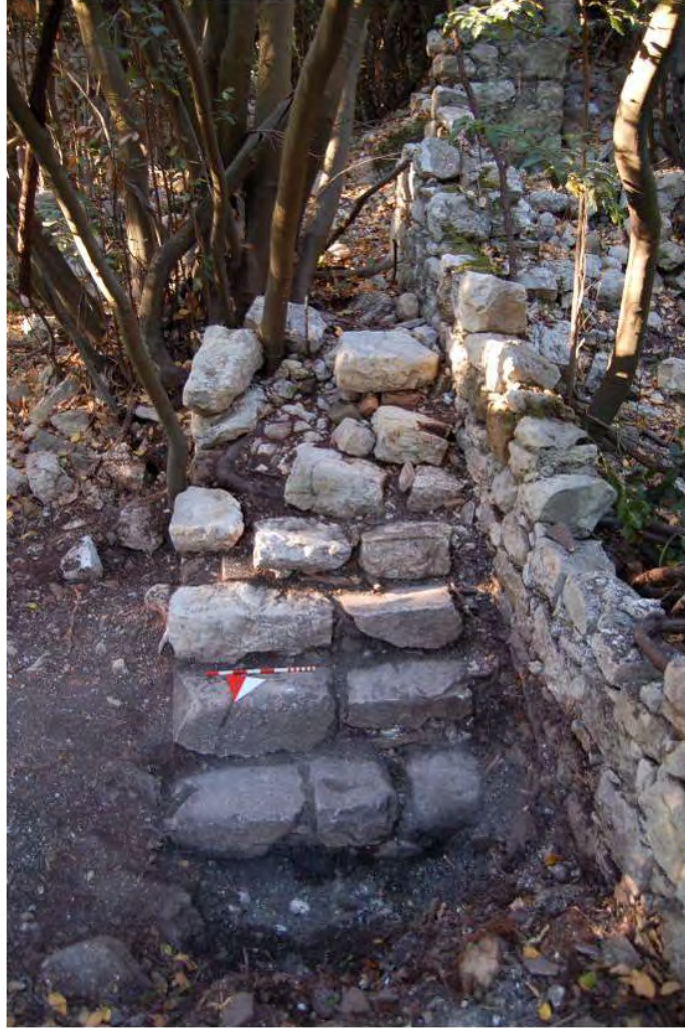
 ekil 121. M16'nın kuzeyinde yer alan ta  merdiven
