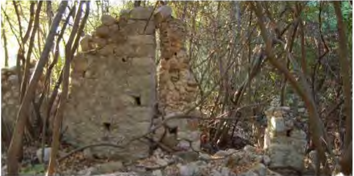
Şekil 59. Güney transept kolu ve köşe odasının birleşme noktası, güneyden bakış
