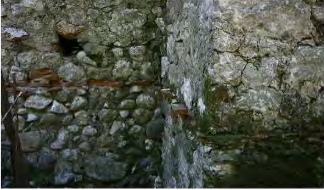
Şekil 70. KEM3 ve KEM1'e ait ikinci katların tuğla döşeme izleri
