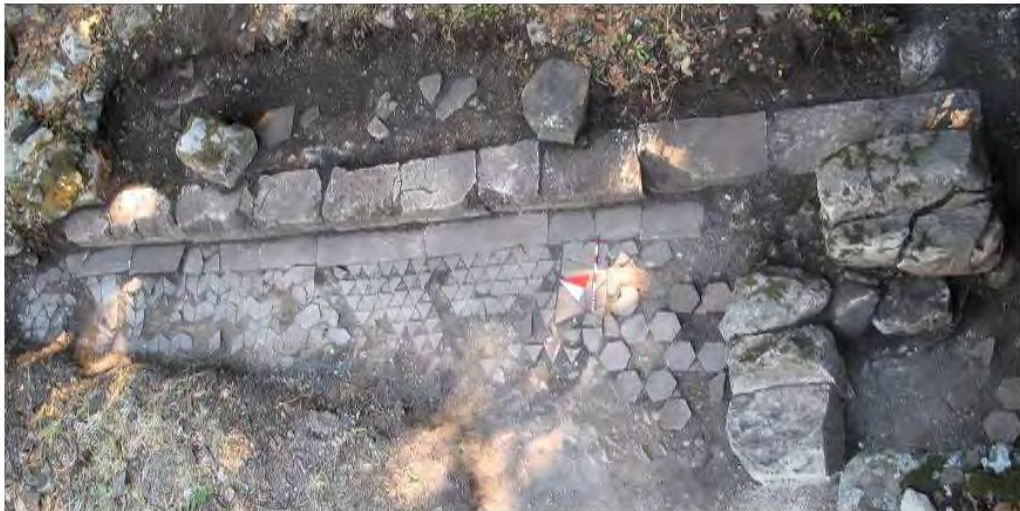
Şekil 47. Templon stylobat düzenlemesi ve naos zemin döşemesi, güneyden bakış
