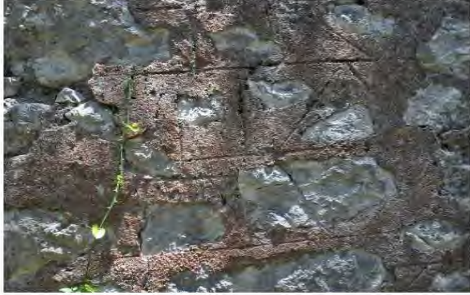
Şekil 39. Episkopeion kuzey cephe, detay
