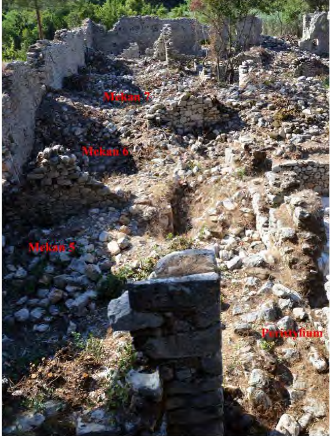
Şekil 116. Batıda yer alan mekânlar, güneyden bakış
