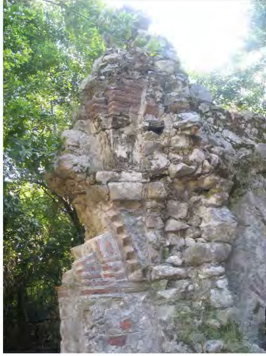
A) Mozaikli Yapı D Odası güney duvar, kapı kemer ve pandantif başlangıçları.
