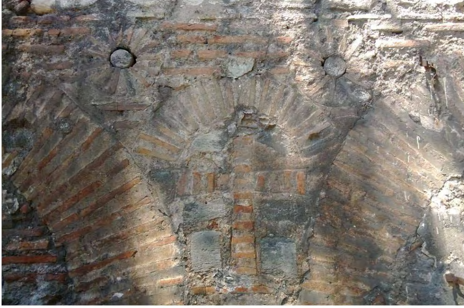
A) Konstantinopolis Studios Manastır Kilisesi atrium kuzey duvarı
