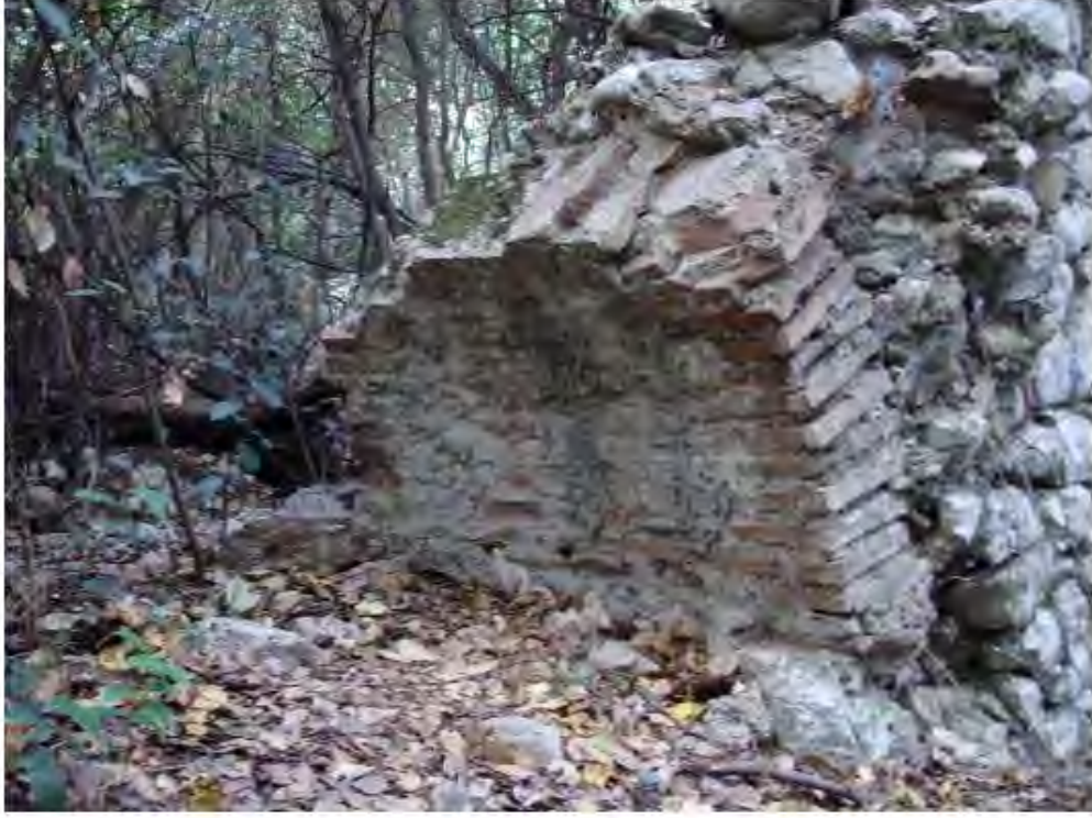
Şekil 108. Mekân H'nin kuzey duvarında görülen niş
