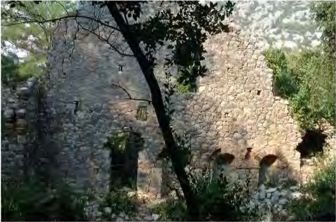
Şekil 83. Triclinium batı duvar genel görünüş
