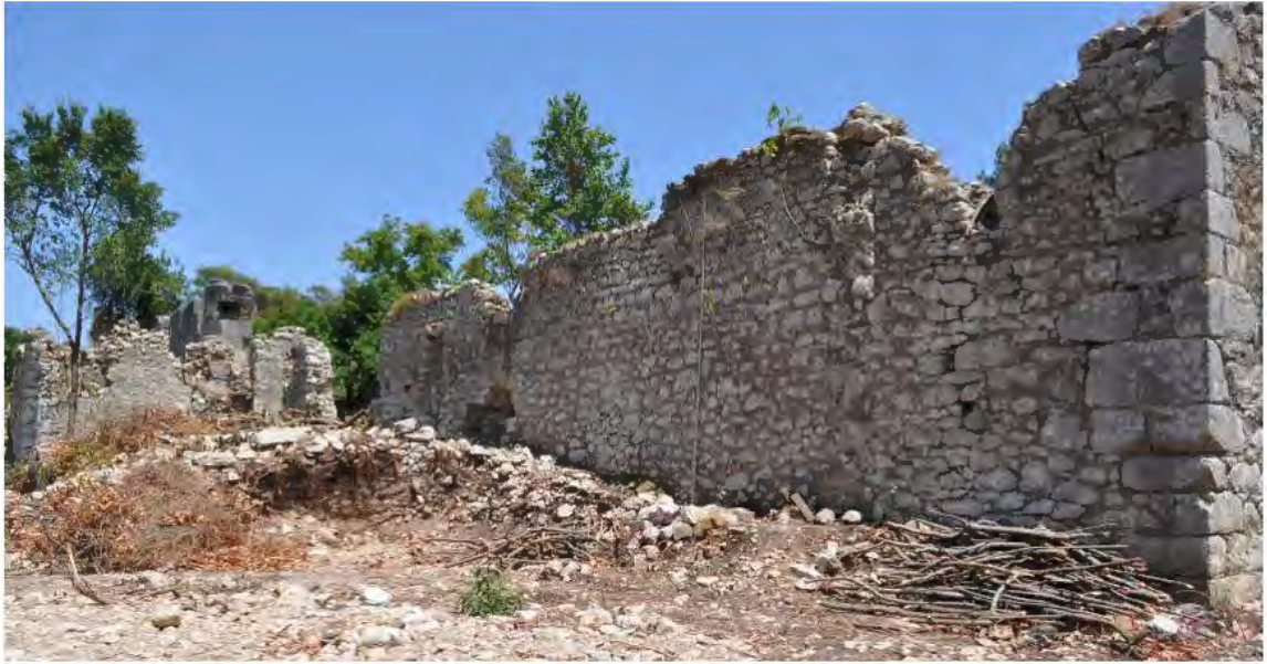
Şekil 38. Episkopeion kuzey cephe, tapınak kapısının batısında kalan bölüm
