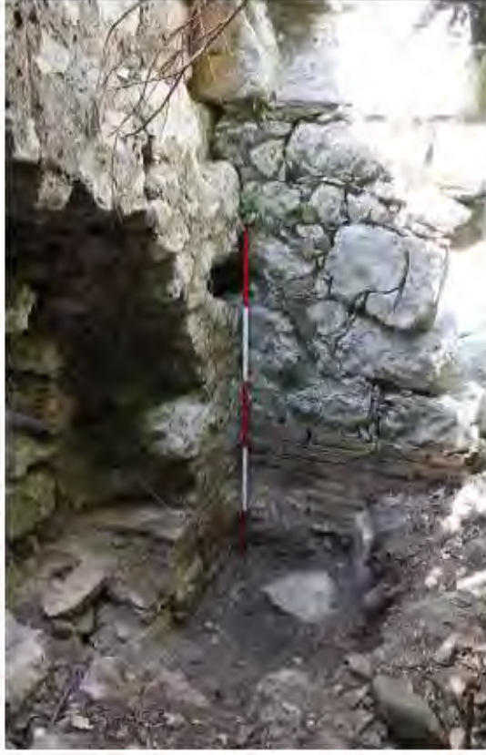
Şekil 19. Roma dönemi tapınağı kuzey cella duvarı, doğudan bakış
