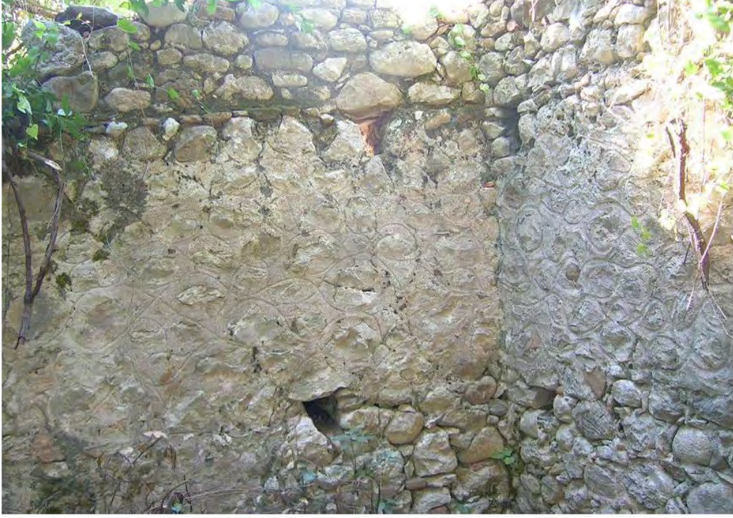
Şekil 74. Vaftizhane vestibulum'u kuzeybatı köşesi
