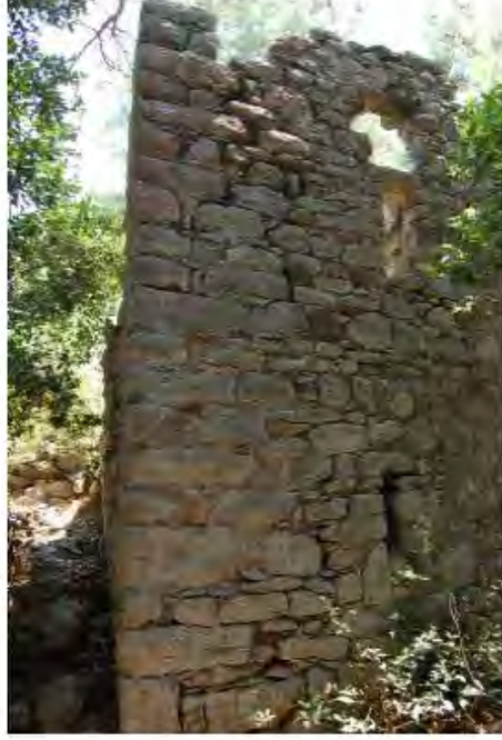
Şekil 36. Episkopeion batı cephe M2'nin batı duvarı
