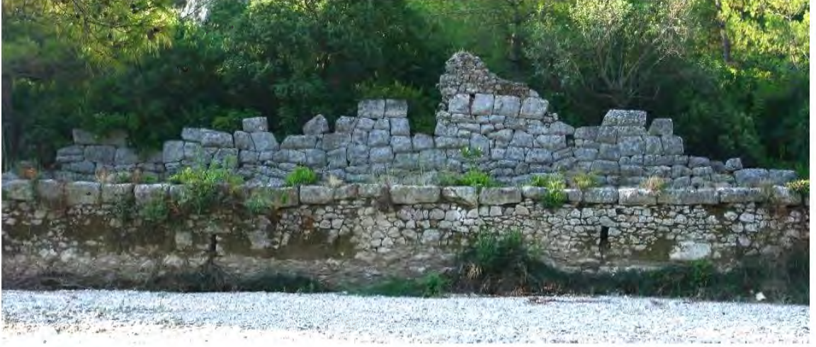
Şekil 8. Hellenistik dönem sur duvarı
