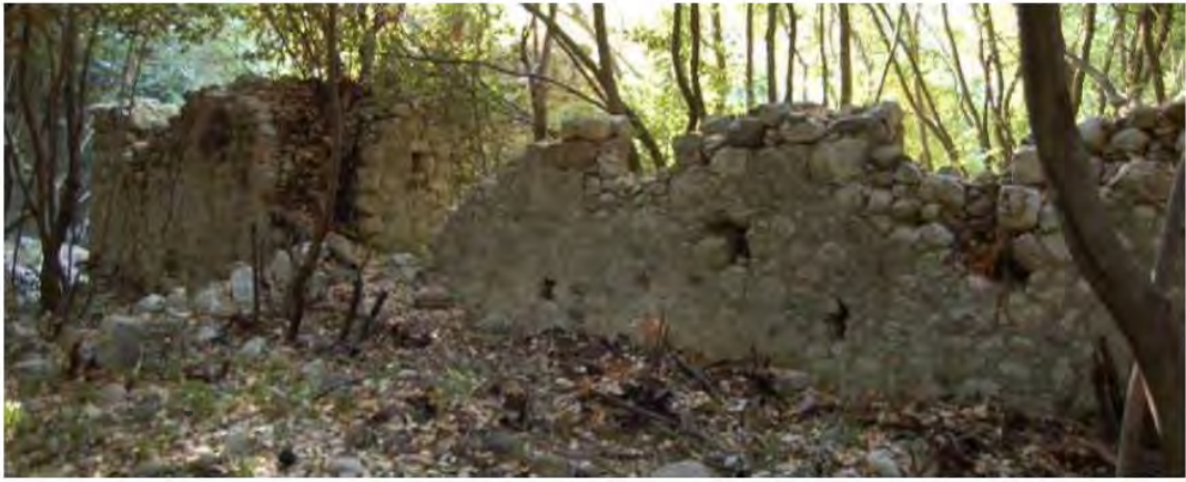
Şekil 48. Güney transept kolu ve trikonchos güney cephe
