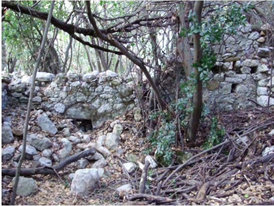
Şekil 124. M17 kuzey duvar
