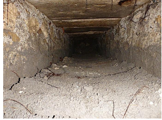
Görsel 3.26: Kanalın içten görünüşü
