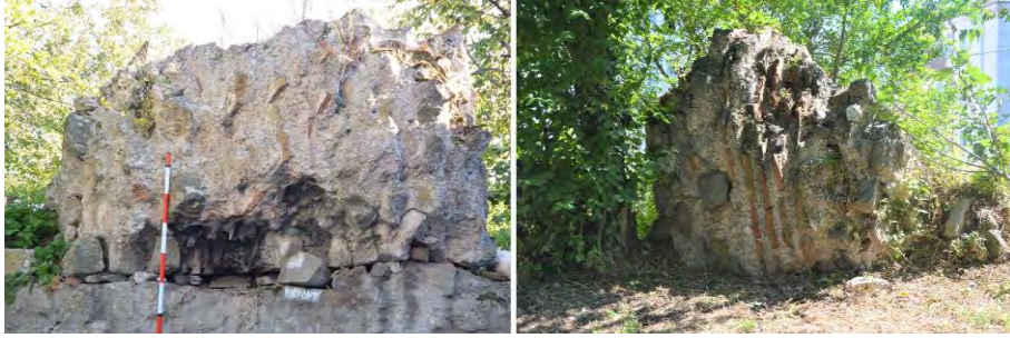
Figür 90: Kuzey ve Kuzeybatıdaki Yıkık Duvarlar (BİYA Arşivi)
