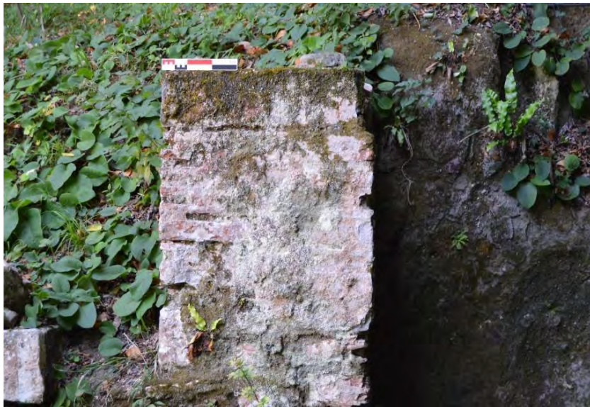
Figür 412: Atrium Doğu Duvarı Güney Bölümü Duvar Örgüsünden Detay Görünüş
