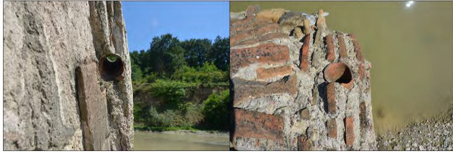
Figür 542: Selyaran Tabanındaki Su Tahliye Kanalı
