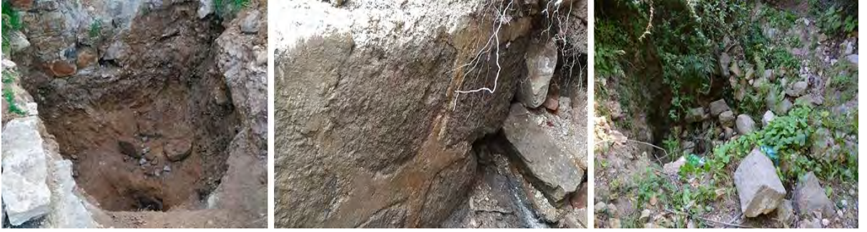
Figür 53: Güney Duvarın 2018 ve 2019 Yıllarındaki Durumu (BİYA Arşivi)
