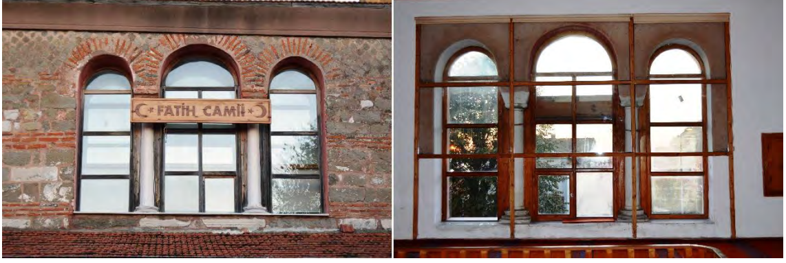
Figür 610: Amasra Fatih Cami Batı Cephe Tribelon'un İç ve Dıştan Görünüşü
