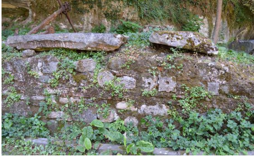
Figür 411: Atrium Batı Duvar Orta Bölümü Duvar Örgüsünden Detay Görünüş
