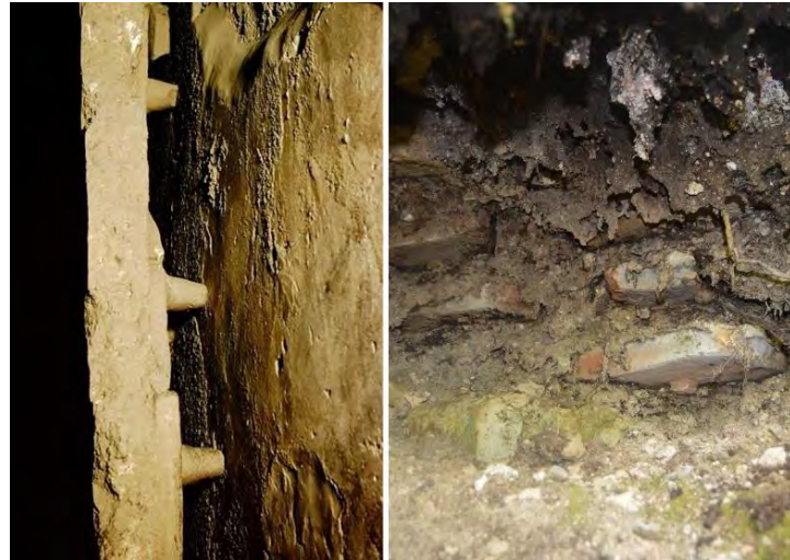
Figür 572: Tegula Mammata ve Dişli Tuğlanın Duvarda Kullanımını Gösteren Fotoğraflar (Sol Görsel: https://www.pompeiiinpictures.com/pompeiiinpictures/R7/7%2001%2008%20womens%20p4.htm , Erişim Tarihi: 11.08.2020)
