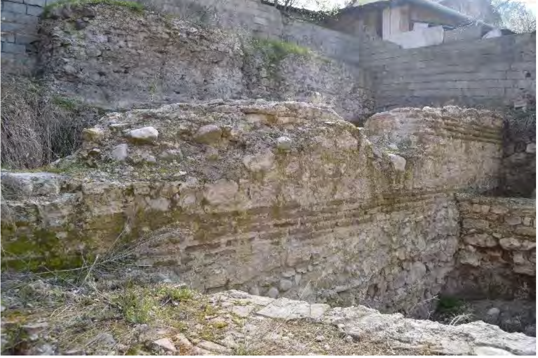
Figür 290: Temenosun Kuzeyindeki Duvar
