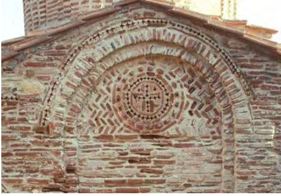
Figür 601: Sakız Adası Panagia Sikelia Kilisesi Güney Cephedeki Keramoplastik Unsurlar (Trkulja, 2004; Fig 57)
