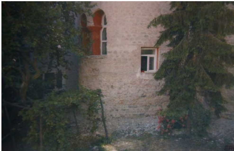
Figür 467: Apsis Duvarı Restorasyon Öncesi (KVBM)
