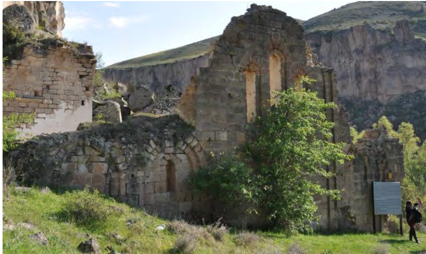
Figür 594: Aksaray Karagedik Kilise Kuzey Cephe (Soykan, 2019; Resim 4)
