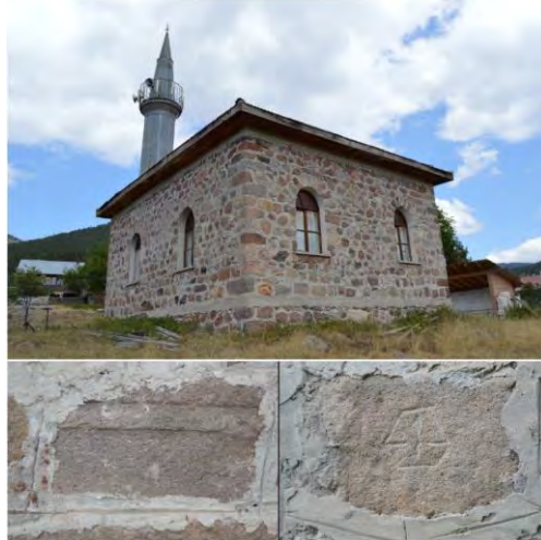
Figür 209: Hacıağız Yaylası Cami ve Duvarındaki Devşirme Mimari Elemanlar
