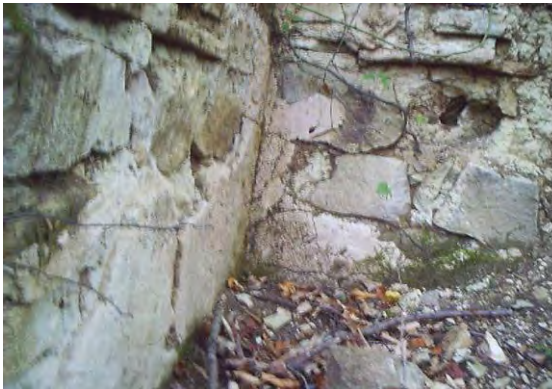
Figür 512: Kuzey Duvar Örgüsü Detay Görünüşü ve Renkli Sıva Kalıntısı (S. Uyar Arşivi)
