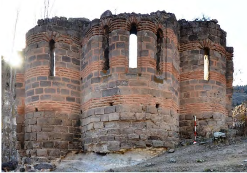
Figür 144: Doğu Cephe
