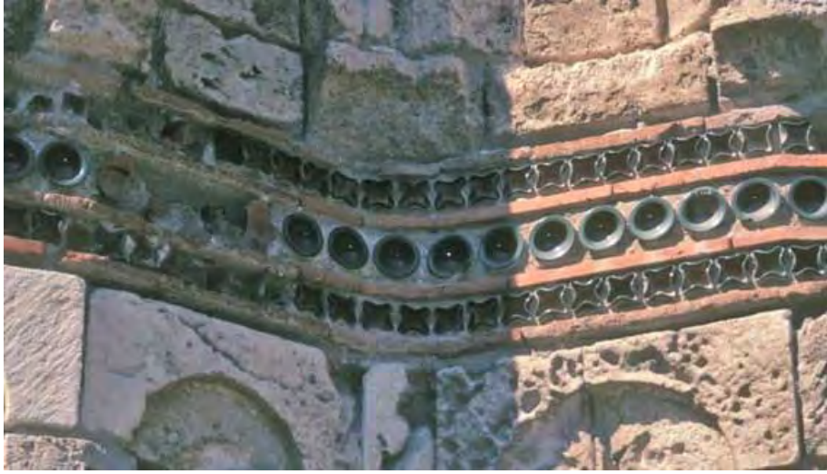
Figür 602: Mesembria Pantokrator Kilisesi Cephedeki Keramoplastik Unsurlar (Trkulja, 2004; Fig 51)
