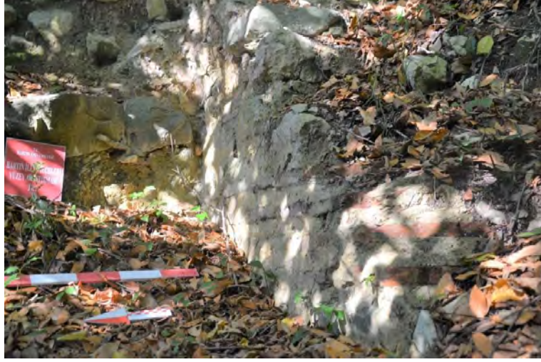
Figür 101: Güneydoğu Duvarı (BİYA Arşivi)
