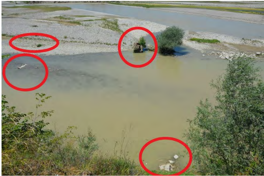
Figür 537: Karabaşlı Köyü Köprü Kalıntısına Ait Duvar Kalıntıları
