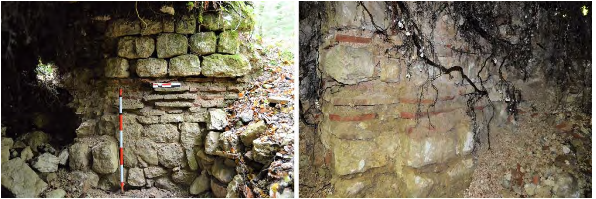
Figür 6: Nartheks Doğu ve Batı Duvarındaki Duvar Payeleri (BİYA Arşivi)
