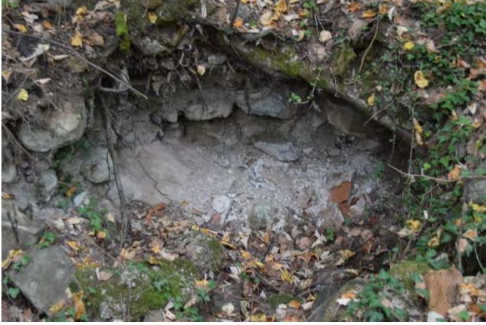
Figür 364: Güneydoğu Duvar Örgüsü Detay Görünüşü
