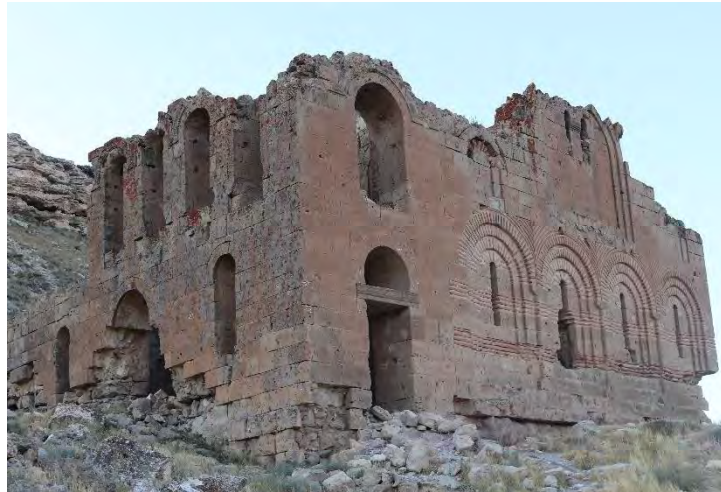
Figür 591: Aksaray Çanlı Kilise Güney Cephe (G. Öncelen Arşivi)
