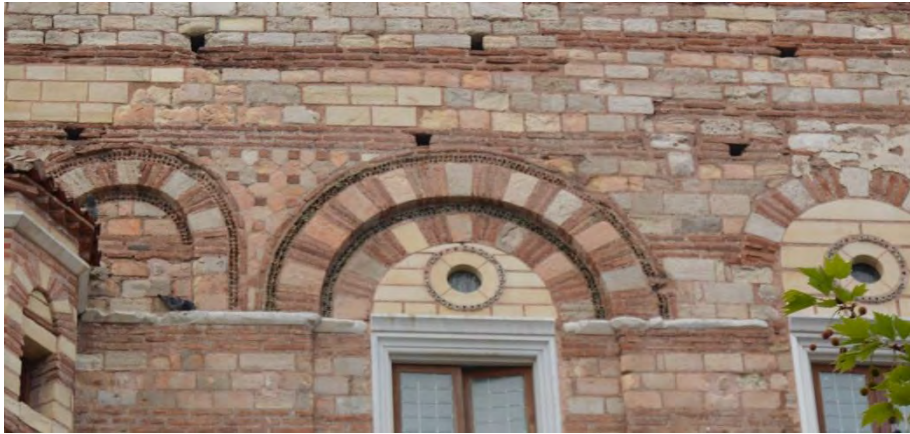
Figür 603: İstanbul Tekfur Sarayı Cephesindeki Keramoplastik Unsurlar
