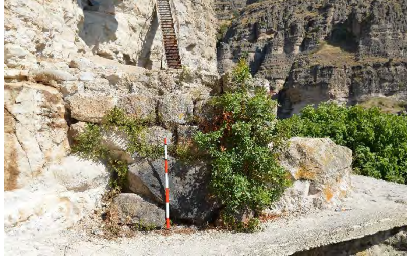
Figür 213: Doğudaki Yerleşime Giden Patika Yoldaki Duvar Kalıntısı
