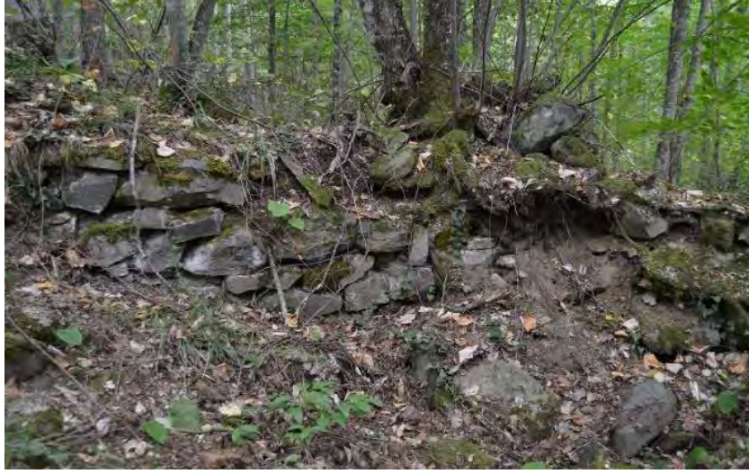
Figür 361: Naos Güney Duvarı
