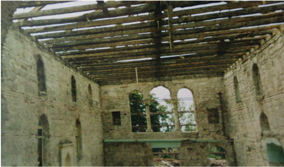
Figür 575: Amasra Fatih Cami Restorasyon Çalışması Fotoğrafı (KVBM)
