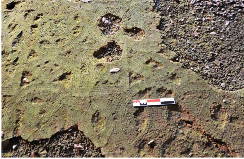
Figür 410: Güney Panelden Detay Görünüş
