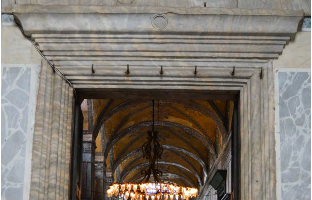
Figür 605: İstanbul Ayaosfyası Güneybatı Kapı Lento ve Söveleri
