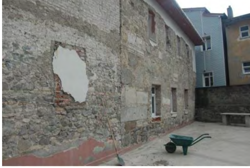
Figür 471: Güney Duvar Restorasyon Çalışmaları (Gür, 2019; Resim 14)
