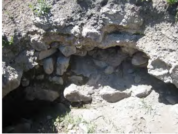
Figür 313: Gölbaşı Köyü Yapı Kalıntısına Ait Duvar İzleri
