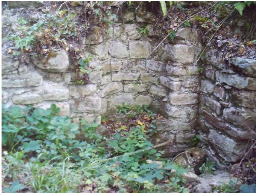
Figür 508: Kuzeydoğu Duvardaki Niş (S. Uyar Arşivi)
