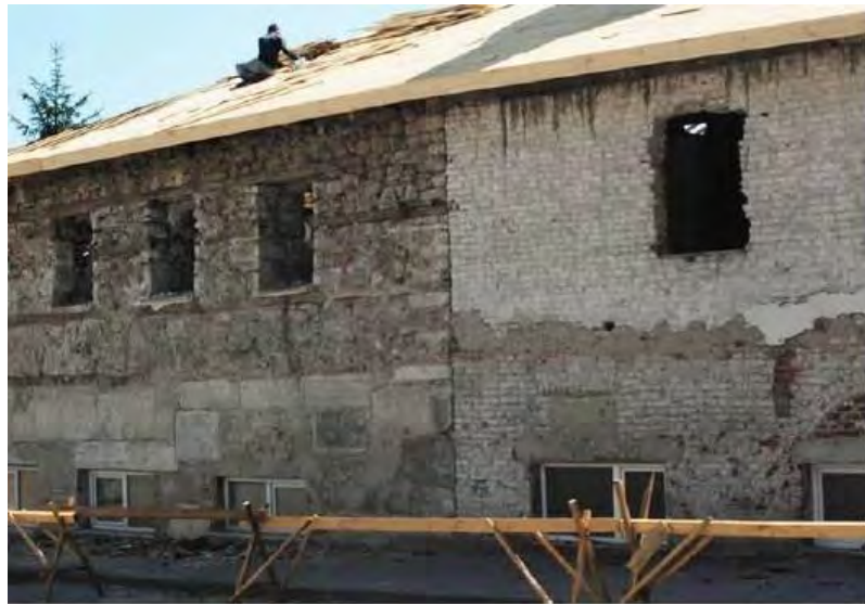
Figür 470: Kuzey Duvar Restorasyon Çalışmaları (Gür, 2019; Resim 79)
