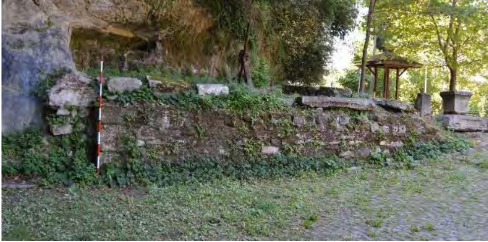
Figür 380: Atriumun Batı Duvarı
