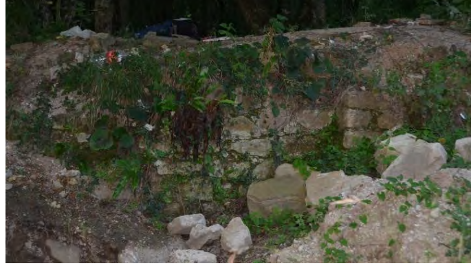
Figür 502: Narteks Kuzey Duvarı
