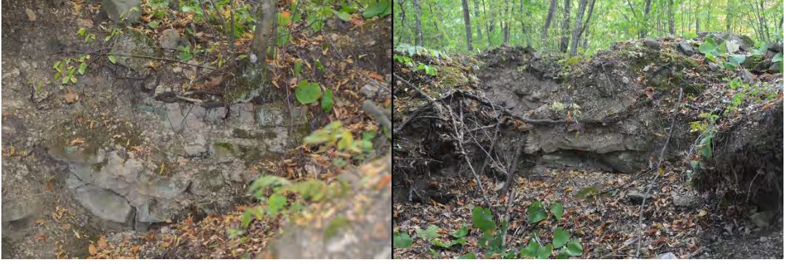
Figür 488: Naos Güney Duvarının Orta Bölümü
