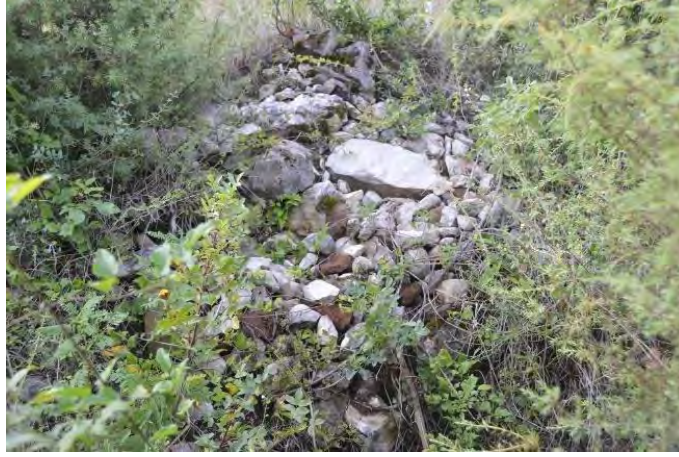
Figür 499: Naos Güney Duvarı
