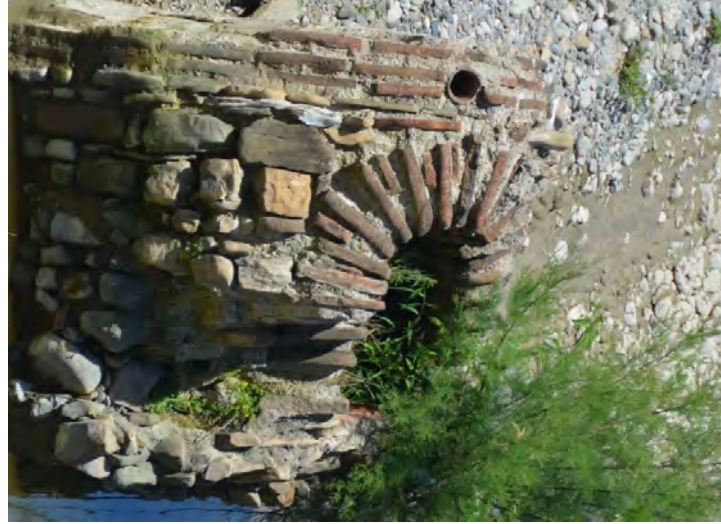
Figür 543: Selyarandaki Su Tahliye Kanalı Kemerli
