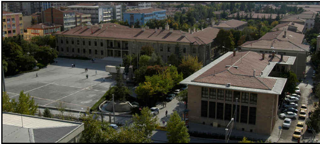
Resim 4.16: Eskişehir Hükümet Konağı ve Merkez Bankası(1945–1948) ( www.eskisehir.gov.tr )
