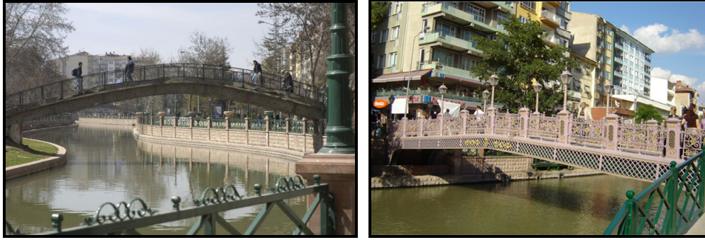
Resim 4.11: Adalarda bulunan köprünün eski ve yeni hali (İlgar 2008)
