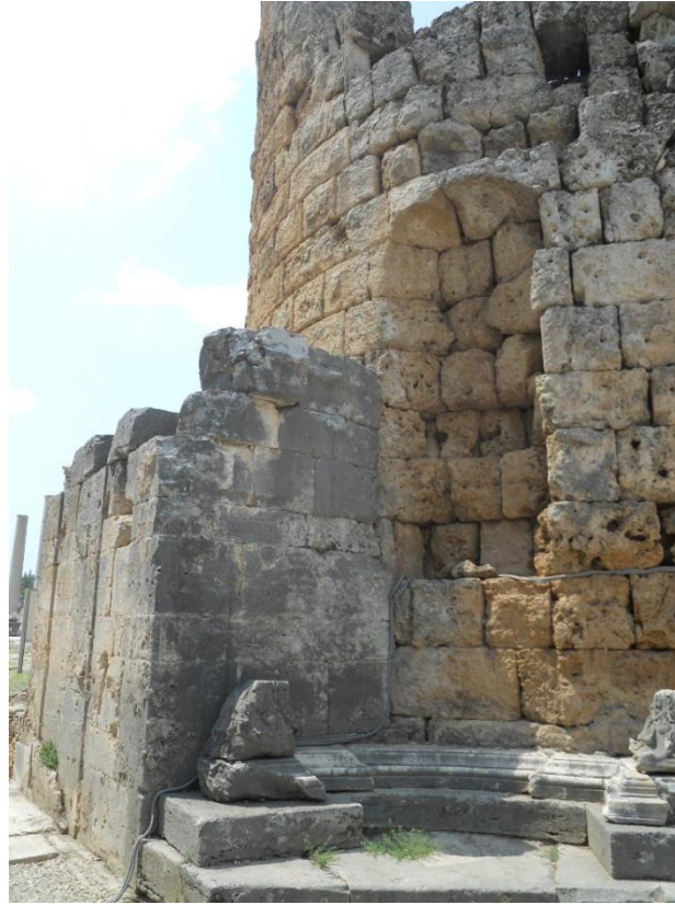
Görsel 15: Kemerli Kapı İle Kule Bedenine Oyulan Nişin Kesişim Noktası
