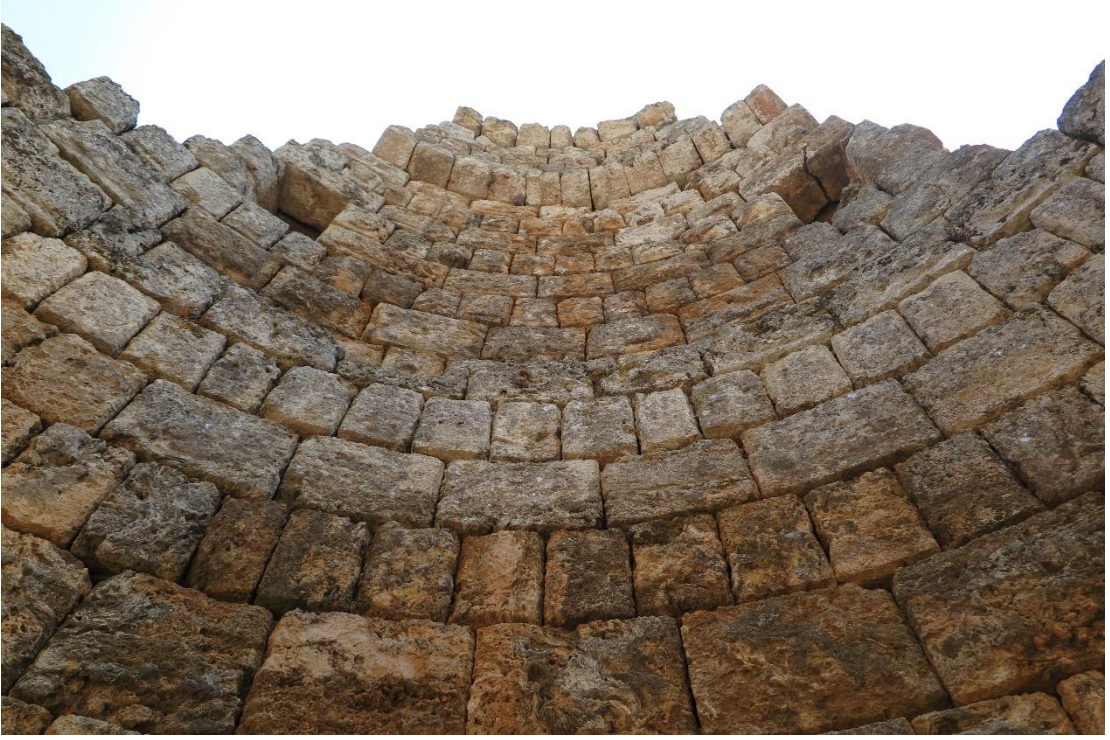
Görsel 12: Batı Kulenin İçerisinden İsodomik Duvar Örgü Tekniği Görünümü
