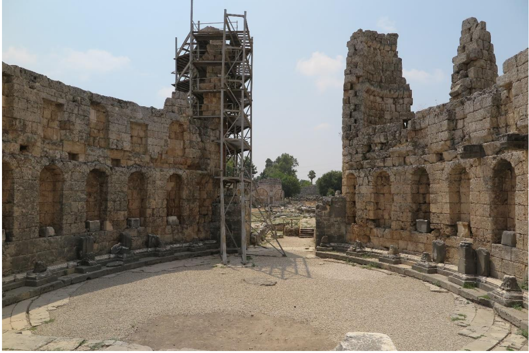
Görsel 16: Oval Avlulu Güney Kent Kapısı'nın Kuzeyden Görünümü
