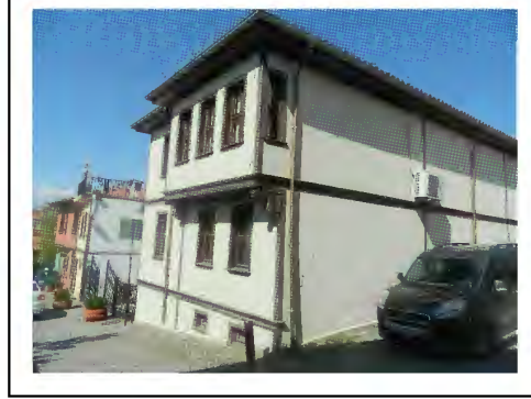
Yan Cephe Fotosu (Sağ)
