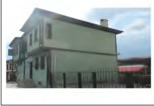
Yan Cephe Fotosu (Sağ)
