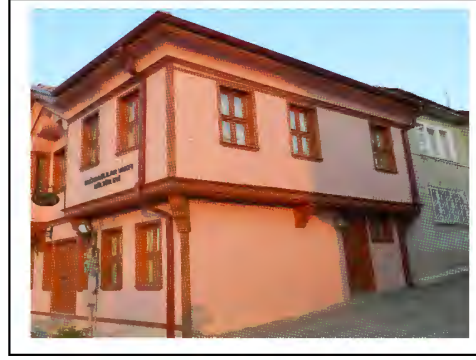
Yan Cephe Fotosu (Sağ)
