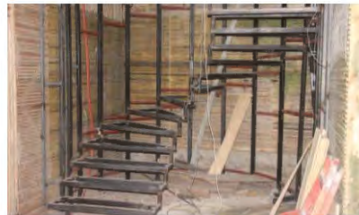
Şekil 5.30. ETO Binası Z1’deki merdivenin restorasyon esnasındaki hali (Kişisel arşiv, 2014)
