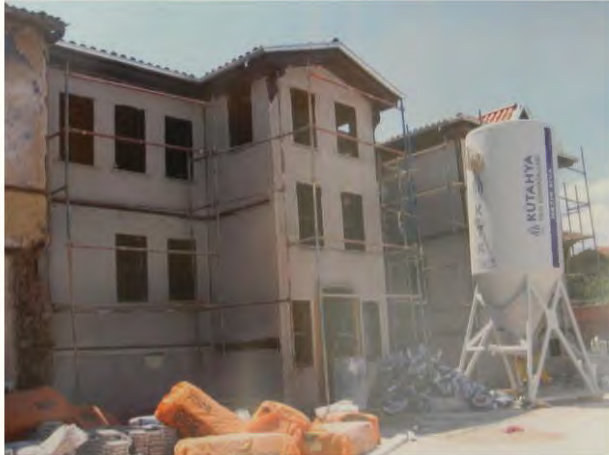
Şekil 5.35. ESİAD Binası restorasyon esnasında cephenin sıvanması (ESİAD arşivi)
