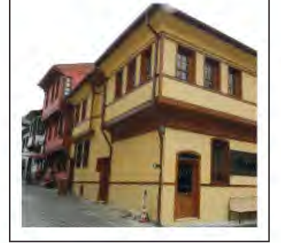
10 Nolu Bina Yan Cephe FOTOSU (Sol)
