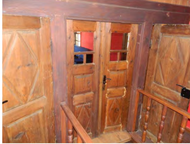
Şekil 5.43. Yağcızade Konağı birinci kata girişte bulunan kapılar (Kişisel arşiv)
