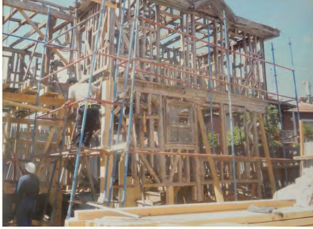
Şekil 5.34. ESİAD Binası restorasyon esnasında bina kabuğunun kaldırılmış hali (ESİAD arşivi)
