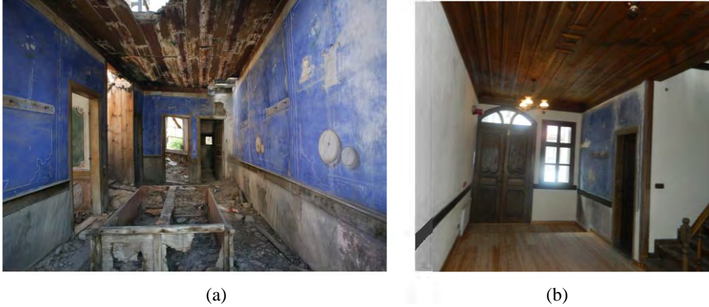
Şekil 5.25. Karargah Binasi Z7 sofası (a) yangın sonrası (Eskişehir Büyükşehir Belediyesi arşivi) ve (b) restorasyon sonrası 2015 hali (Kişisel arşiv)
