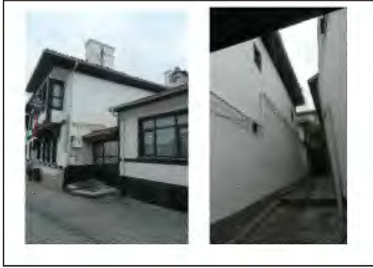
Yan Cephe Fotosu (Sağ)
