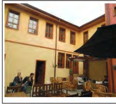
10 Nolu Bina Bahçe Cephe FOTOSU
