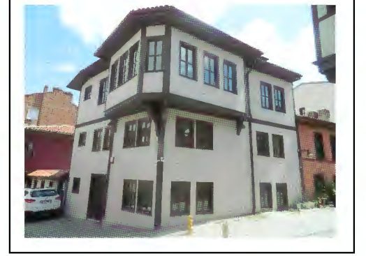
Yan Cephe Fotosu (Sağ)
