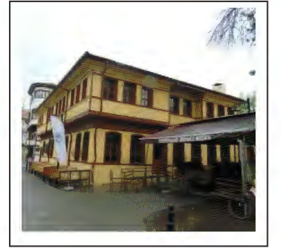
10 Nolu Bina Yan Cephe FOTOSU (Sağ)
