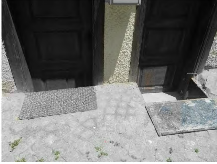
Şekil 5.24. Karargâh Binası bodrum kat girişi ve açılan kapaklar (Kişisel arşiv)
