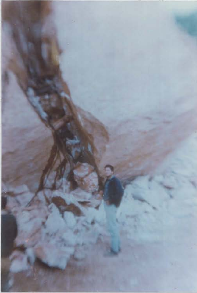
Şekil 12.21. Hidrolik krikolar ile bloğun devrilmesi
