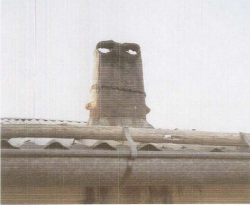
Şekil.3.7. Bir yapı malzemesi olan baca ve kullanımına örnek.
