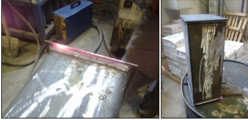
Şekil 3.20. Başlık kaynağı yapımı
