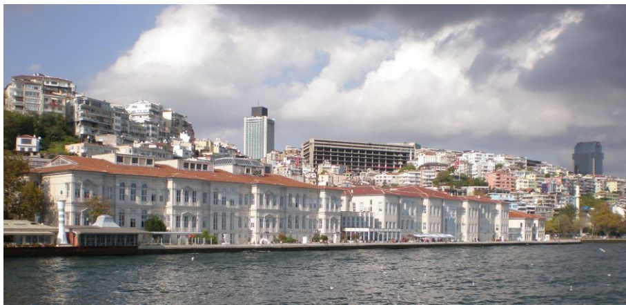
Resim 119: Sanayi-i Nefise Mektebi Âlisi Binası.
