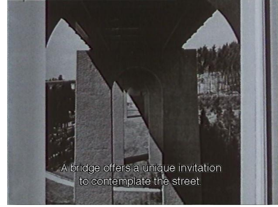
Şekil 61: 234. Aralık, Köprü Ayakları.
