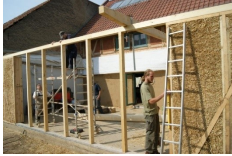
Görsel 2.16. Saman balyasının yapılarda kullanımı ( http-3 )
