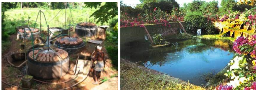
Görsel 2.7. Biyogaz ve Atıksu arıtma tesisi (AUROVILLE, 2018)
