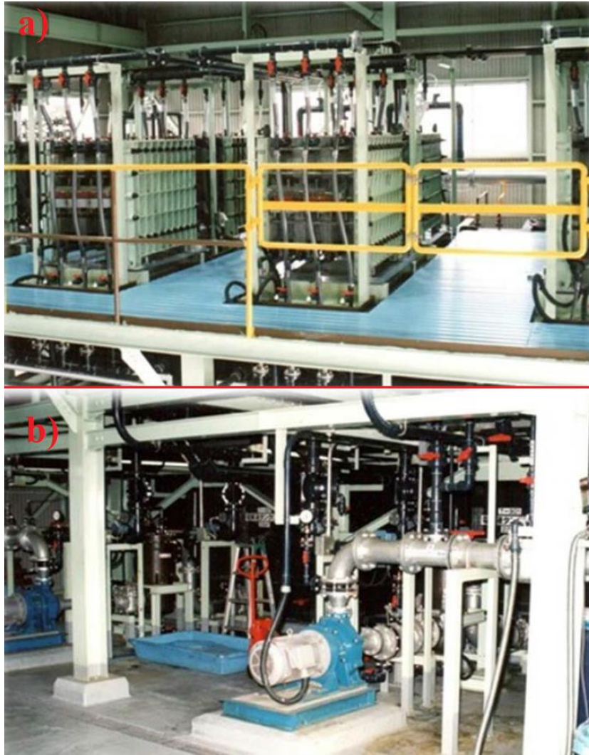
Şekil 1.4. Kashima-Kita Electric Power Corporation tarafından geliştirilen 800 kWh'lik ilk orta boyutlu VRB enerji istasyonu a) VRB hücreleri ve b) elektrolit akışını sağlayan pompa ve boru sistemleri (Skyllas-Kazacos ve McCann, 2015)
