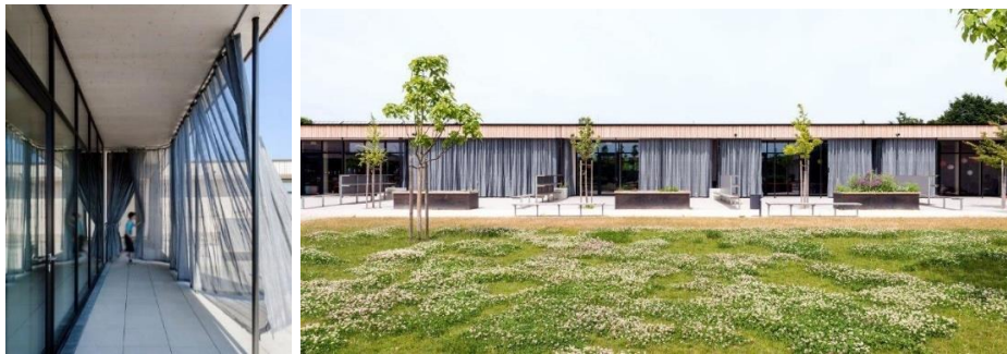
Görsel 4.5. Neuötting Montessori Okulu'ndaki perde sistemi ( http- 39'dan alınmıştır )
