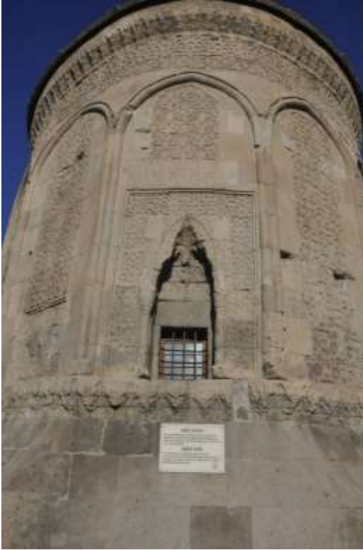
Görsel 2.188. Güneybatı cephe
