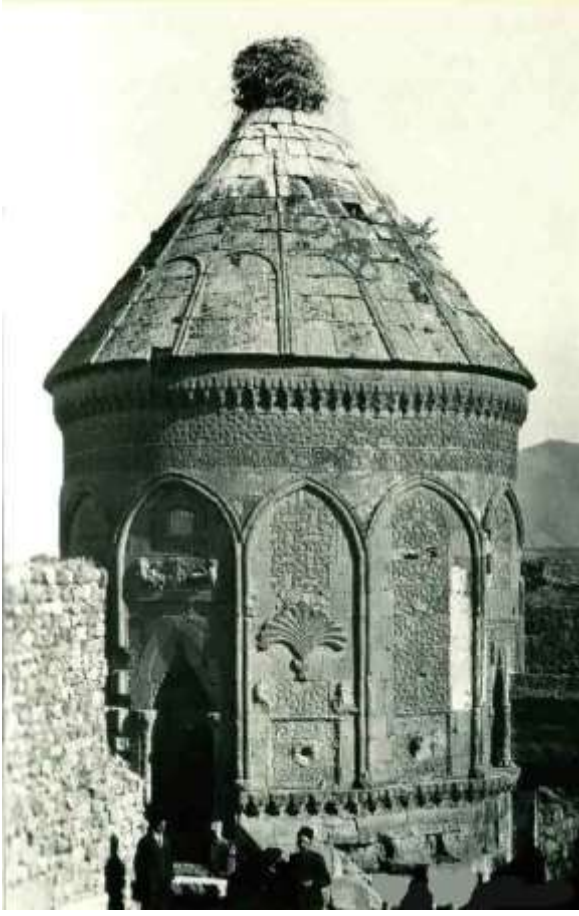
Görsel 2.172. Türbenin onarım öncesi durumu
