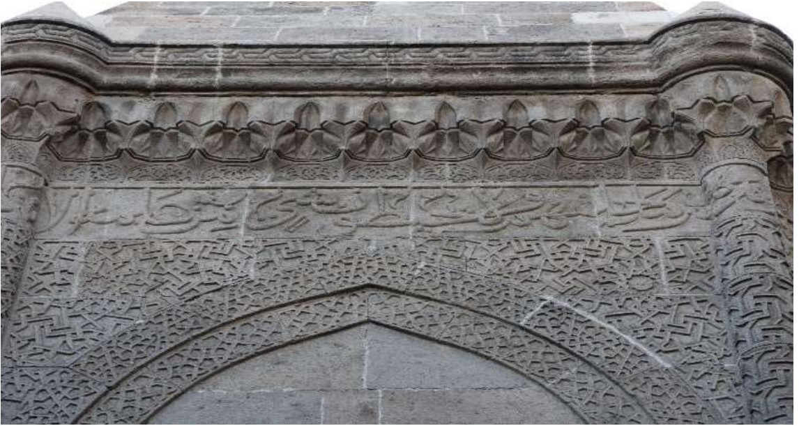
Görsel 2.105. Batı cephe üst kısım
