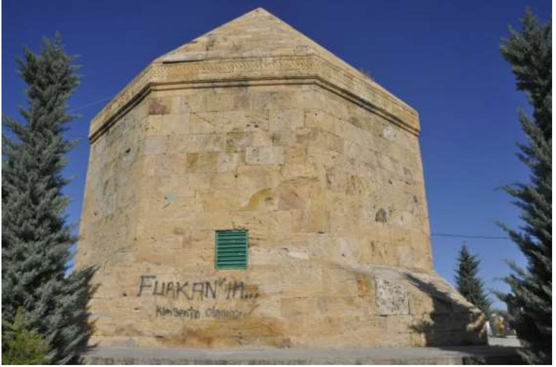
Görsel 2.122. Batı cephedeki pencere açıklığı
