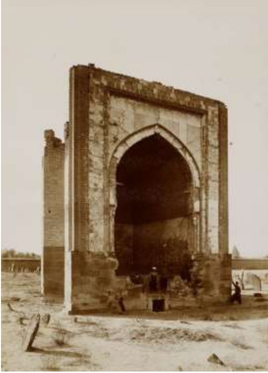
Görsel 2.34. Onarım öncesinde türbenin durumu Kaynak: http://www.eskiturkiye.net/ Erişim tarihi: 22.01.2019
