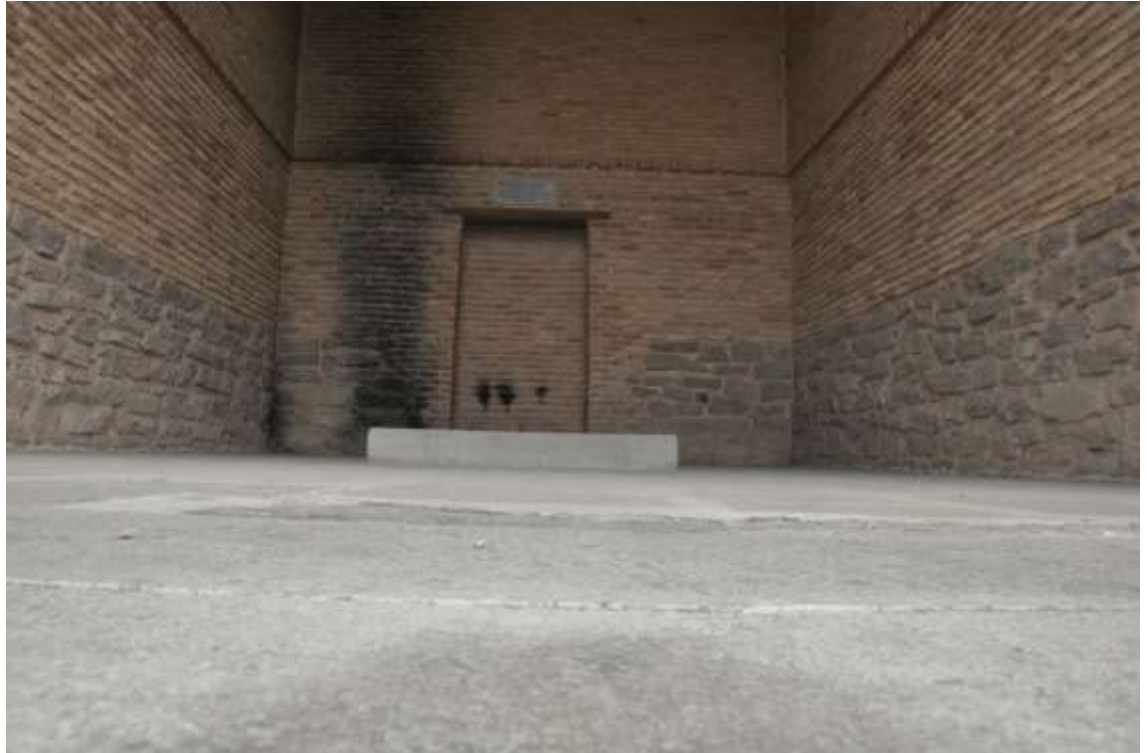
Görsel 2.46. Üst katta üç duvarı dolaşan korniş
