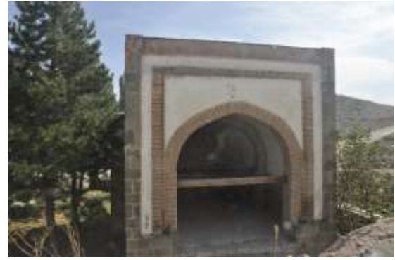
Görsel 3.6. Boyalıköy Eyvan Türbe
