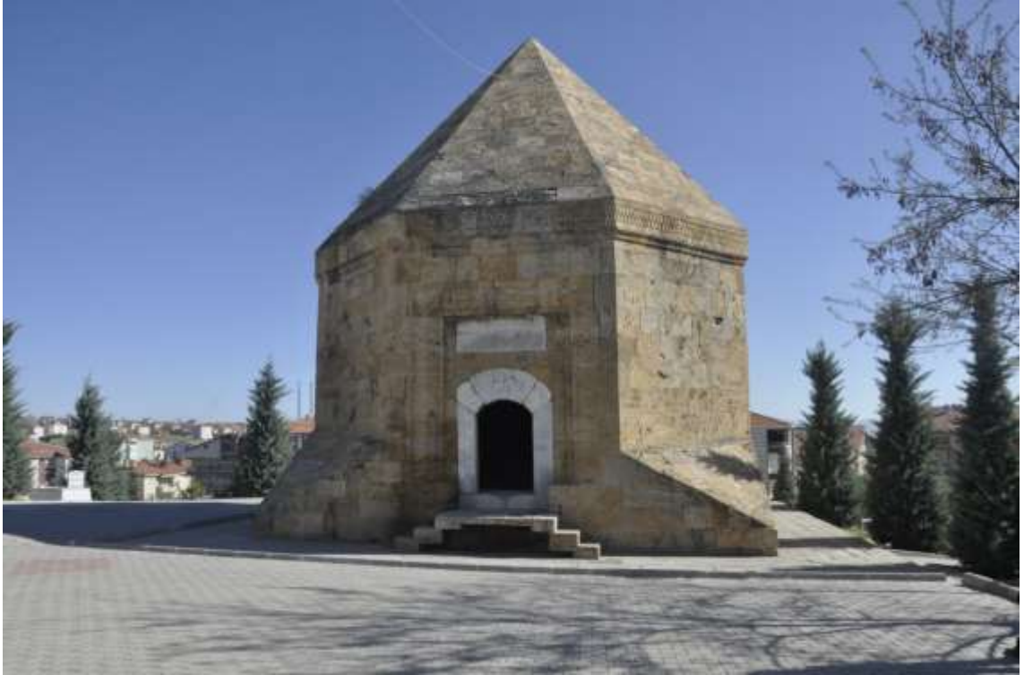
Görsel 2.119. Fatma Hatun Türbesi genel görünüm
