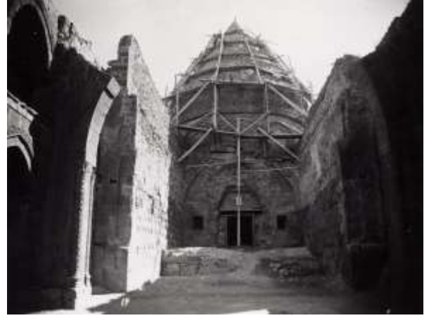
Görsel 2.162. Türbenin onarım öncesi görünümü
