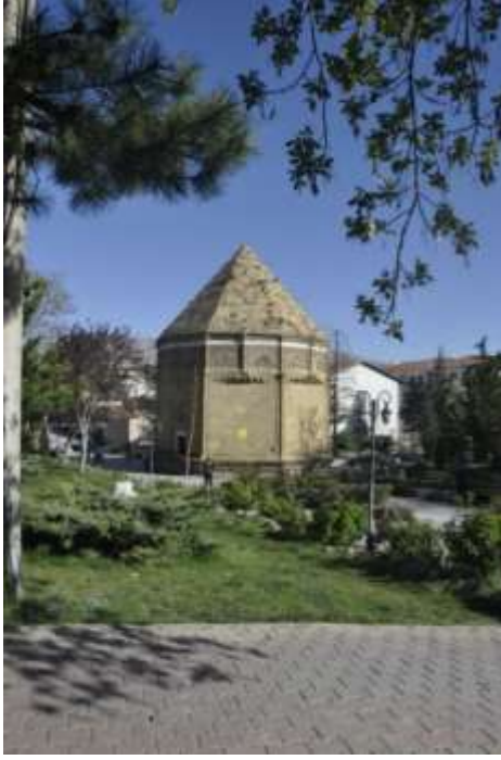
Görsel 2.138. Tümenin kuzeybatı cepheden görünüşü ve konumu
