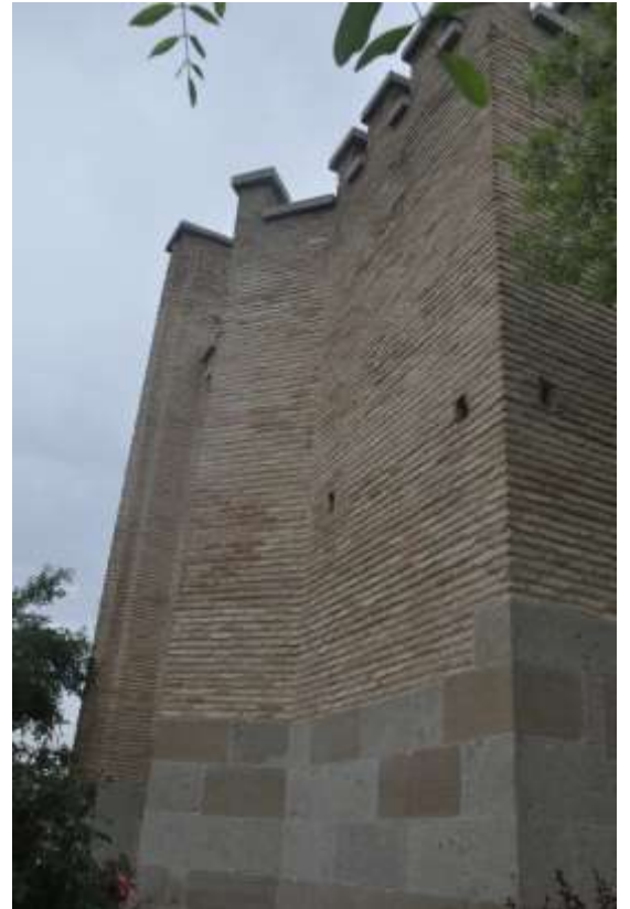
Görsel 2.38. Doğu ve batı cephede bulunan üçgen kesitli payanda işlevinde çıkıntılar
