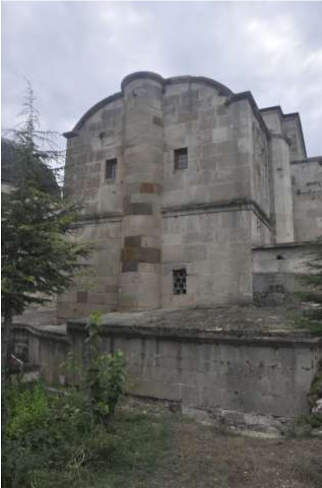
Görsel 2.18. Batı cephedeki çokgen kesitli payanda
