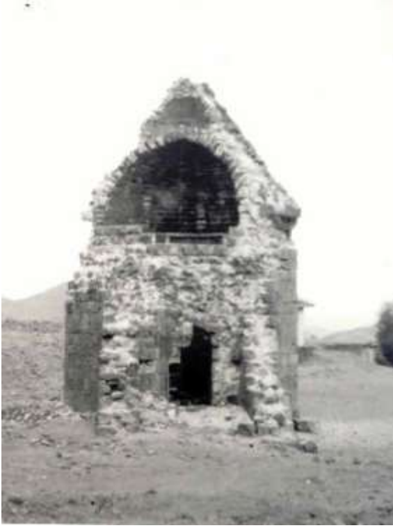
Görsel 2.152. Elti Hatun Türbesi onarım öncesi durumu
