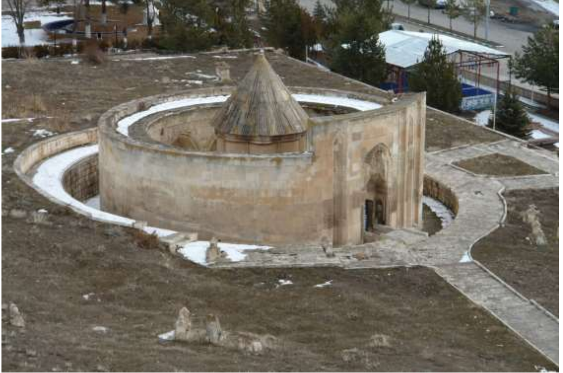
Görsel 2.216. Mama Hatun Türbesi genel görünüm (Erzurum Vakıflar Bölge Müdürlüğü Arşivi, 2017)
