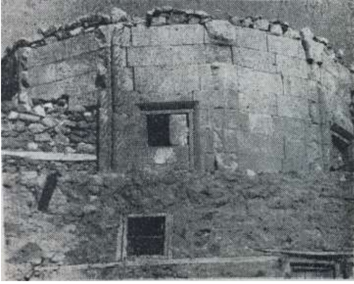
Görsel 2.198. Türbenin onarım öncesindeki durumu (Konyalı, 1960, 418)
