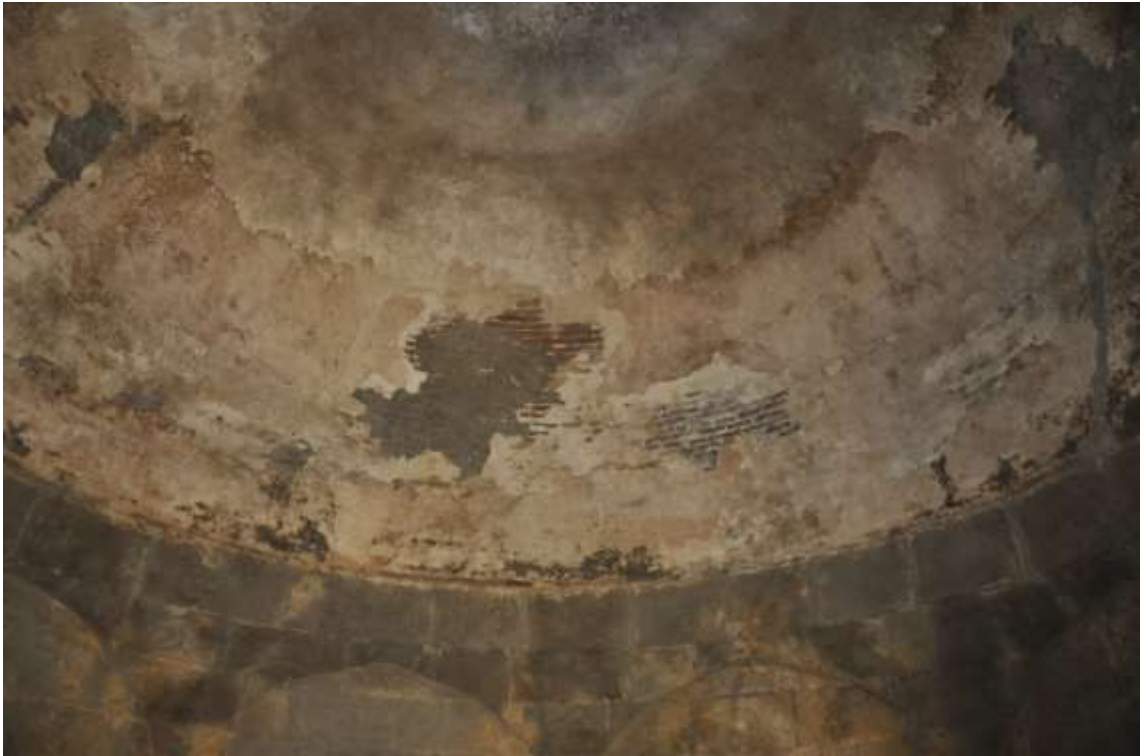
Görsel 2.129. Kubbeye geçiş ve kubbe eteği
