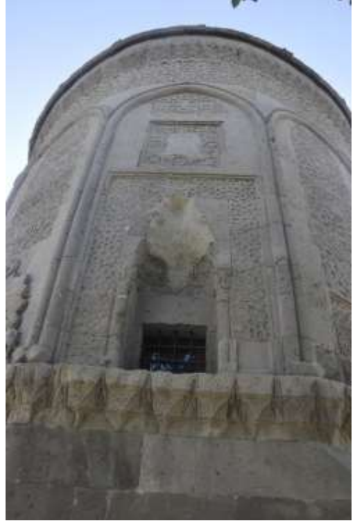
Görsel 2.191. Kuzeydoğu cephe
