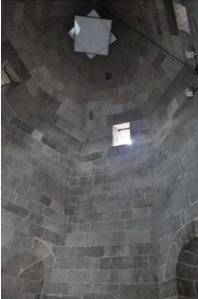
Görsel 2.75. Yarım daire ve dikdörtgen kesitli nişler
