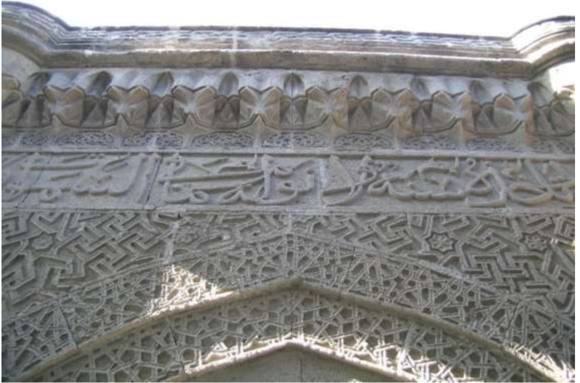
Görsel 2.107. Güney cephenin üst kısmı
