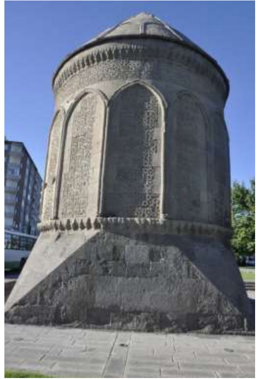
Görsel 2.189. Güney cephenin güneybatı ve güneydoğuya bakan cephesi, güneydoğu cephe ve güneydoğu cephenin doğuya bakan cephesi
