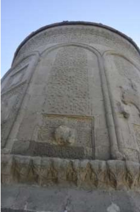
Görsel 2.192. Kuzeydoğu cephenin kuzeye bakan cephesi
