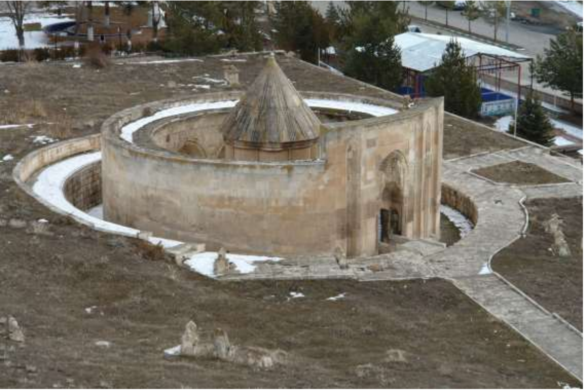
Görsel 2.228. Türbeyi çevreleyen avlu duvarının üstünde yürüme alanı oluşturacak dolaşım alanı (Erzurum Vakıflar Bölge Müdürlüğü Arşivi)
