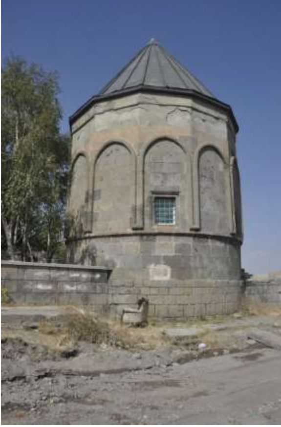
Görsel 2.200. Türbenin güneydoğu cephesi
