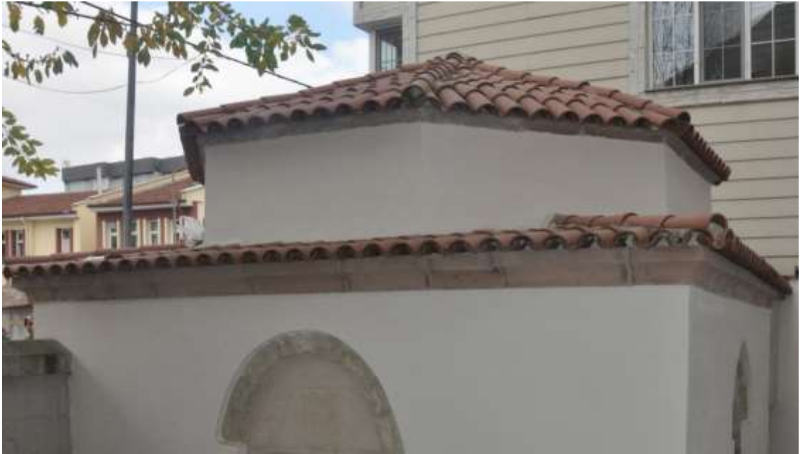
Görsel 2.244. Saçak, sekizgen prizma kasnak ve konik külâh görünümü
