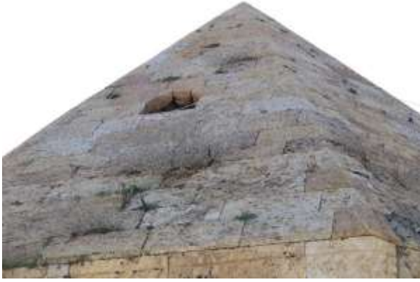
Görsel 3.29. Fatma Hatun Türbesi külâhının doğusunda bulunan basık kemerli açıklık
