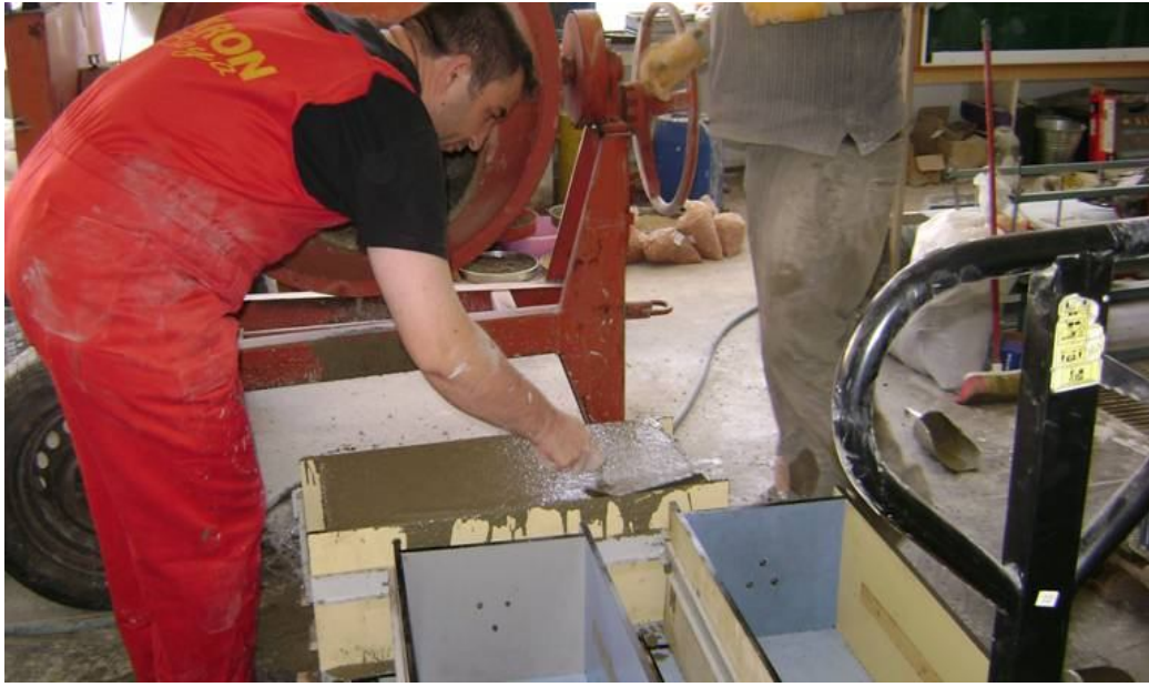
Şekil 6.3. Kiriş kalıplara beton dökümü
