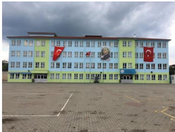
Görsel 2.1. Okul binasının bahçeden görünümü
