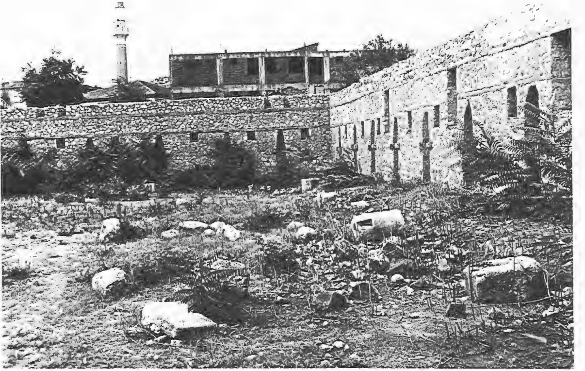
Resim:29 Vezirhan, güney mekanda bulunan devşirme malzemeler
