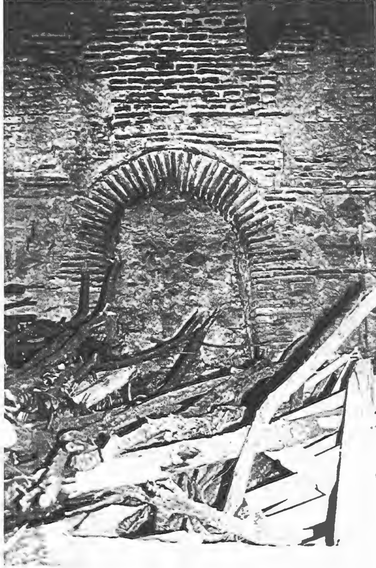
Resim:53 Taş Han, giriş bölümünün batı duvarında bulunan ocak nişi
