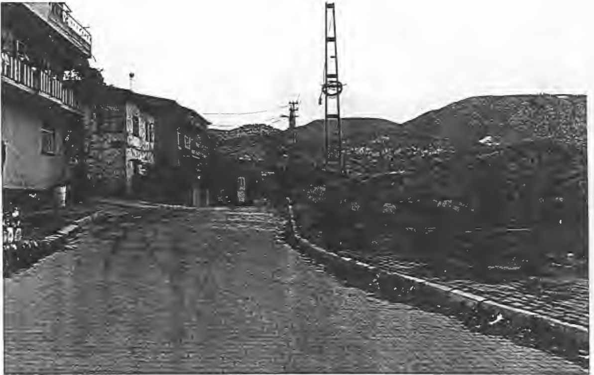
Resim:17 Vezirhan, doğu cephe genel görünüm
