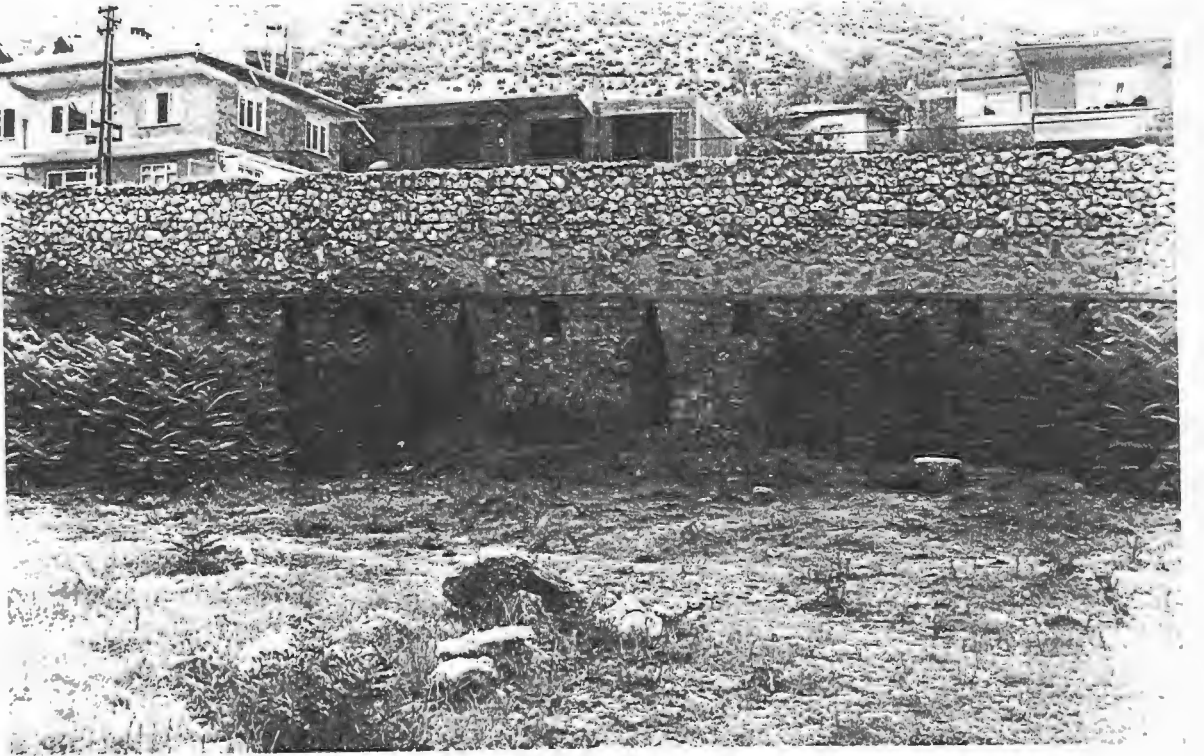
Resim:27 Vezirhan, güney mekan doğu duvar
