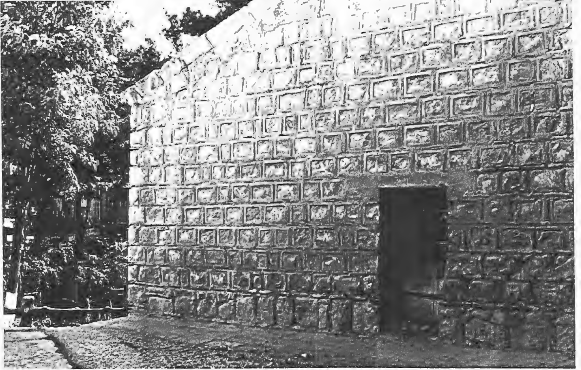
Resim:61 Taş Han, kuzey ephe duvar örgüsü
