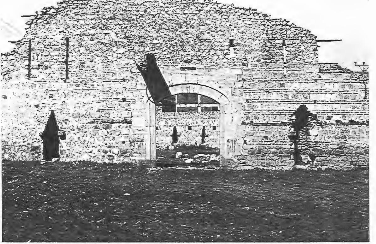
Resim:20 Vezirhan, orta bölüm, güney duvar
