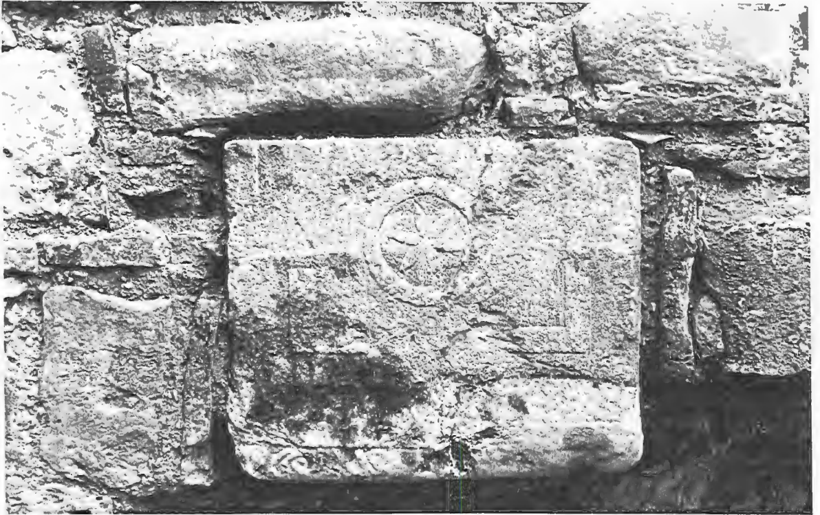
Resim:49 Taş Han, güneycepede bulunan devşirme malzeme
