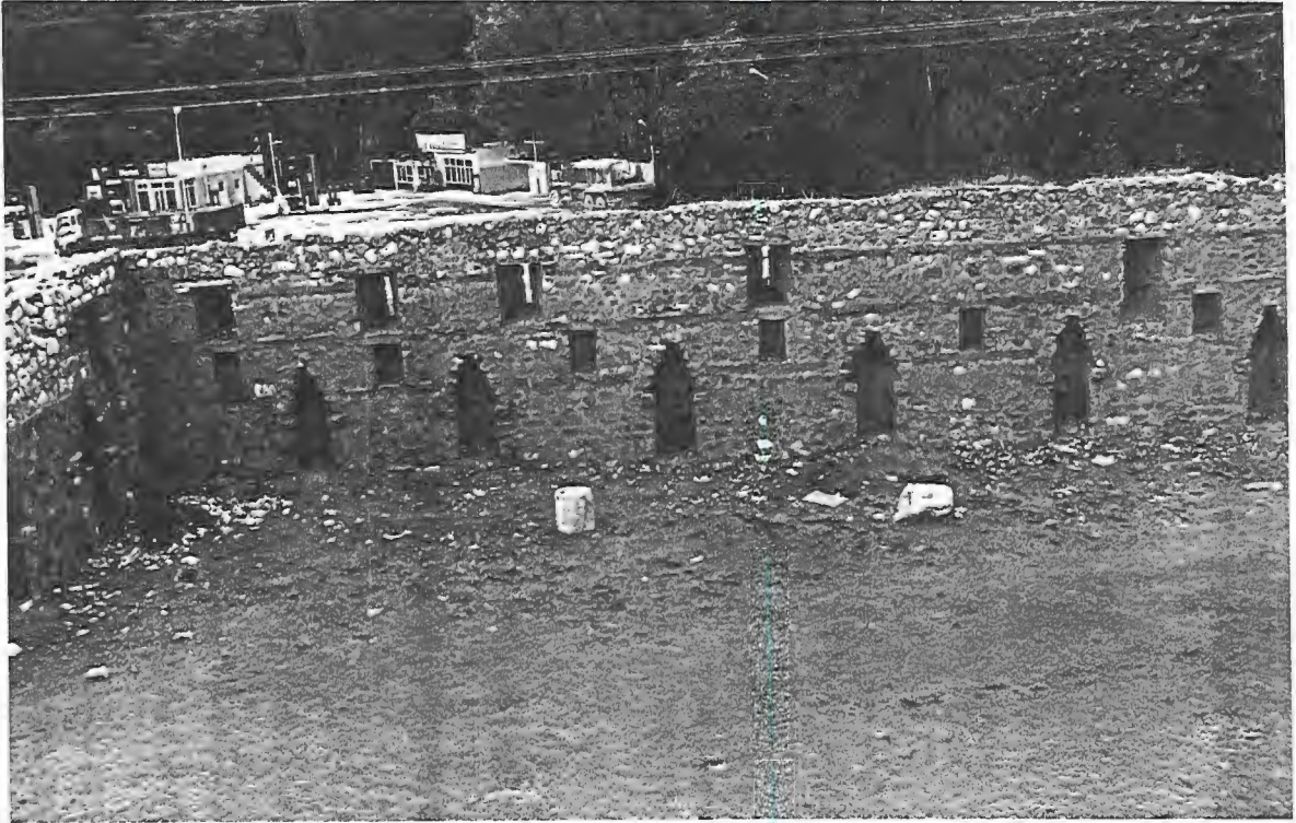
Resim:33 Vezirhan, kuzey mekan, batı duvara bakış
