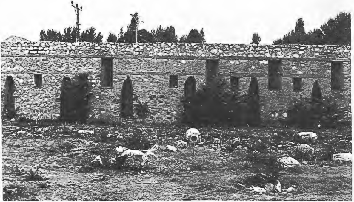
Resim:24 Vezirhan, güney mekan batı duvar
