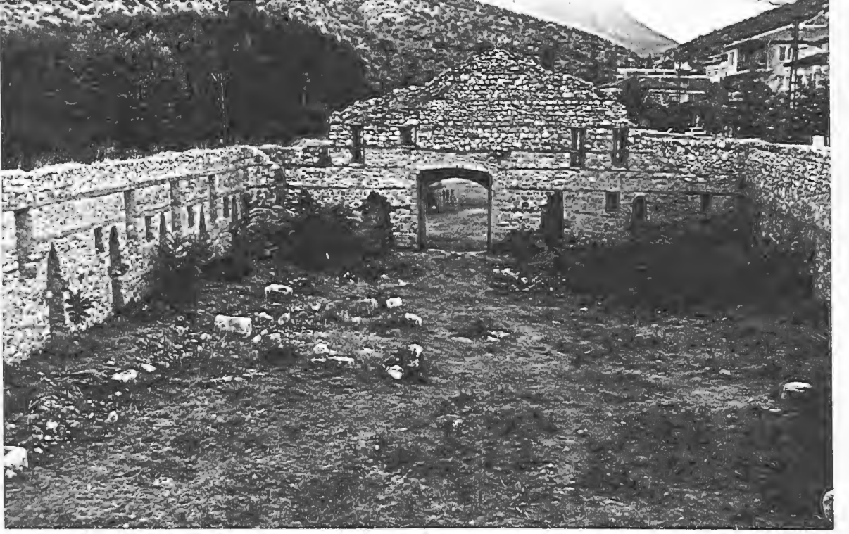
Resim:28 Vezirhan, güney mekan, kuzey duvar
