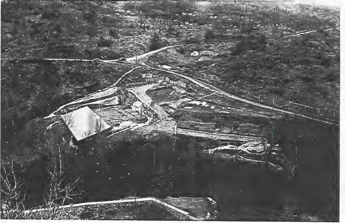
Resim:3 Büyük Kervansaray, onarım sonrası genel görünüm
