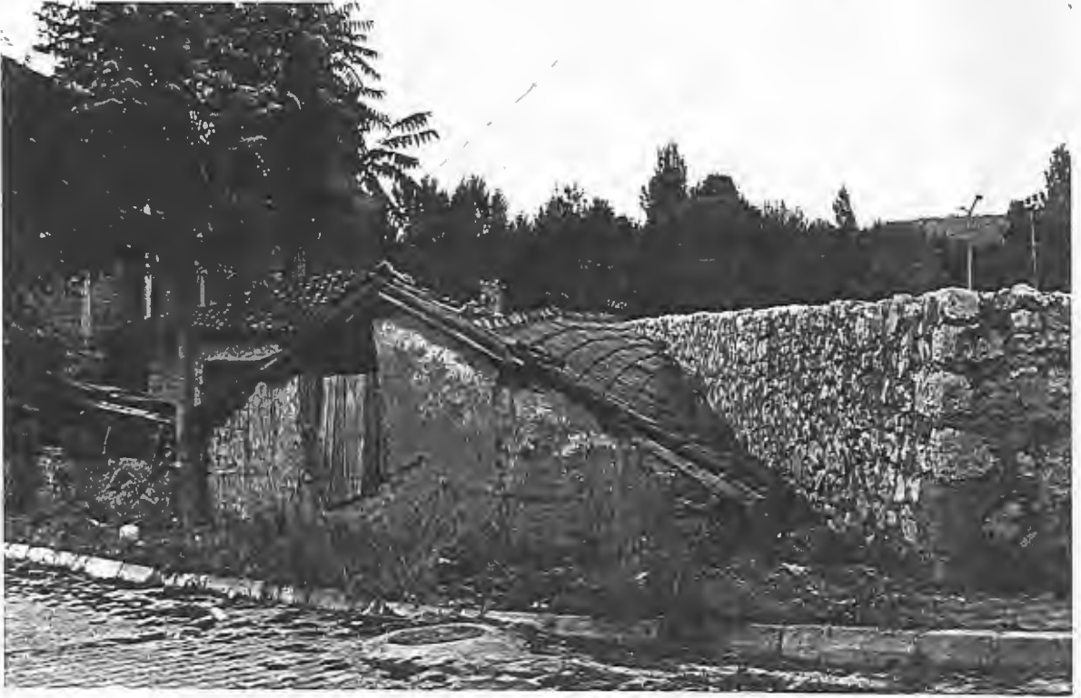
Resim:16 Vezirhan, güney cephe genel görünüm
