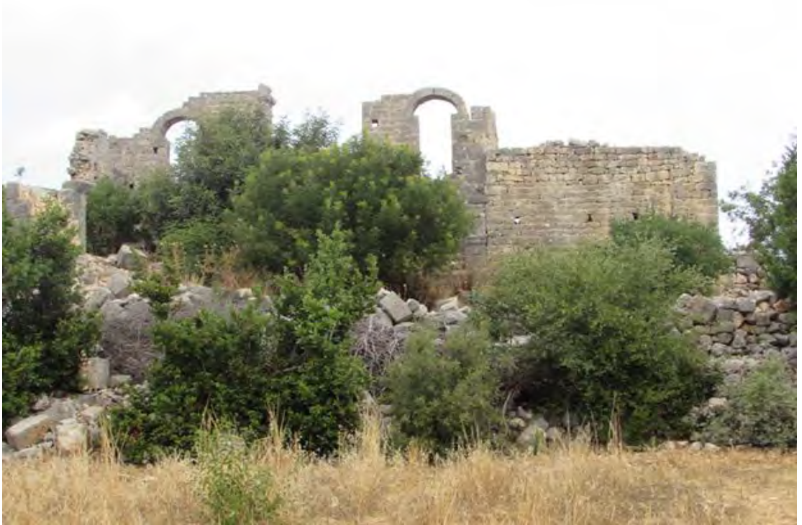
Resim 23. Işıkkale Kilisesi Batı Cepheden Genel Görünüş
