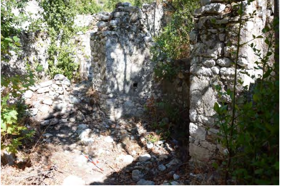
Resim 83. Olympos Piskoposluk Kilisesi Genel Görünüşü
