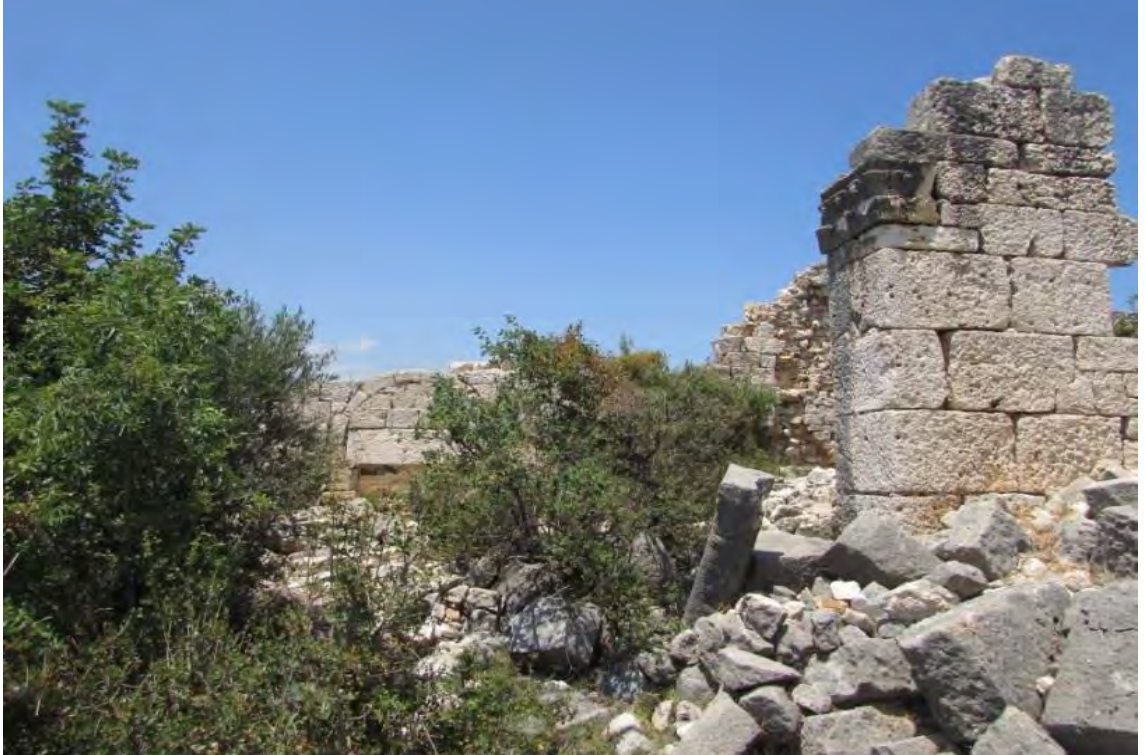
Resim 29. Korykos Mezar Kilisesi Malzeme-Teknik Kullanımı
