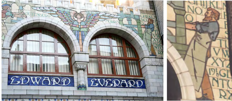
Resim 47. Everard Binası, Art Nouveau Stilinde Çok Renkli Fayans (Carraraware) Kaplı Cephe, İngiltere, Bristol, 1900
