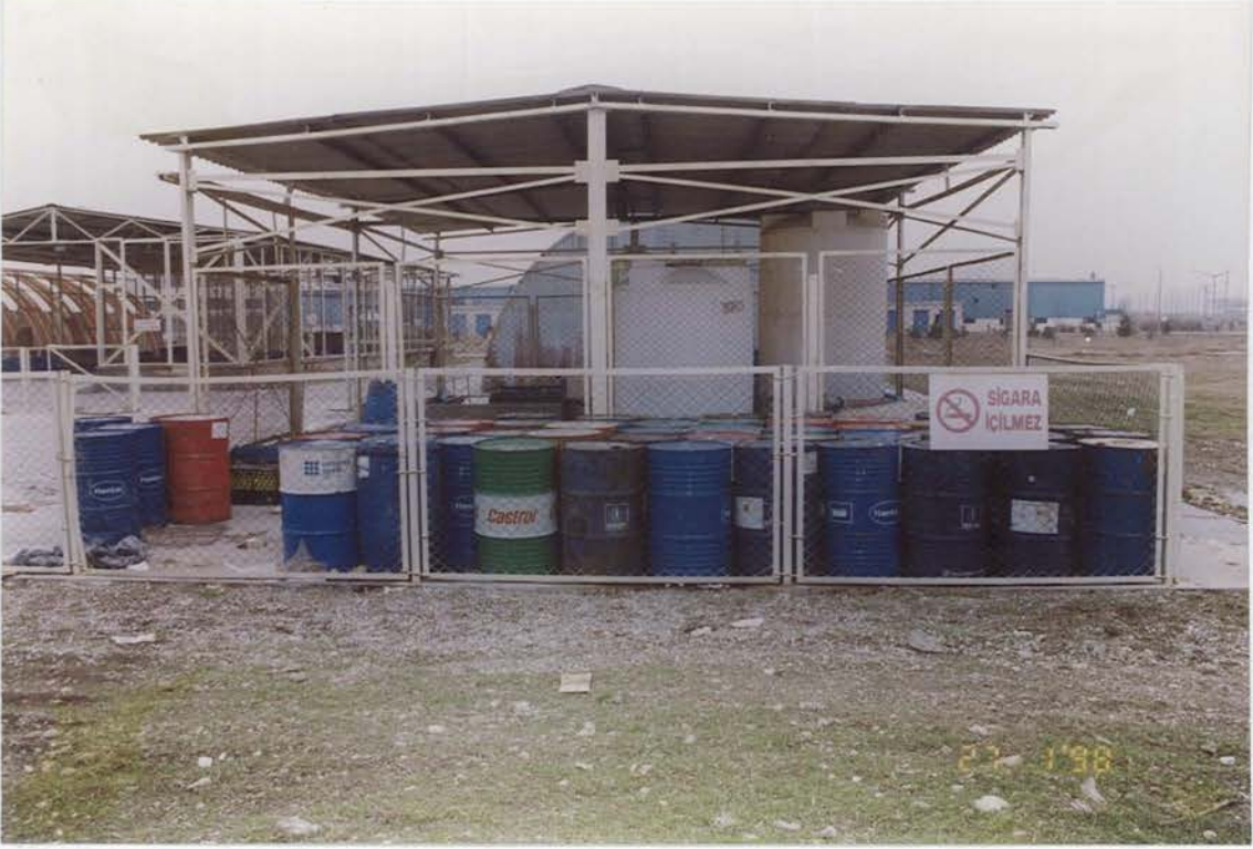
Şekil EK 2.4. TEI yağ ve atık kimyasalları depolama sahası
