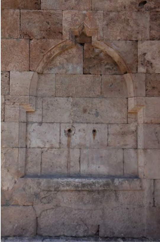
Resim 84. Mahperi Hatun Hanı Giriş Cephesi Çeşme Kuruluşu
