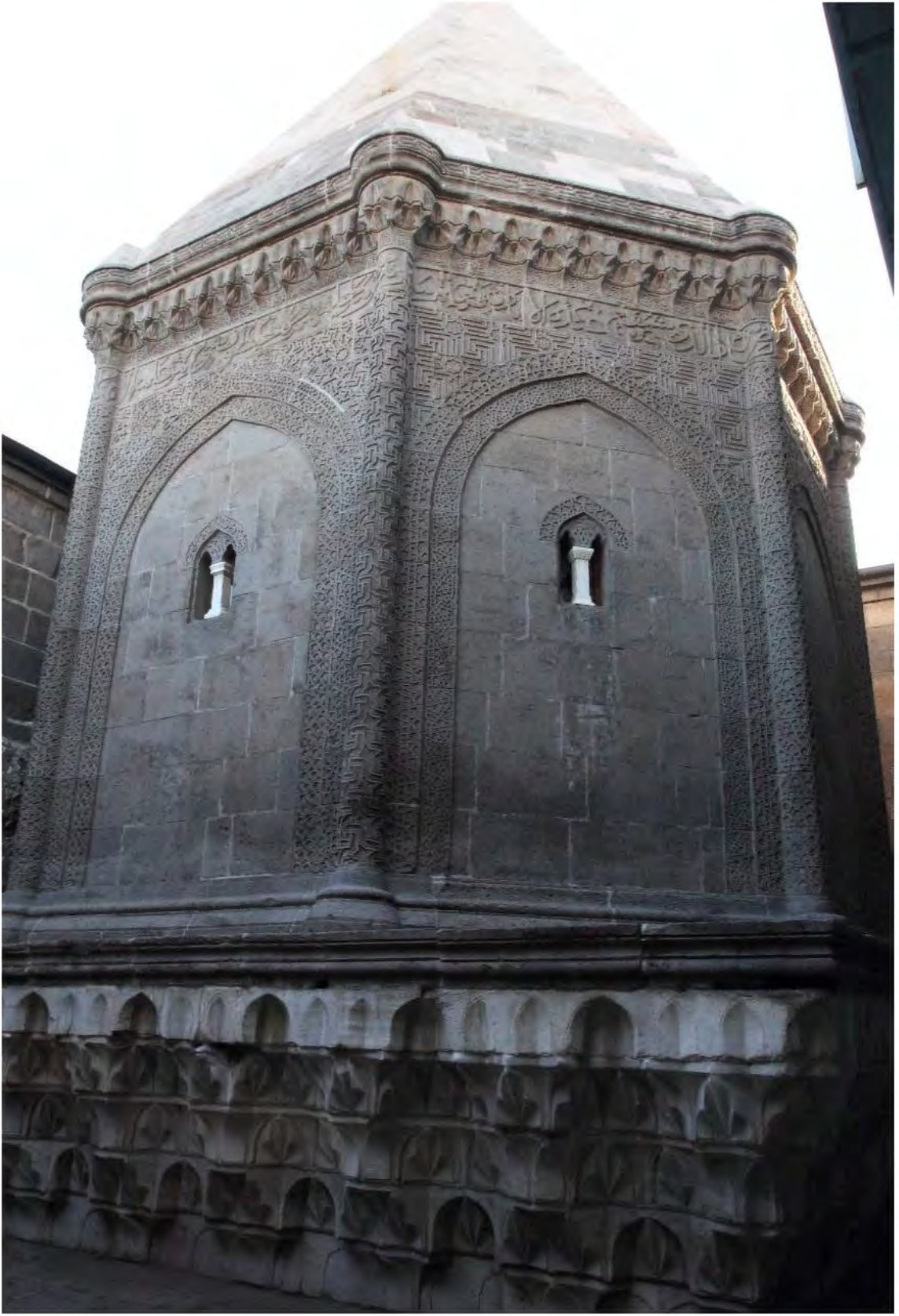
Resim 27. Mahperi Huand Hatun Türbesi Batı Ve Güneybatı Cepheler
