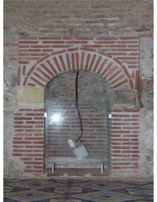
Resim 100. Ezinepazar Hanı Kuzey Duvarı Ocak Nişli Detayı
