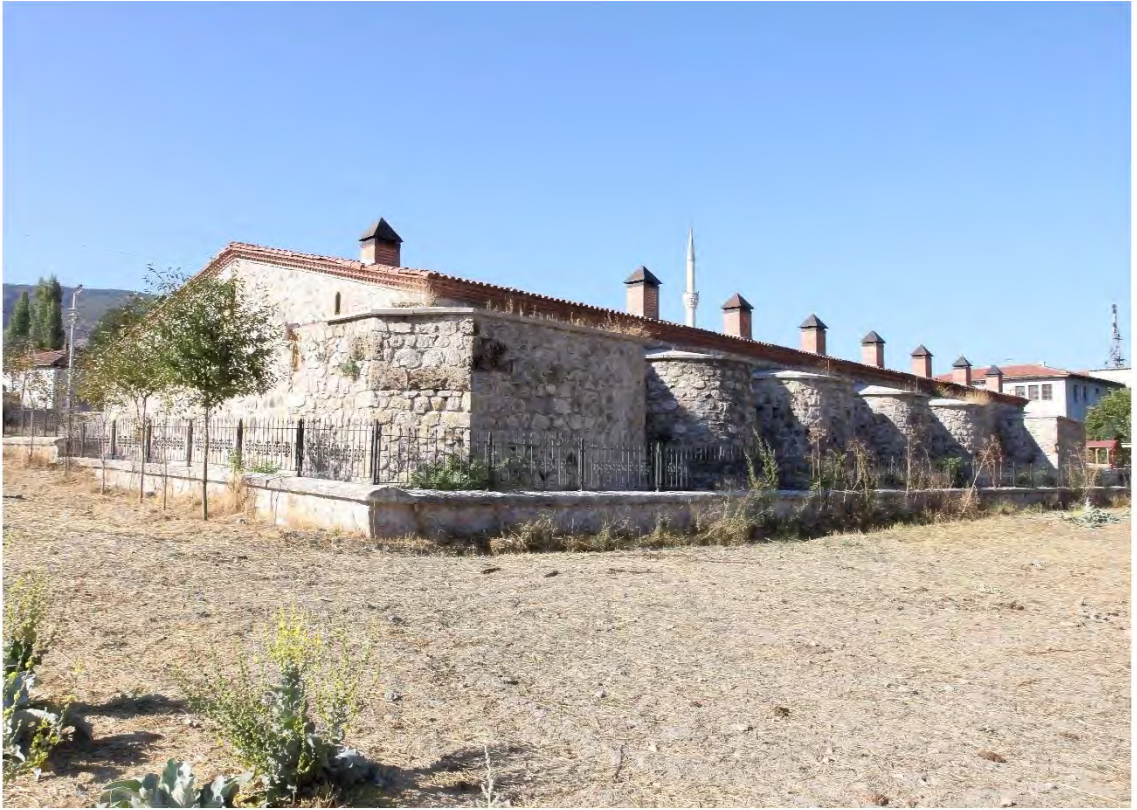
Resim 95. Ezinepazar Hanı Güney Cephe
