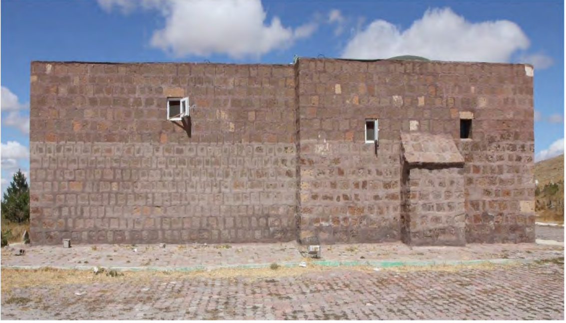
Resim 62. Şeyh Turesan Zaviyesi Güney Cephe
