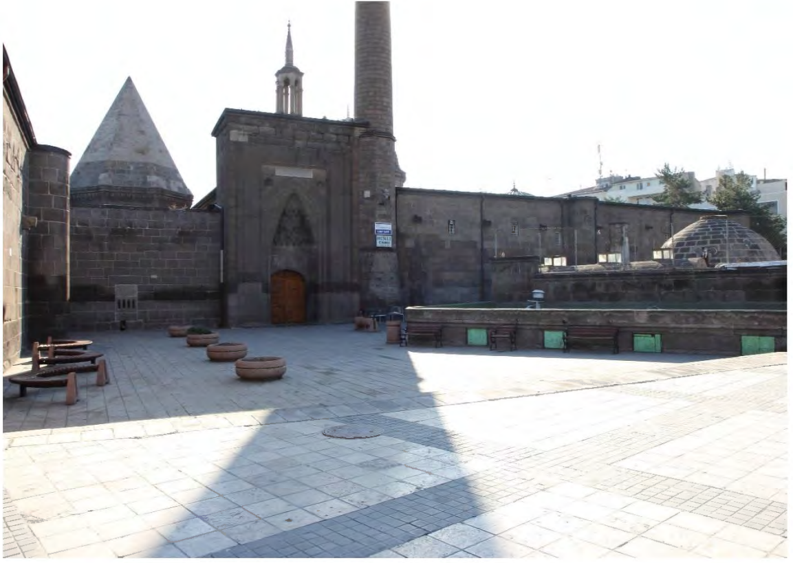
Resim 14. Mahperi Huand Hatun Camii Batı Cephe Ve Batı Portal
