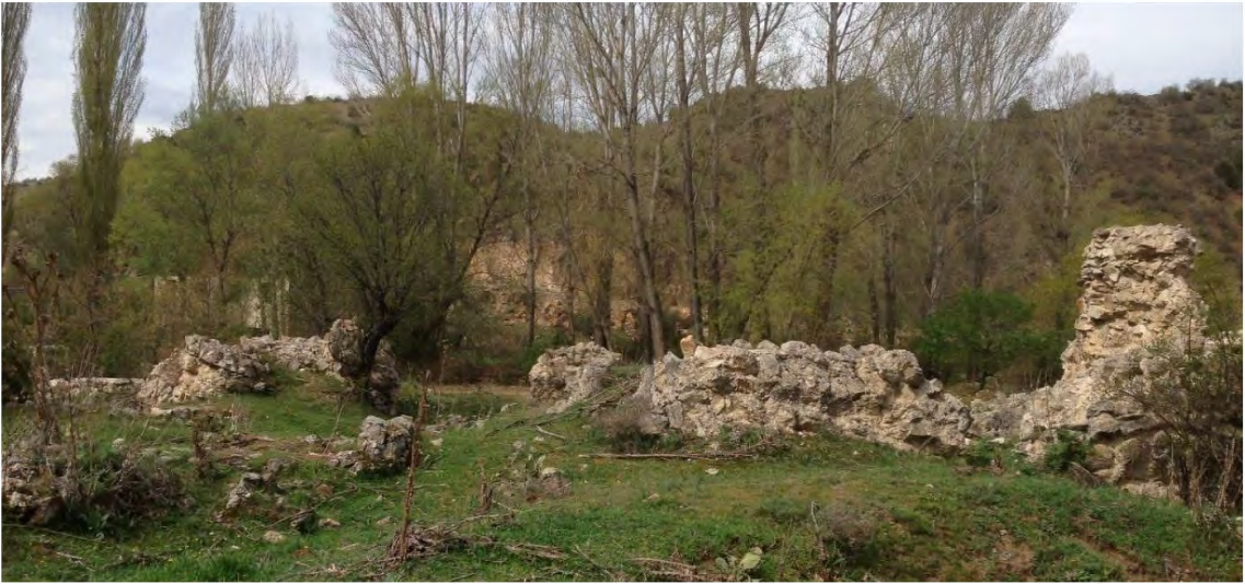
Resim 108. Çınçınlı Sultan Hanı Avlu Bölümünden Kalıntılar
