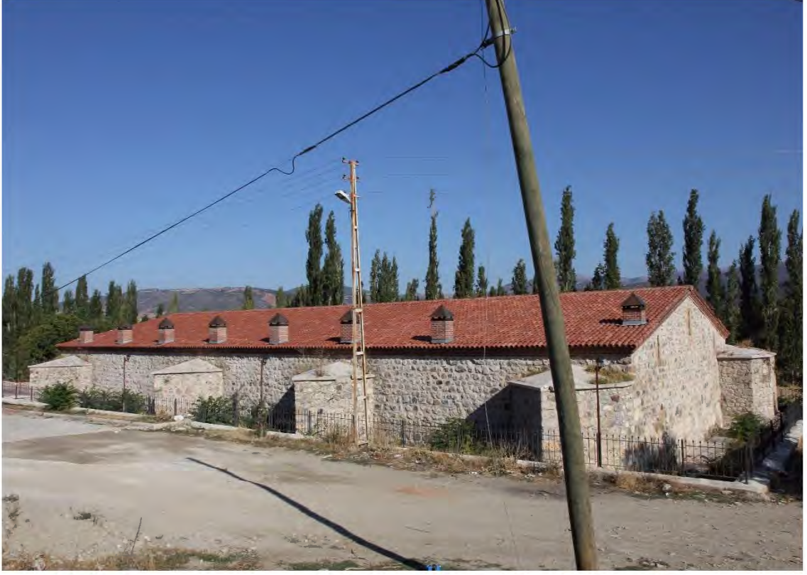
Resim 94. Ezinepazar Hanı Kuzey Cephe
