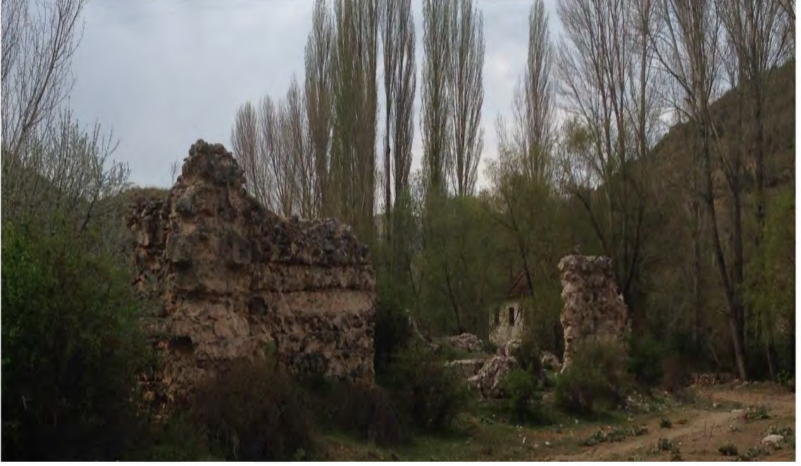
Resim 107. Çınçınlı Sultan Hanı Güney Cephe Ve Payanda Kalıntısı
