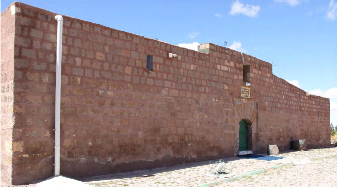
Resim 60. Şeyh Turesan Zaviyesi Doğu Cephe
