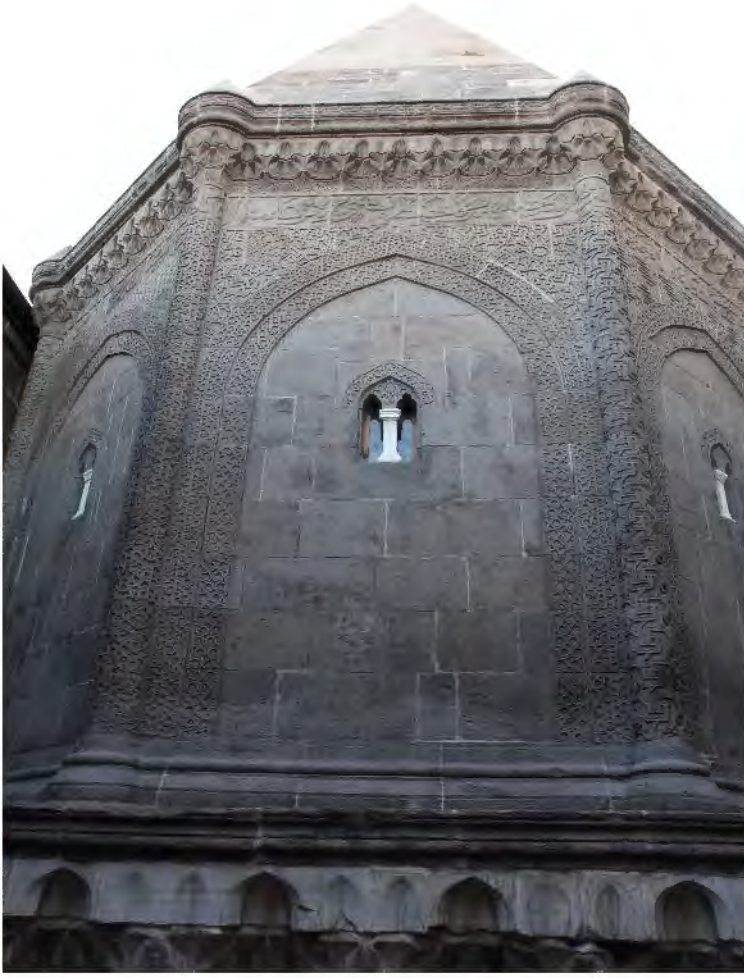
Resim 32. Mahperi Huand Hatun Türbesi Batı Cephe
