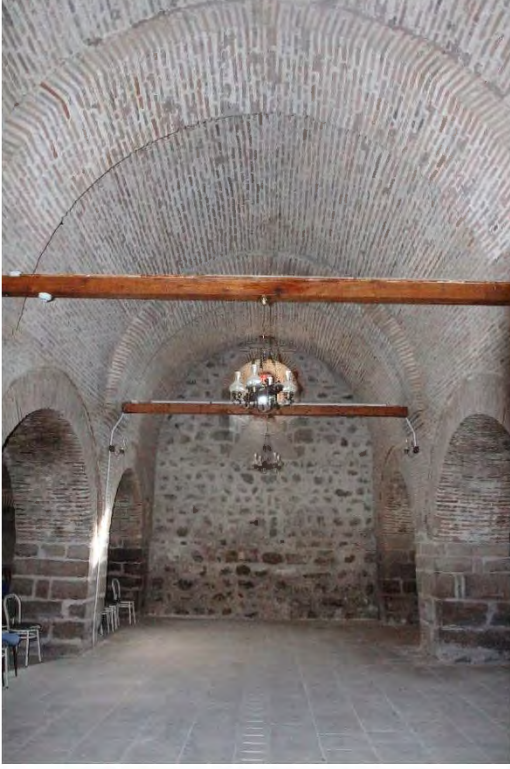
Resim 98. Ezinepazar Hanı Orta Sahından Batıya Bakış, Tonoz Ve Takviye Kemerleri
