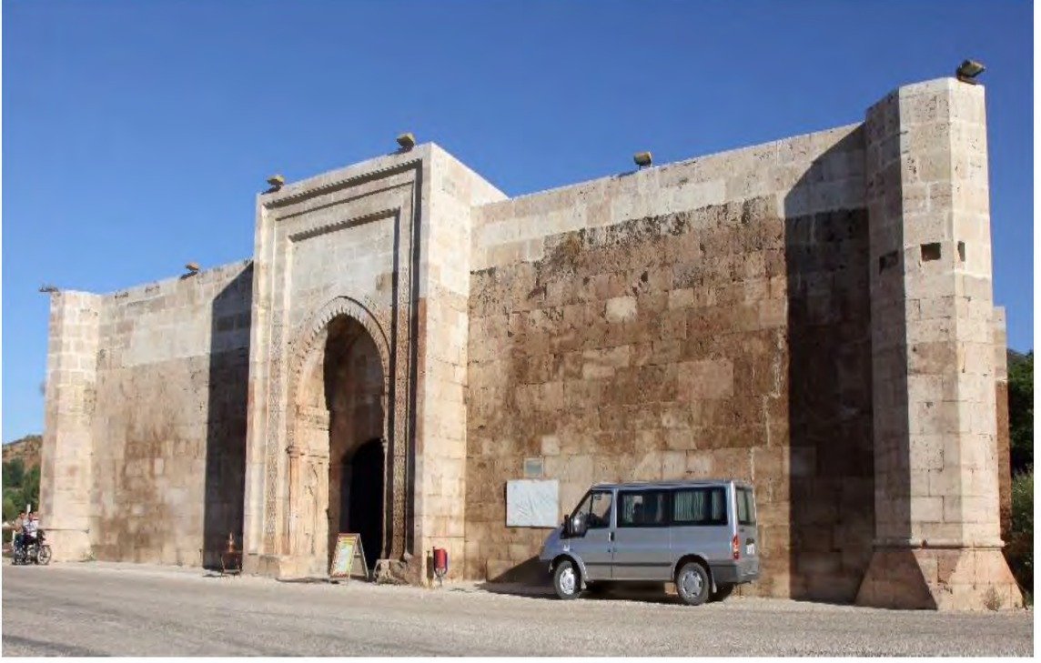
Resim 81. Mahperi Hatun Hanı Avlu Giriş Cephesi Ve Portalı
