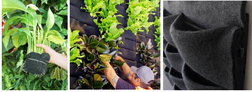
Görsel 3.12. Keçe katmanında bitkilendirme ( http-13 )
