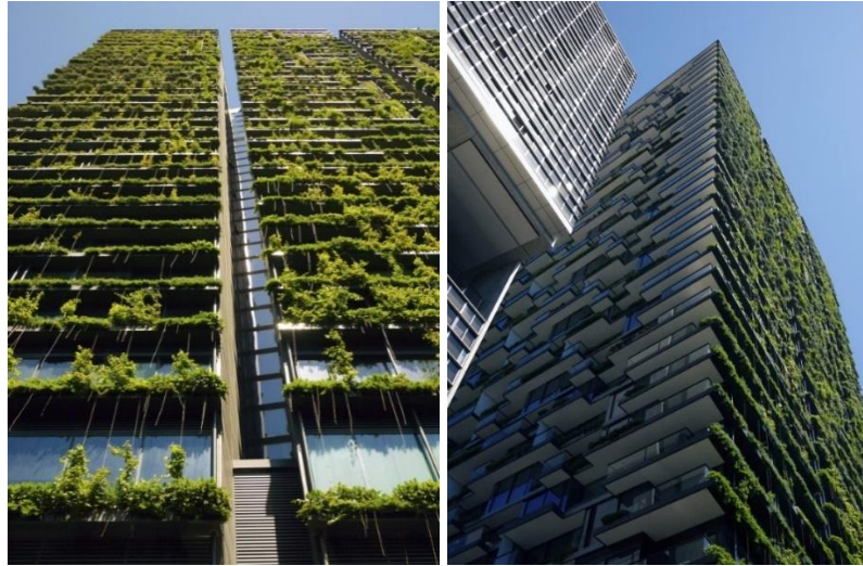
Görsel 5.16. OCP bina cephesinin %50 sini kaplayan dikey yeşil sistem ( http-64 )
