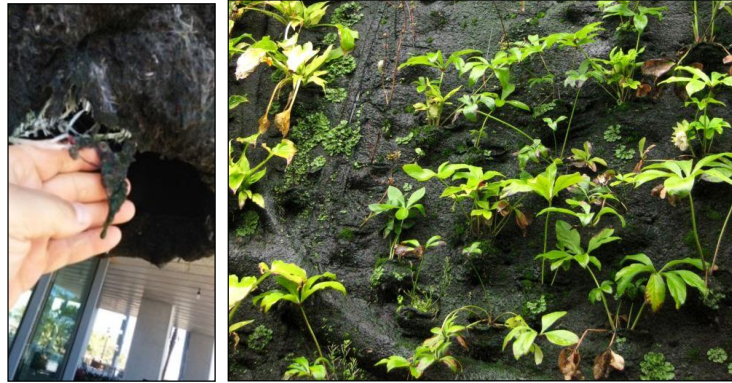
Görsel 2.5. a)Yosun bulguları gösteren malzeme bozulmasının kök seviyesinde oksijen eksikliğine katkıda bulunması. b)Ařırı sulamanın etkileri (http-18)
