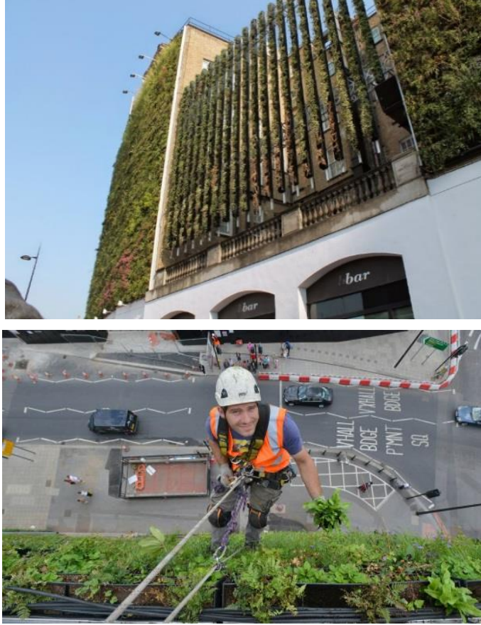
Görsel 5.6. a) Yaşayan duvar ( http-66 ) b) Sulama boruları ve altkatman ( http-48 )
