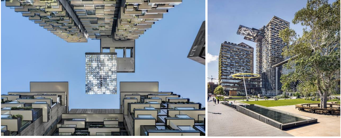
Görsel 5.17. a) Reflektör panelleri ve iki kulenin birbirine bakan cepheleri ( http-55 ) b) Güney cephe ( http-64 )
