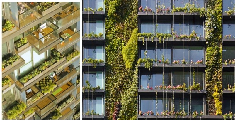
Görsel 5.15. OCP Binası cephe görünümü ( http-55 ve http-57 )
