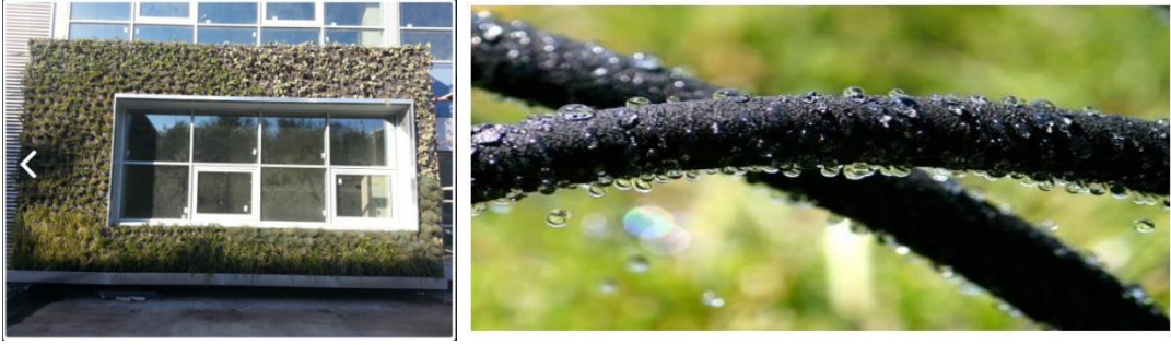
Görsel 3.19. Terbo sistemleri ile kurulmuş dikey yeşil sistem ve Terbo boru detayı (http-35)
