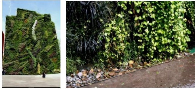
Görsel 5.2. a)Yaşayan duvardan görünüm (http-80) b)Zemin kotunda suyun toplandığı kısım (http-51)
