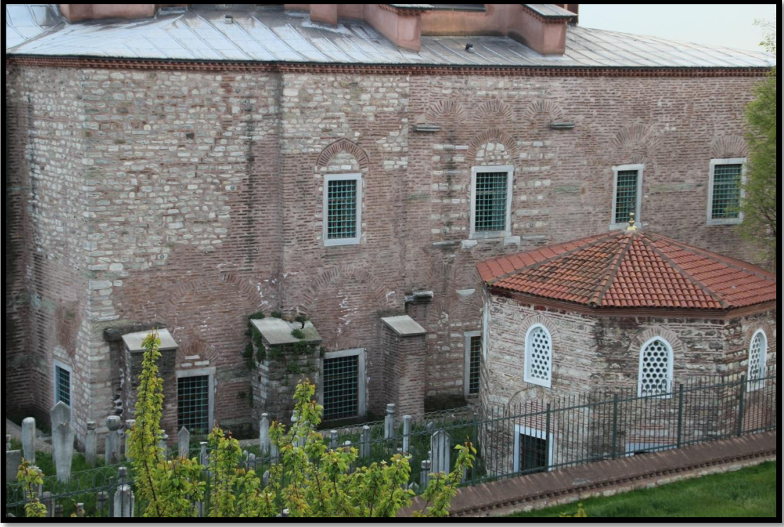
Görsel 5.23. Yapının Kuzey Cephesinde Görülen Malzeme Farklılığı
