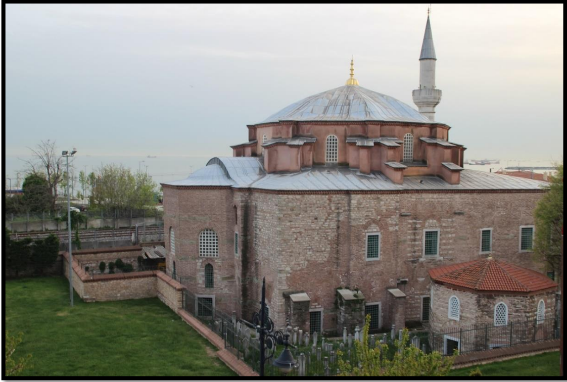
Görsel 5.2. Yapının Kuzeydoğu Yönünden Görünümü
