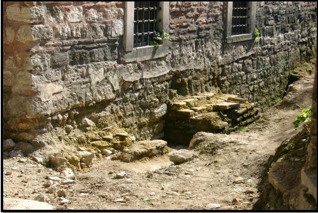
Görsel 5.15. Güney Cephede Kazı Sırasında Ortaya Çıkarılan Azizler Petrus ve Paulos Kilisesi'ne Ait Olduğu Düşünülen Temel Duvarları (M. M. Gökçay, 2013)
