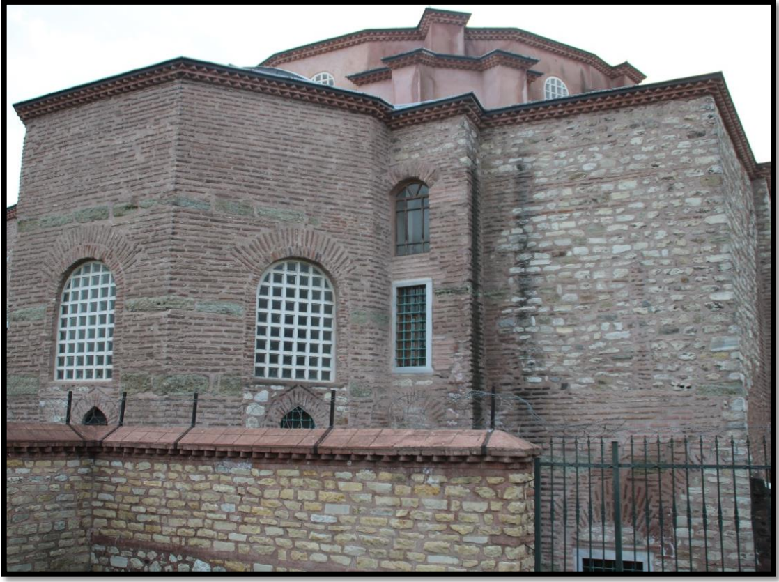
Görsel 5.13. Doğu Cephenin Kuzey Yönündeki Duvarda Görülen Malzeme Farklılığı
