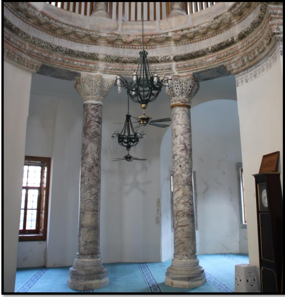
Görsel 5.44. Kuzeydoğu Eksedradaki Entablatürde Karşılaşılan Birleşim Yerleri
