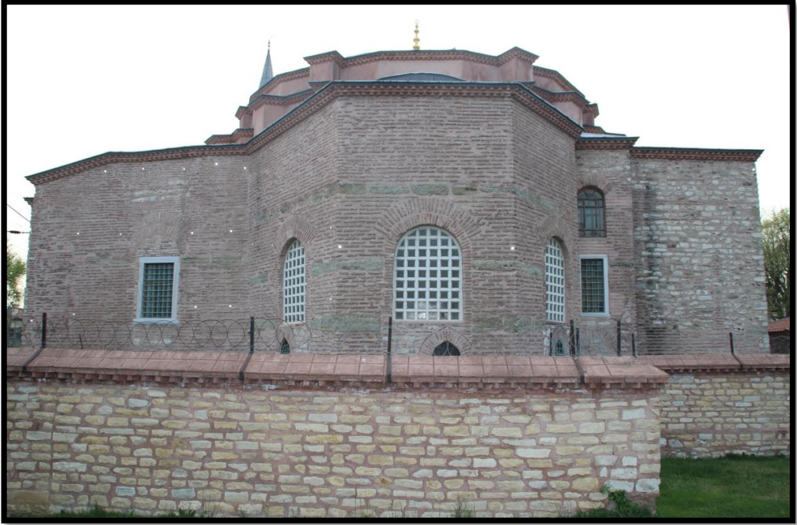
Görsel 5.11. Yapıda Apsisin Yer Aldığı Doğu Cephelin Görünümü
