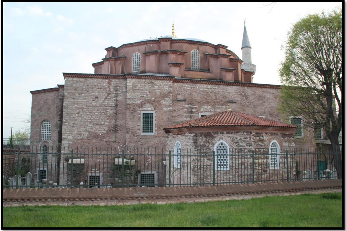
Görsel 5.6. Yapının Kuzey Cephesinden Görünüm
