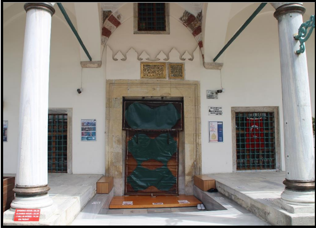
Görsel 5.5. Yapının Batı Cephesinde Yer Alan Kapı
