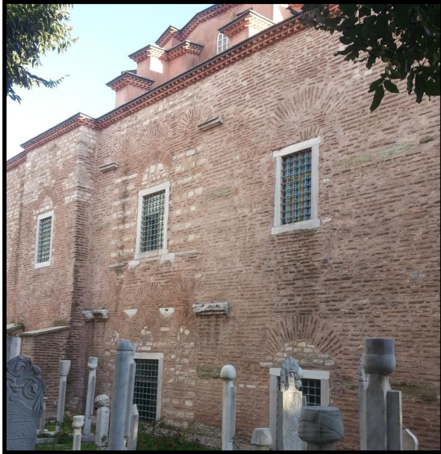
Görsel 5.8. Kuzey Cepheye Görülen Üçlü Arkad, Kornişler ve Tuğla Kemer İzleri
