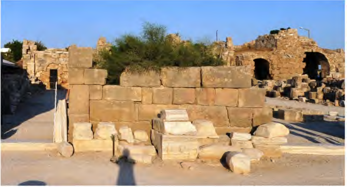
Resim 128. AA Bazilikası Batı Duvar
