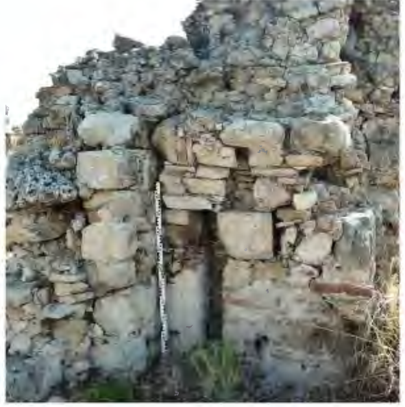
Resim 78. Piskoposluk Sarayı 5b Yapısı Doğu Duvar Kuzey Künk Yuvası
