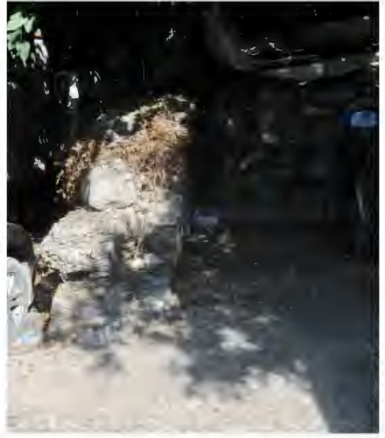
Resim 170. bb Kilisesi Güney Transept Kolu Köşesi
