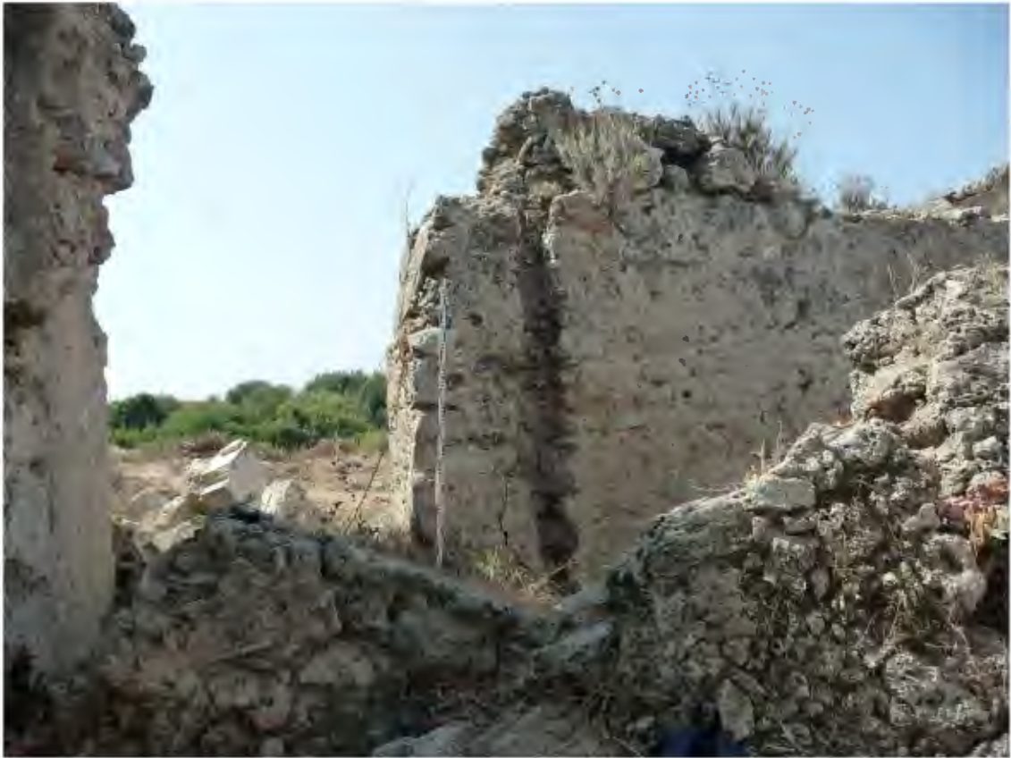
Resim 251. Piskoposluk Sarayı 6b mekanı güney duvar
