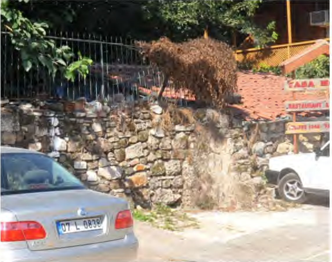
Resim 171. bb Kilisesi Güneybatı Köşe
