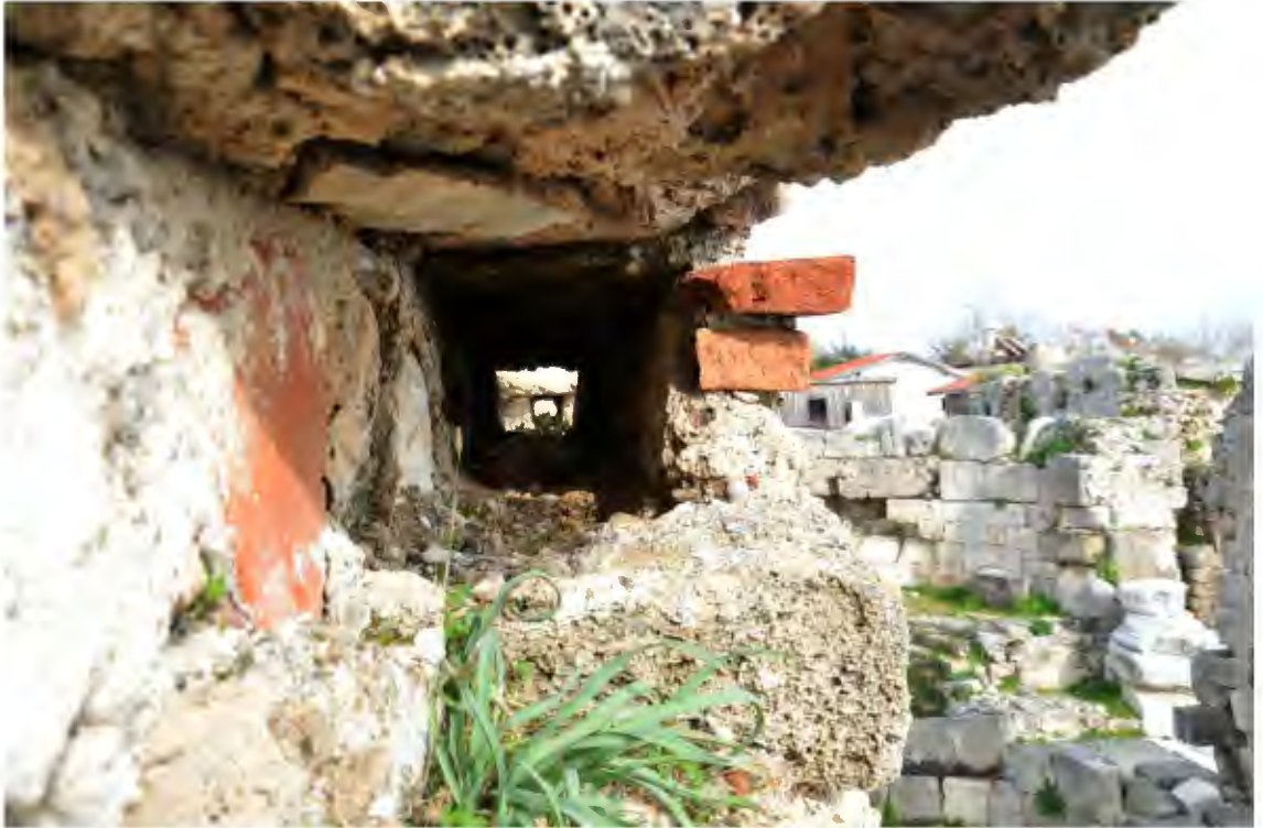
Resim 343. Kucuk Liman Kilisesi kuzey duvar hatıl yuvası detay
