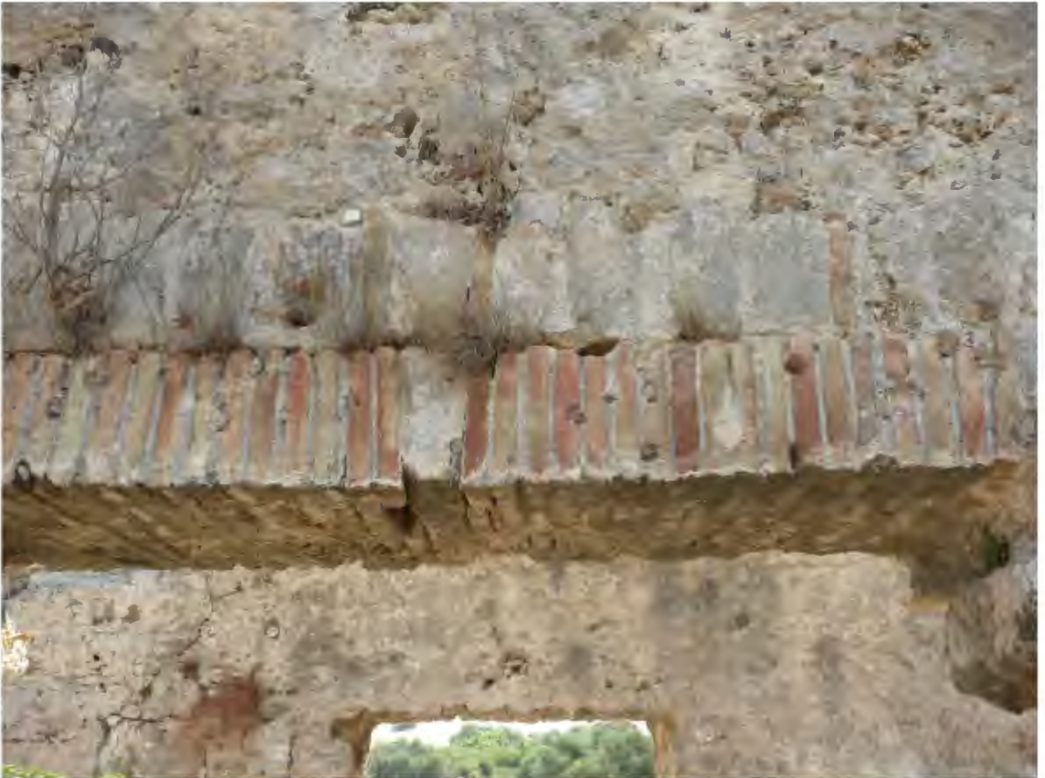
Resim 91. Piskoposluk Sarayı 6b Yapısı Batı Kapısı Lentosu
