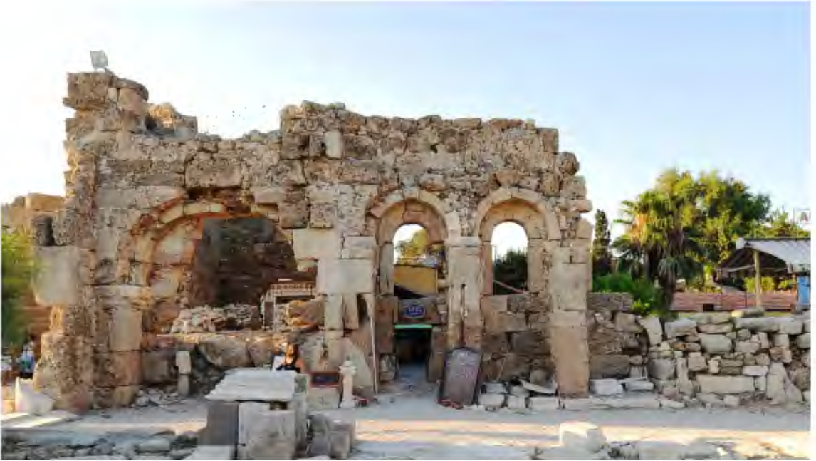
Resim 118. AA Bazilikası Narteks Kuzey Ek Mekanı
