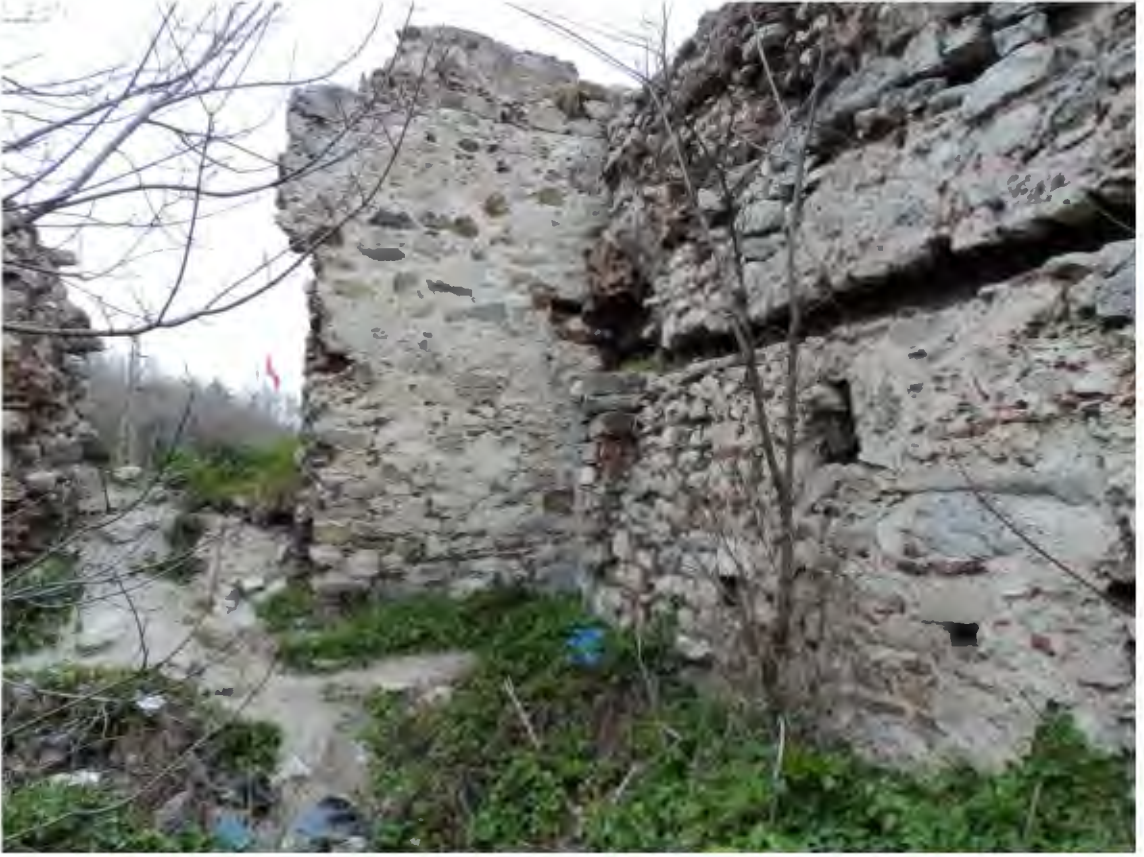
Resim 344. Konstantinopolis deniz surları T6 kulesi hatıl yuvası
