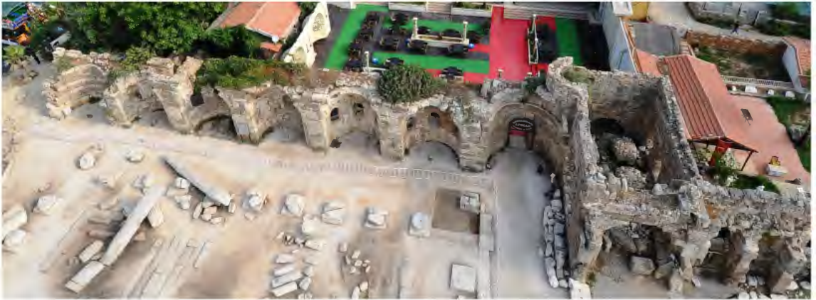
Resim 129. AA Bazilikası Atrium Kuzey Duvar
