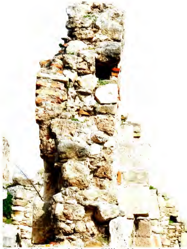
Resim 342. Kucuk Liman Kilisesi kuzey duvar hatıl yuvası
