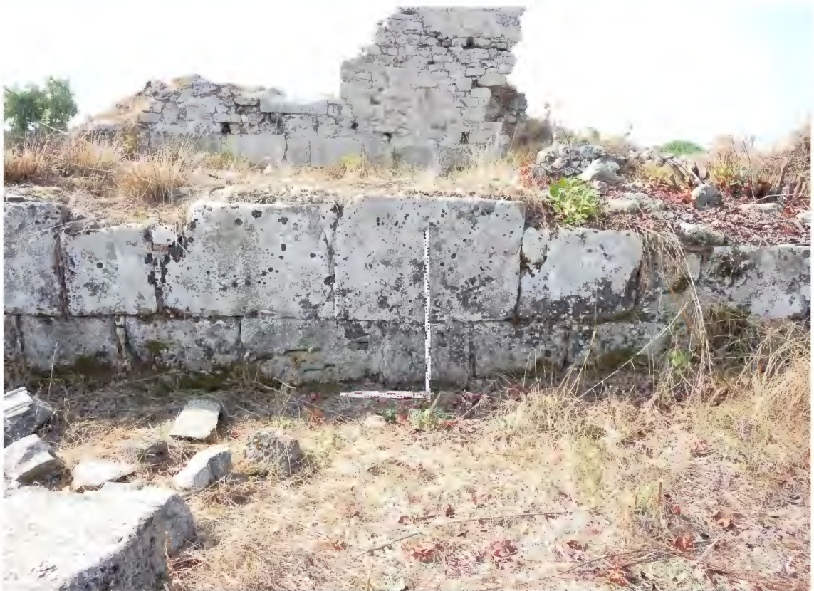
Resim 17. Piskoposluk Sarayı kilisesi Kuzey İç Duvar
