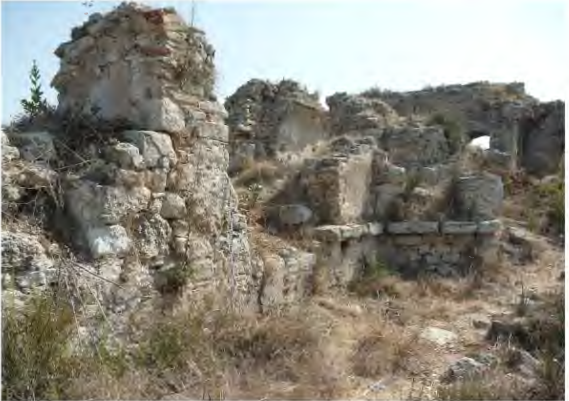
Resim 76. Piskoposluk Sarayı 5b Yapısı Güney Cephe
