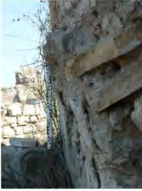
Resim 254. Piskoposluk Sarayı 6b güney mekanı dış tonozu
