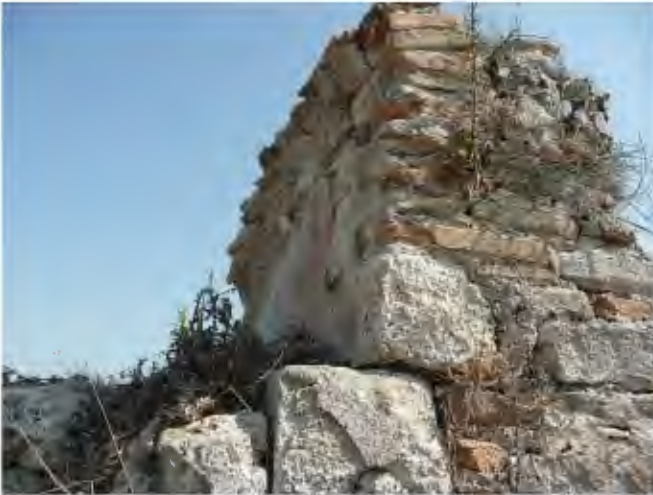
Resim 80. Piskoposluk Sarayı 5b Yapısı Batı Mekan tonozu
