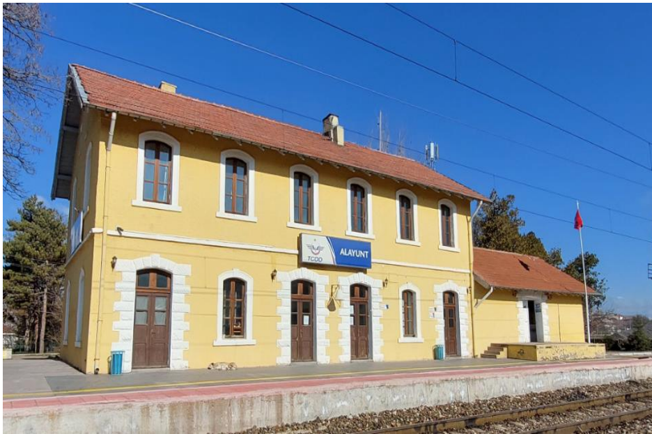
Görsel 132. Alayunt Tren İstasyon Binası Doğu Cephe
