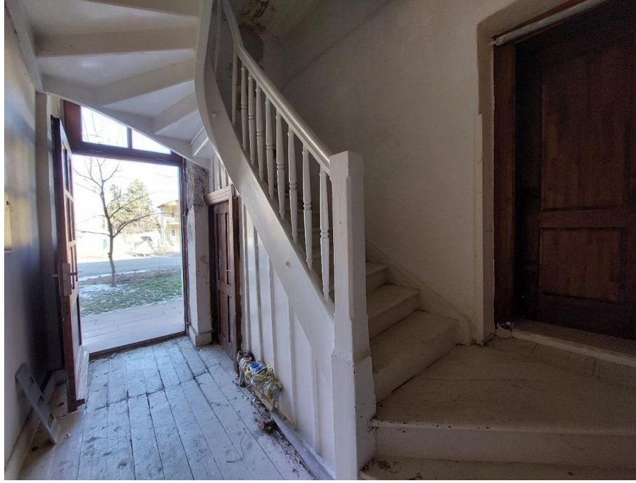
Görsel 130. Alayunt Tren İstasyon Binası Üst Kata Ulaşımı Sağlayan Merdivenler
