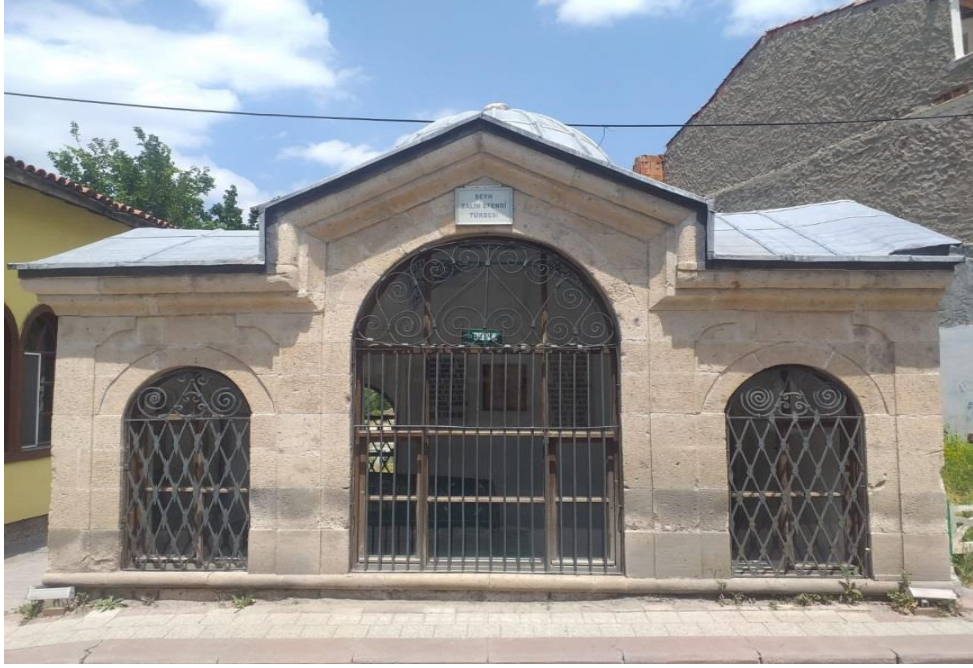
Görsel 84. Şeyh Salih Türbesi Kuzey Cephesi
