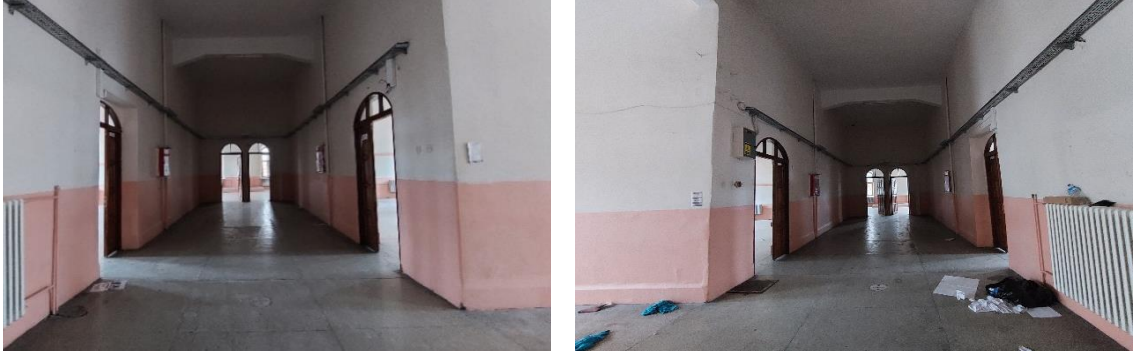
Görsel 9. Kütahya Lisesi Birinci Kat Doğu Yönü ve Batı Yönü Koridoru
