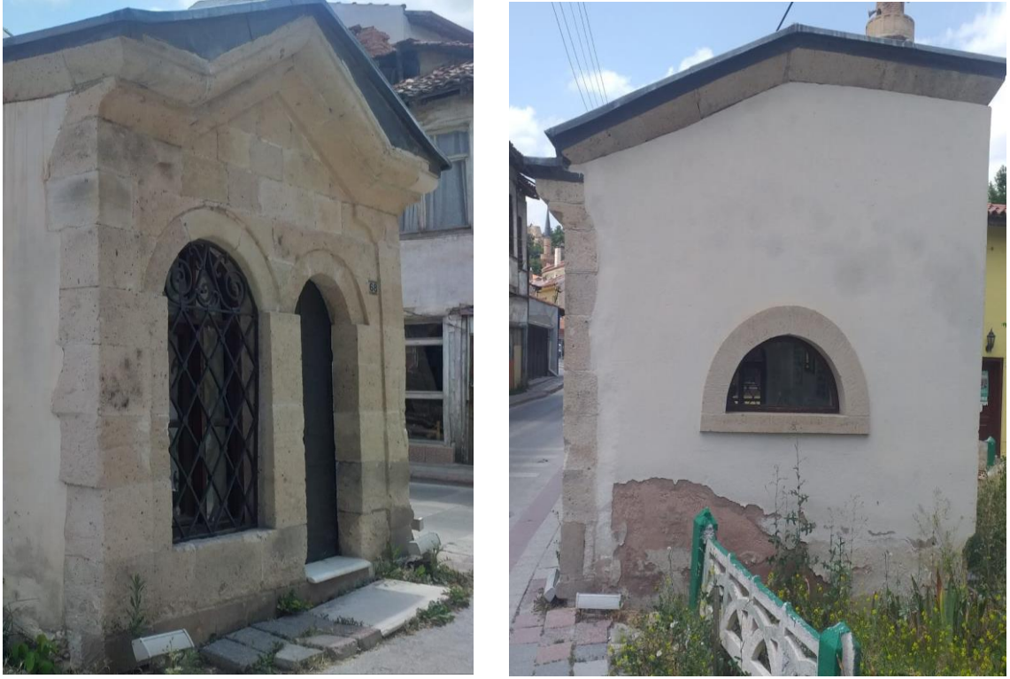
Görsel 86. Şeyh Salih Türbesi Batı ve Doğu Cephesi
