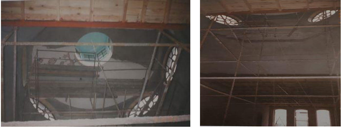
Grsel 122. Adalet Sarayı Onarım alıřmaları (Ktahya Kltr ve Tabiat Varlıklarını Koruma Blge Kurulu Mdrlg Arřivi)
