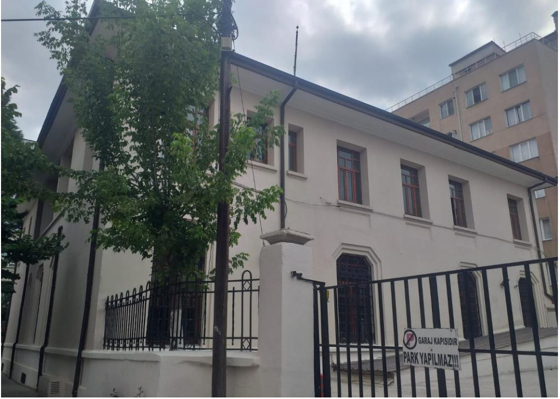
Görsel 126. Ziraat Bankası Kütahya Şube Binası Kuzey Cephesi
