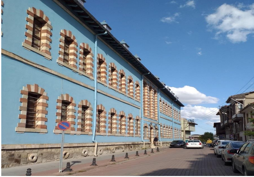
Görsel 119. Adalet Sarayı Güney Cephesi
