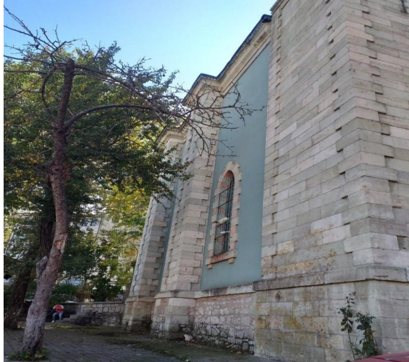
G6rsel 96. Yeřil Camii Dođu Cephesi
