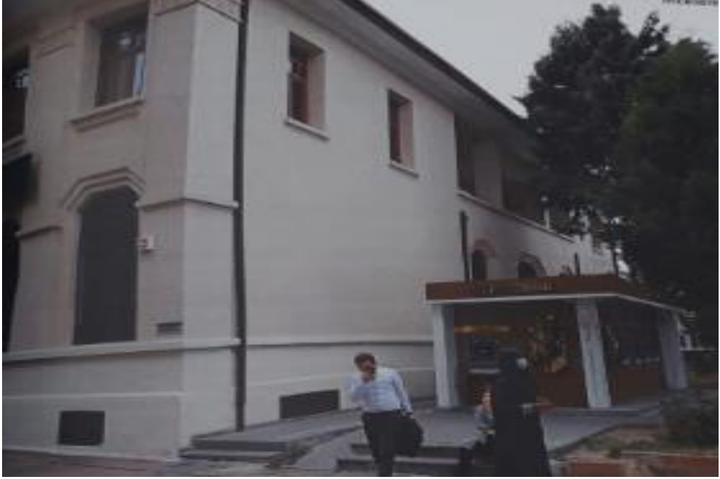
Görsel 128. Ziraat Bankası Kütahya Şube Binası Doğu Cephesi (Kütahya Kültür ve Tabiat Varlıklarını Koruma Bölge Kurulu Müdürlüğü Arşivi)
