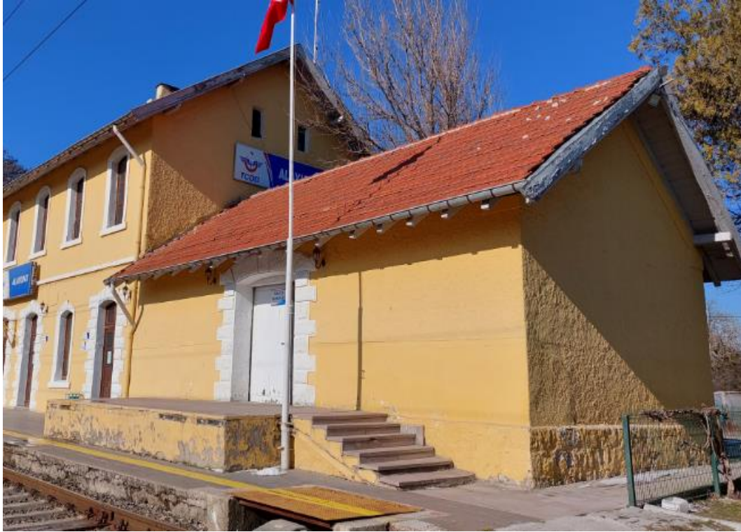
Görsel 135. Alayunt Tren İstasyon Binası Ambar Binası Doğu Cephesi
