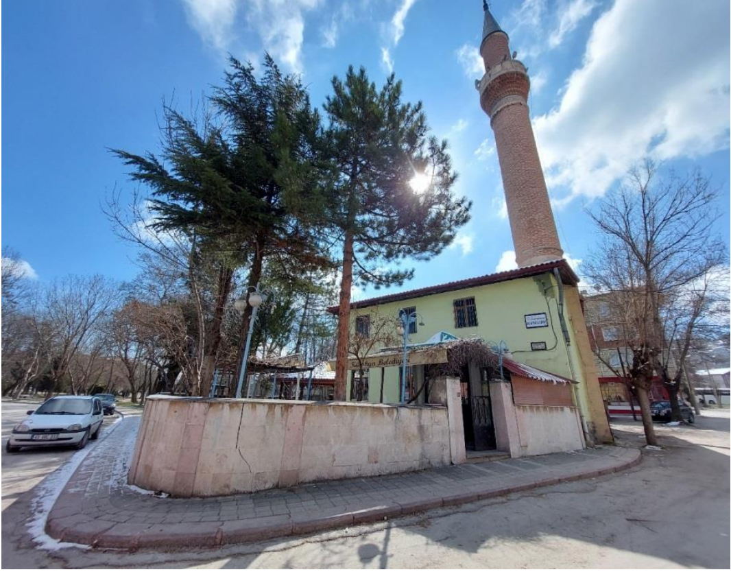
Görsel 75. Dilsizoglu Camii Güney Cephesi
