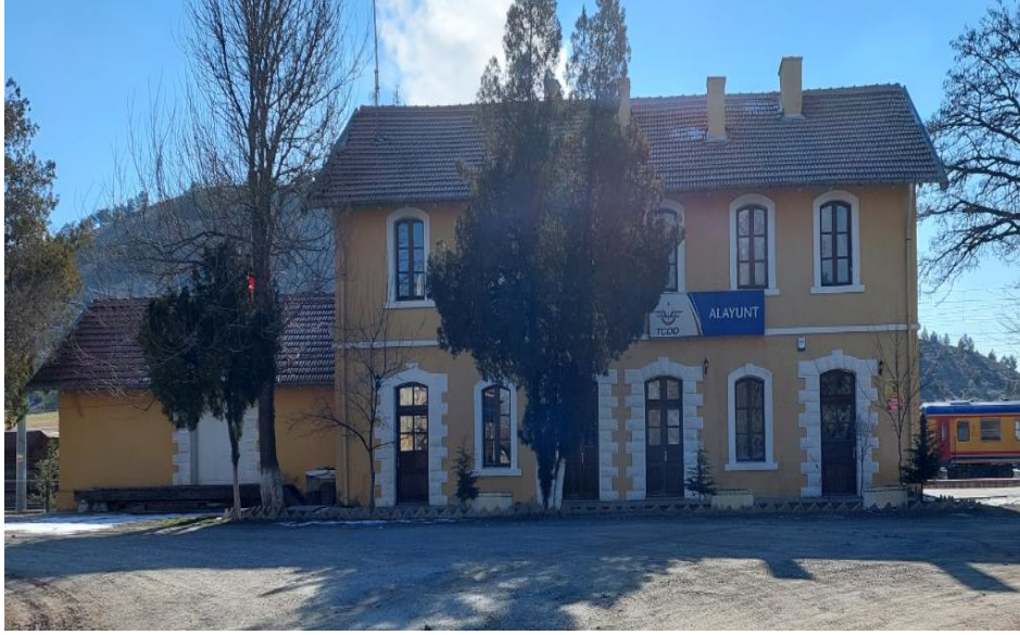
Görsel 133. Alayunt Tren İstasyon Binası Batı Cephe
