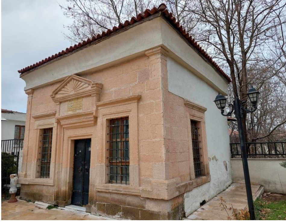
Görsel 41. Molla Bey Külliyesi Kuzey Giriş ve Doğu Cephesi
