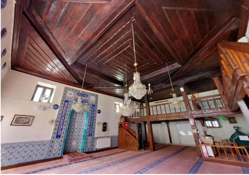
Görsel 45. Mesudiye Camii Harimden Genel Görünüş
