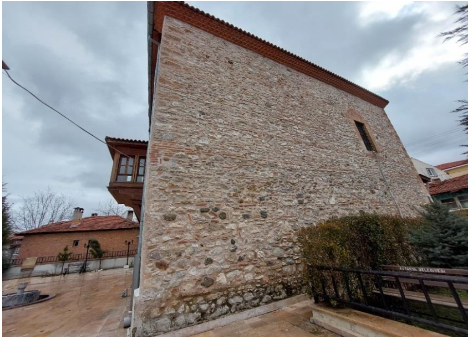
Görsel 39. Molla Bey Külliyesi Camii Batı Cephesi
