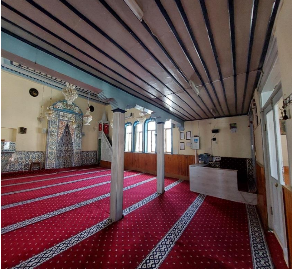
Görsel 72. Dilsizoglu Camii Son Mahfili Taşıyan Dikmeler
