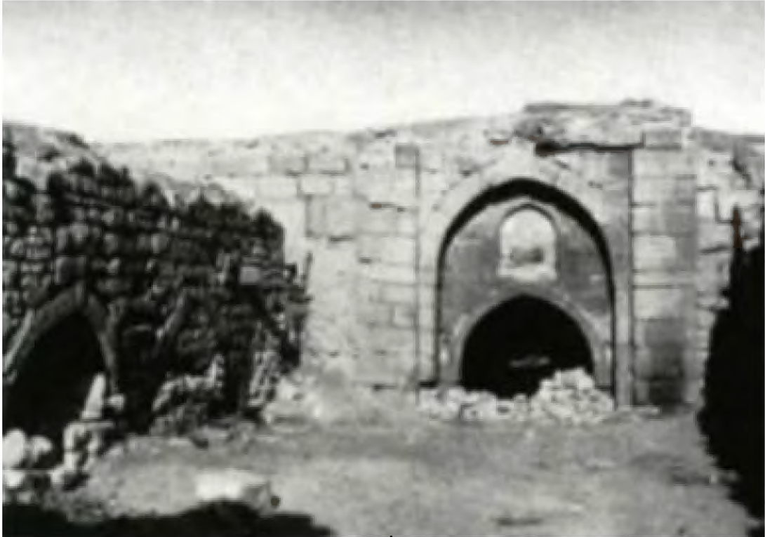
Fotoğraf 4: Altunapa Kervansarayı'nın İç Avlulu Bölümündeki Revağın Eski Bir Fotoğrafı
