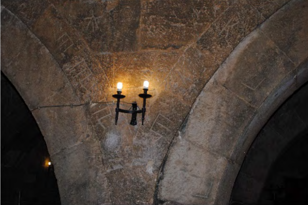
Fotoğraf 110: Horozlu Han'ın Kapalı Bölümünün Kemerlerindeki Taşçı İşaretleri (Oğulcan AVCI)
