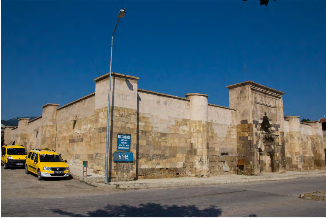
Fotoğraf 111: İshaklı Kervansarayı Giriş Cephesi
