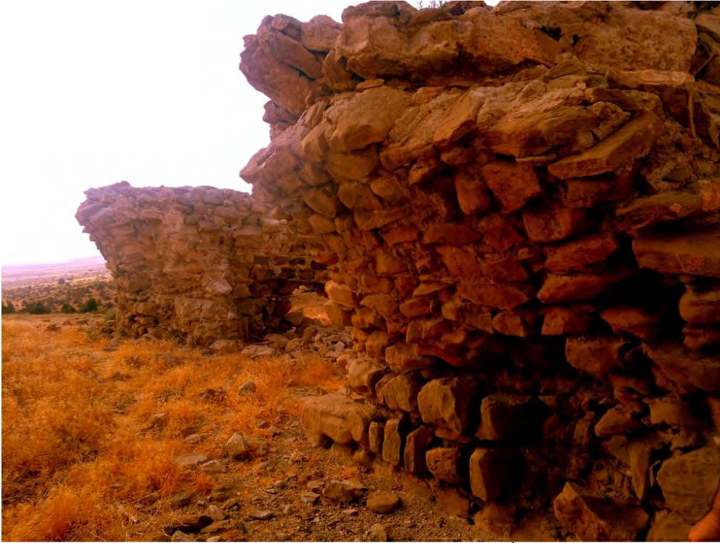
Fotoğraf 116: Niğde Ulukışla Kamereddin Kervansarayı'nın İç Avlulu Bölümünde Yer Alan Eyvanları Örtün Tonzların Başlangıçları Kaynak: http://www.ulukisla.gov.tr/kamereddin-han (Erişim Tarihi 13.01.2016)
