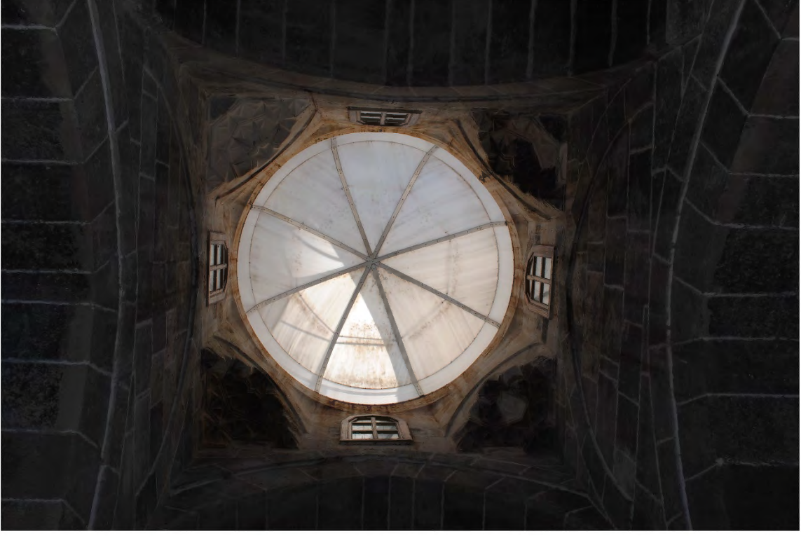
Fotoğraf 95: Zazadin Han'ın Kapalı Bölümünün Orta Sahınındaki Aydınlık Açıklığı ve Günümüzdeki Örtü Sistemi (Oğulcan AVCI)
