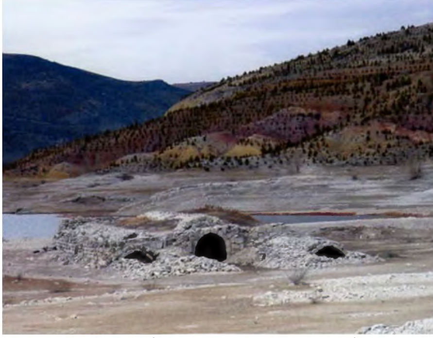
Fotoğraf 1: Altunapa Kervansarayı Giriş Cephesi Kaynak: R. Duran, 2007, s. 79
