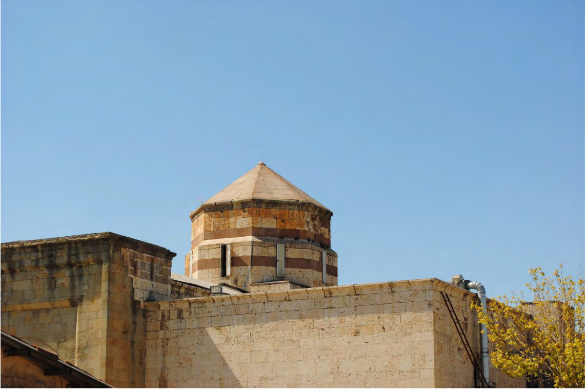
Fotoğraf 109: Horozlu Han'ın Kapalı Bölümünün Orta Sahınındaki Aydınlık Açıklığının Külâh Kısmı (Oğulcan AVCI)
