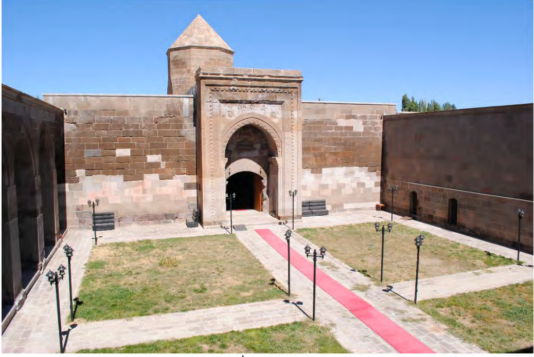
Fotoğraf 53: Karatay Kervansarayı İç Avlulu Bölümünün Genel Görünüüü (Oğulcan AVCI)
