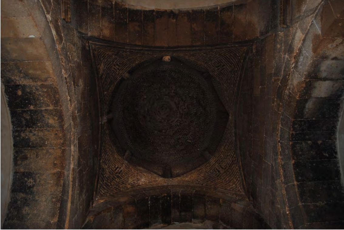
Fotoğraf 108: Horozlu Han'ın Kapalı Bölümünün Orta Sahınındaki Aydınlık Açıklığı ve Örtü Sistemi (Oğulcan AVCI)
