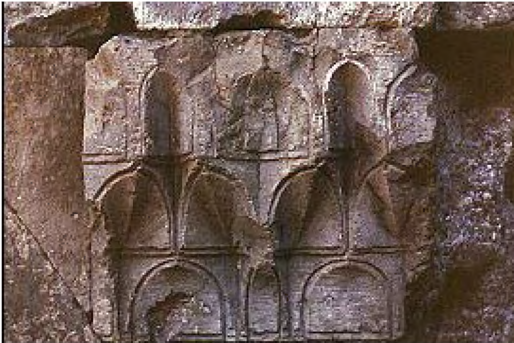
Fotoğraf 171: Şerafeddin Ejder Kervansarayı Barınak Bölümünün Tonozunu Destekleyen Takviye Kemerlerinin Oturduğu Konsollar
