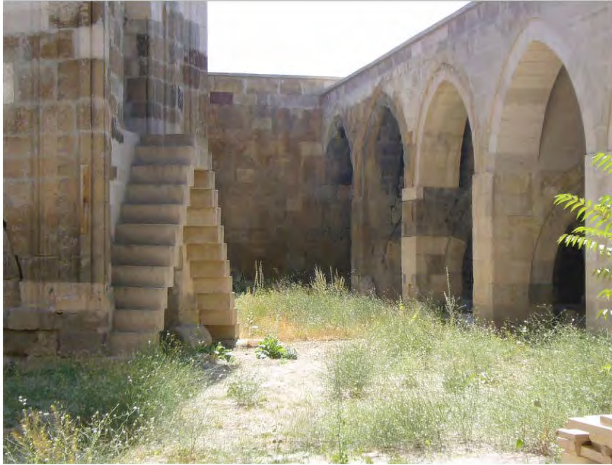
Fotoğraf 114: İshaklı Kervansarayı'nın İç Avlulu Bölümü'nün Kuzeybatı Duvarındaki Revak
