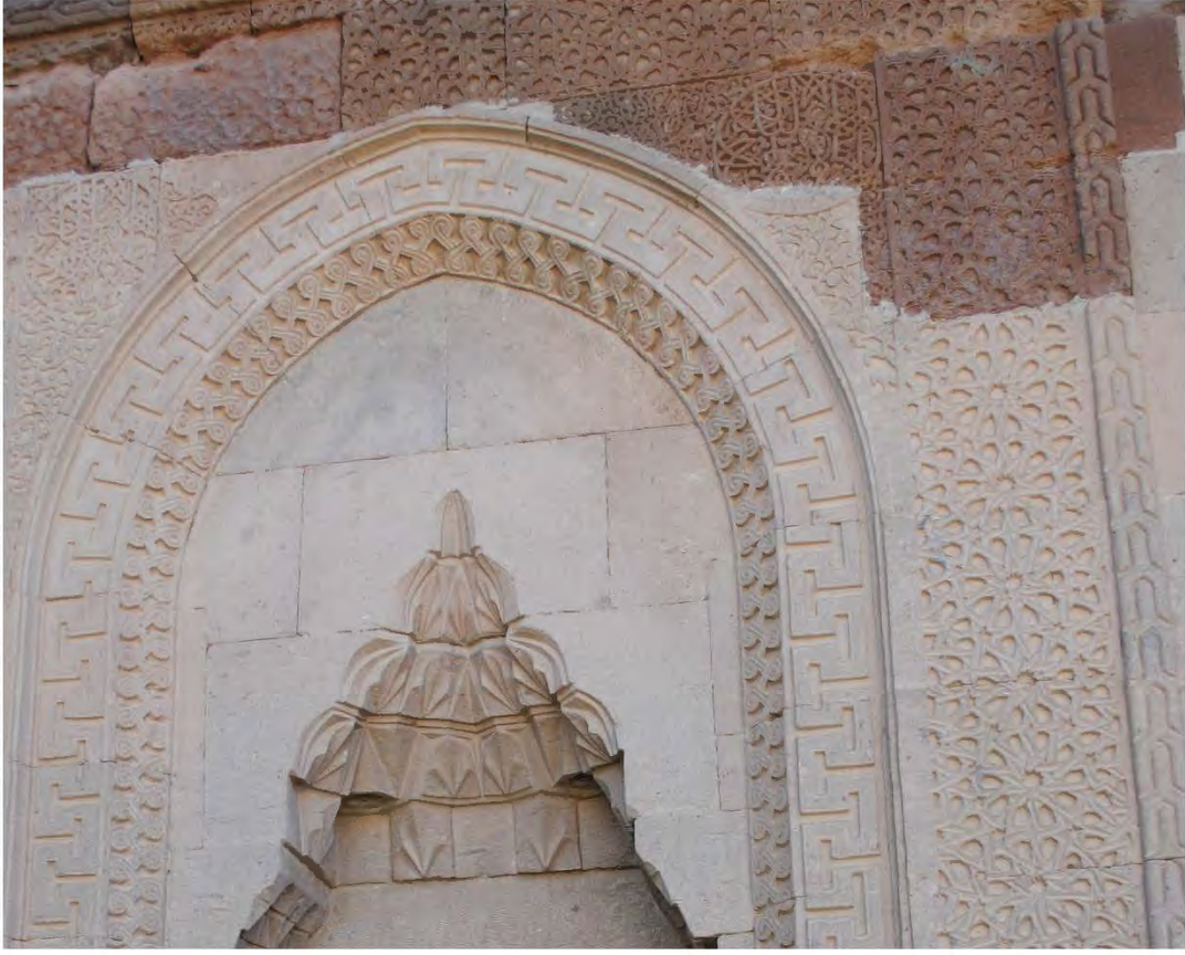
Fotoğraf 79: Karatay Kervansarayı'nın Mescit Mekanına Girişi Sağlayan Kapı Açıklığının Süsleme Detayı (Oğulcan AVCI)
