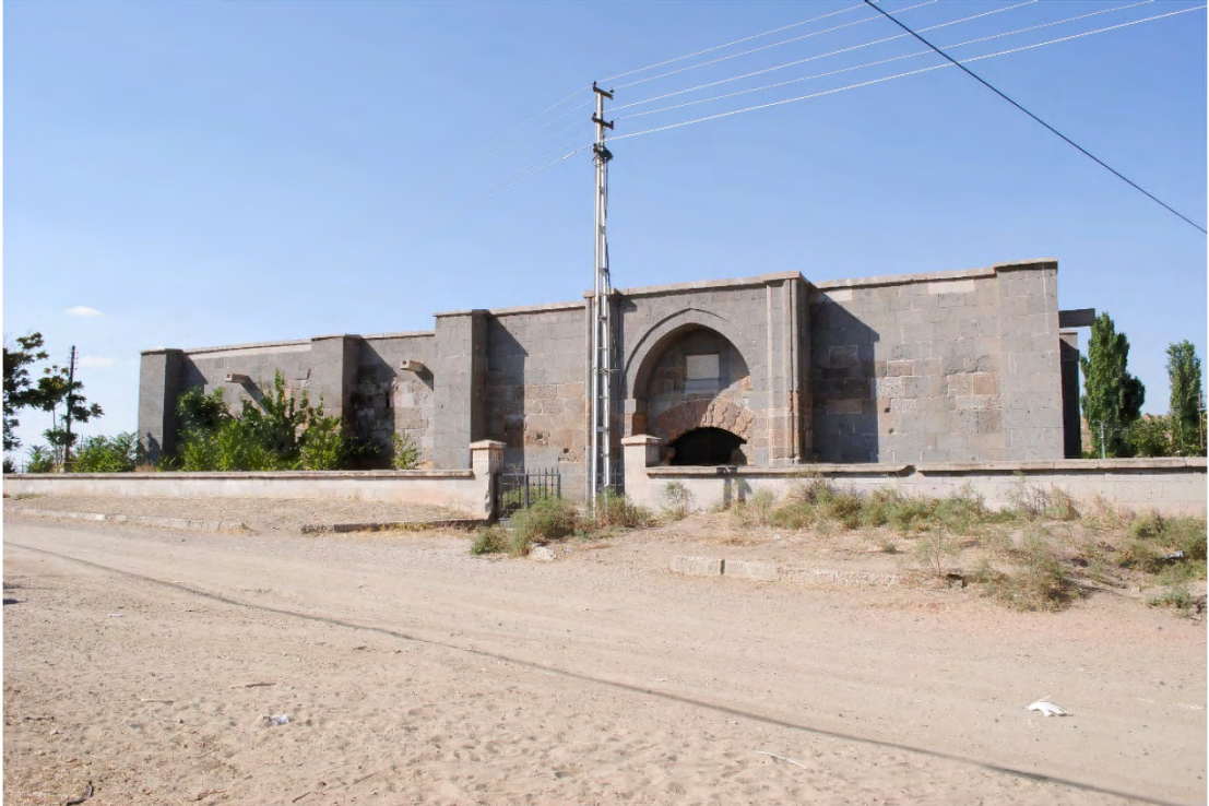
Fotoğraf 152: Kesikköprü Kervansarayı Giriş Cephesi (Oğulcan AVCI)
