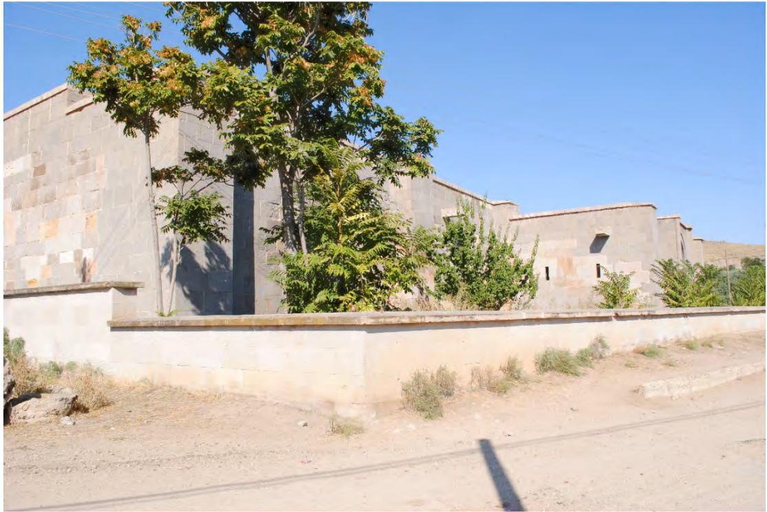
Fotoğraf 154: Kesikköprü Kervansarayı Güney Cephesi (Oğulcan AVCI)
