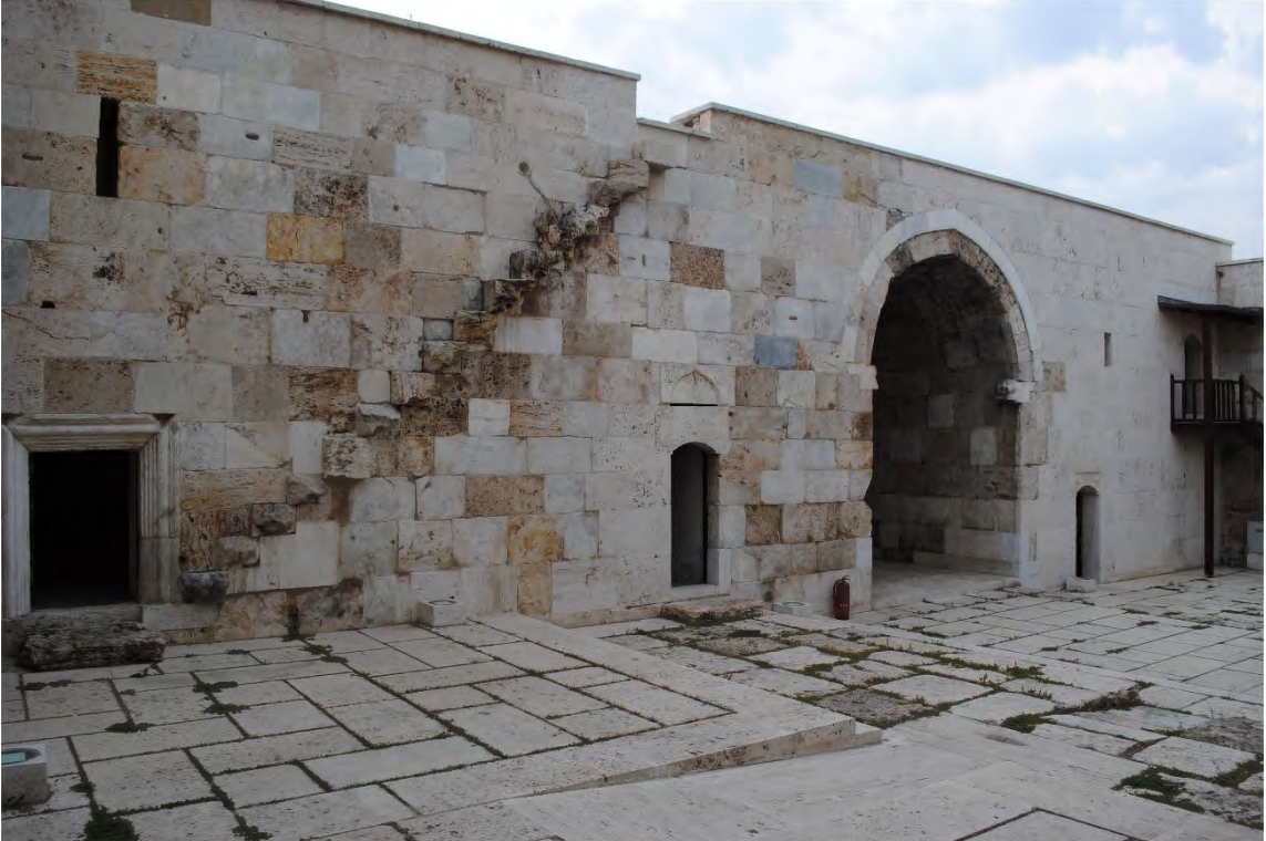
Fotoğraf 128: Ak Han'ın İç Avlulu Bölümünün Kuzeydoğu Duvarında Yer Alan Birimler (Oğulcan AVCI)
