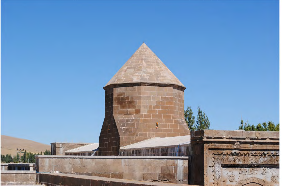
Fotoğraf 71: Karatay Kervansarayı'nın Kapalı B l m n n Orta Sahınındaki Ayd nlık A ıklıėının K lah Kısım  (Oėulcan AVCI)
