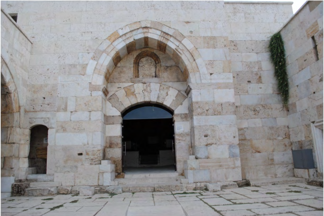
Fotoğraf 132: Ak Han'ın Kapalı Bölüme Girişi Sağlayan Portal Kuruluşu (Oğulcan AVCI)
