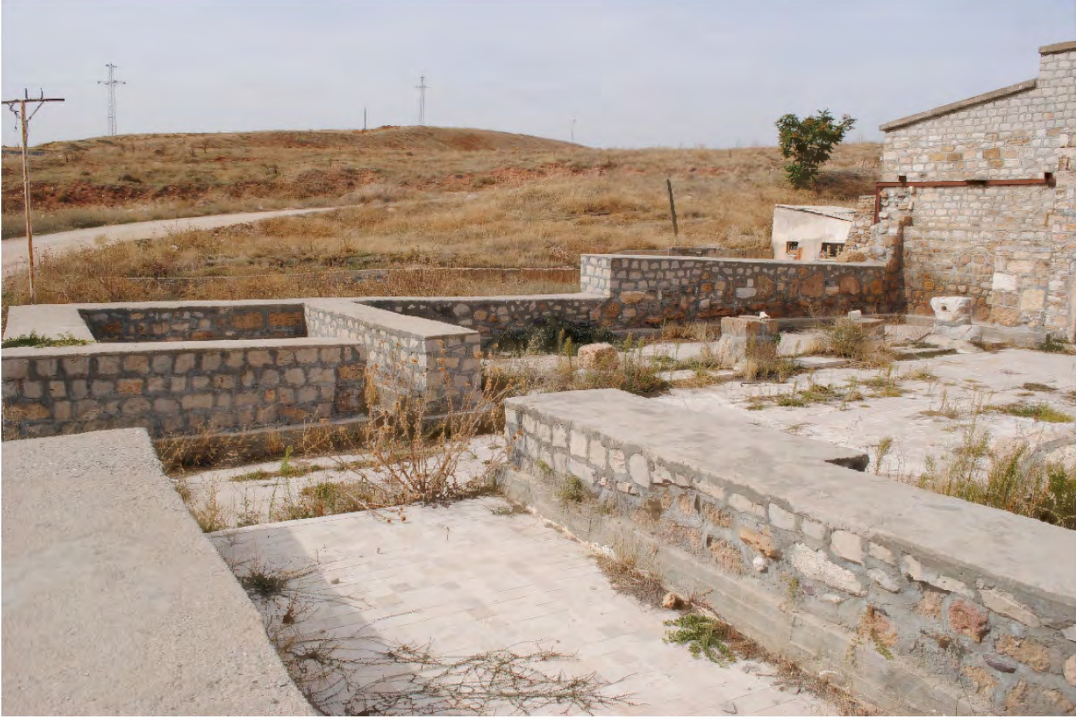
Fotoğraf 25: Dokuzun Han'ın İç Avlulu Bölümün Kuzeyine Bakış (Oğulcan AVCI)
