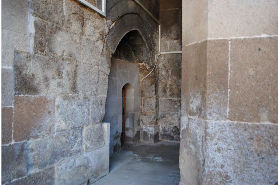
Fotoğraf 60: Karatay Kervansarayı'nın Hamam Bölümüne Girişi Sağlayan Kapı Açıklığı (Oğulcan AVCI)
