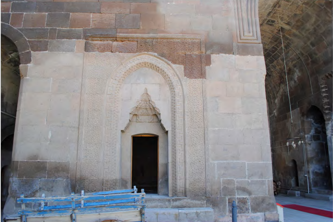
Fotoğraf 56: Karatay Kervansarayı'nın Mescit Mekanına Girişi Sağlayan Kapı Açıklığı (Oğulcan AVCI)
