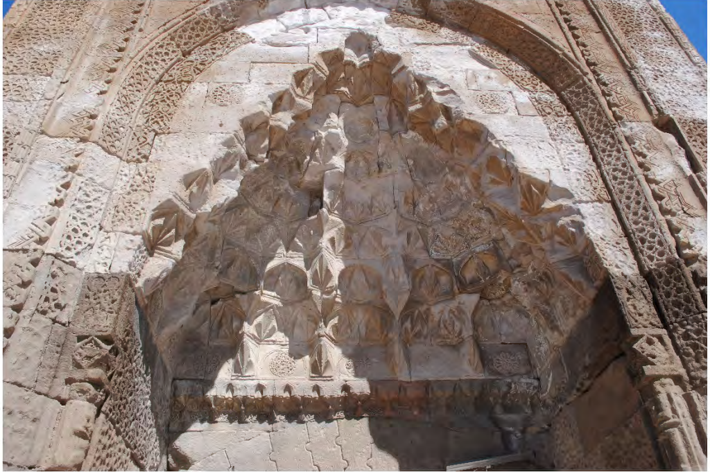
Fotoğraf 76: Karatay Kervansarayı'nın İç Avlulu Bölümünün Portal Kuruluşunun Mukarnas Dolgulu Kavsarası (Oğulcan AVCI)
