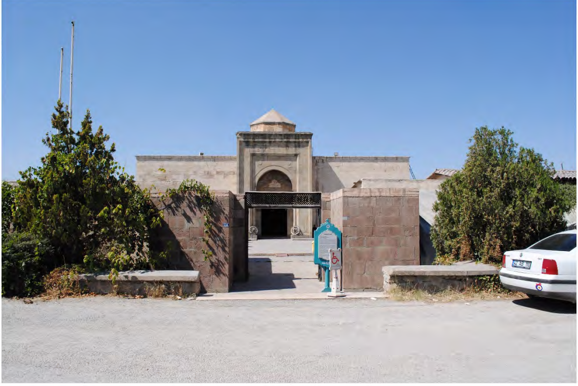
Fotoğraf 101: Horozlu Han Giriş Cephesi (Oğulcan AVCI)
