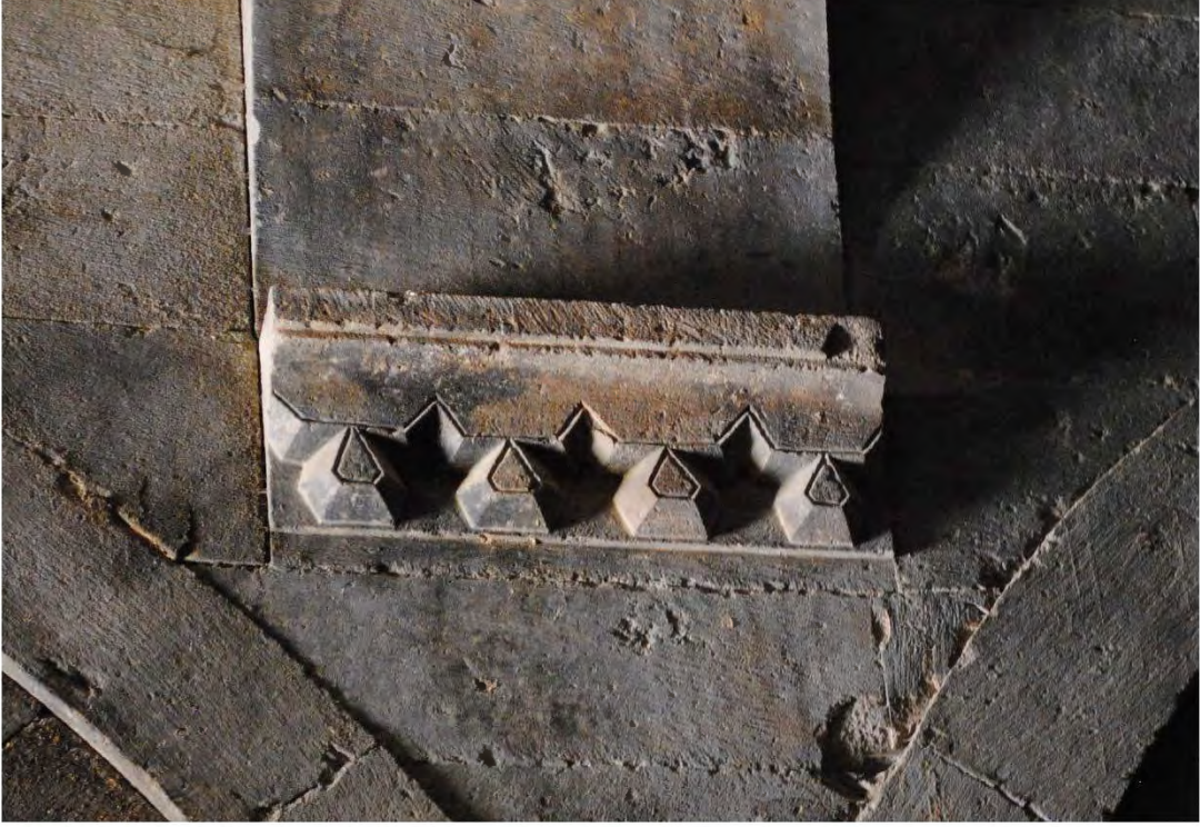
Fotoğraf 83: Karatay Kervansarayı'nın Kapalı Bölümünün Tonozunu Destekleyen Takviye Kemerlerinin Oturduğu Konsollardan Biri (Oğulcan AVCI)
