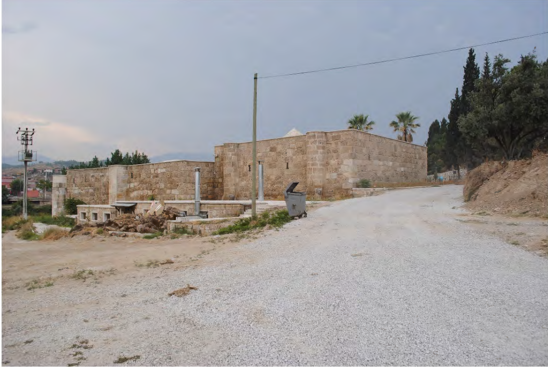
Fotoğraf 126: Ak Han Kuzeydoğu Cephesi (Oğulcan AVCI)
