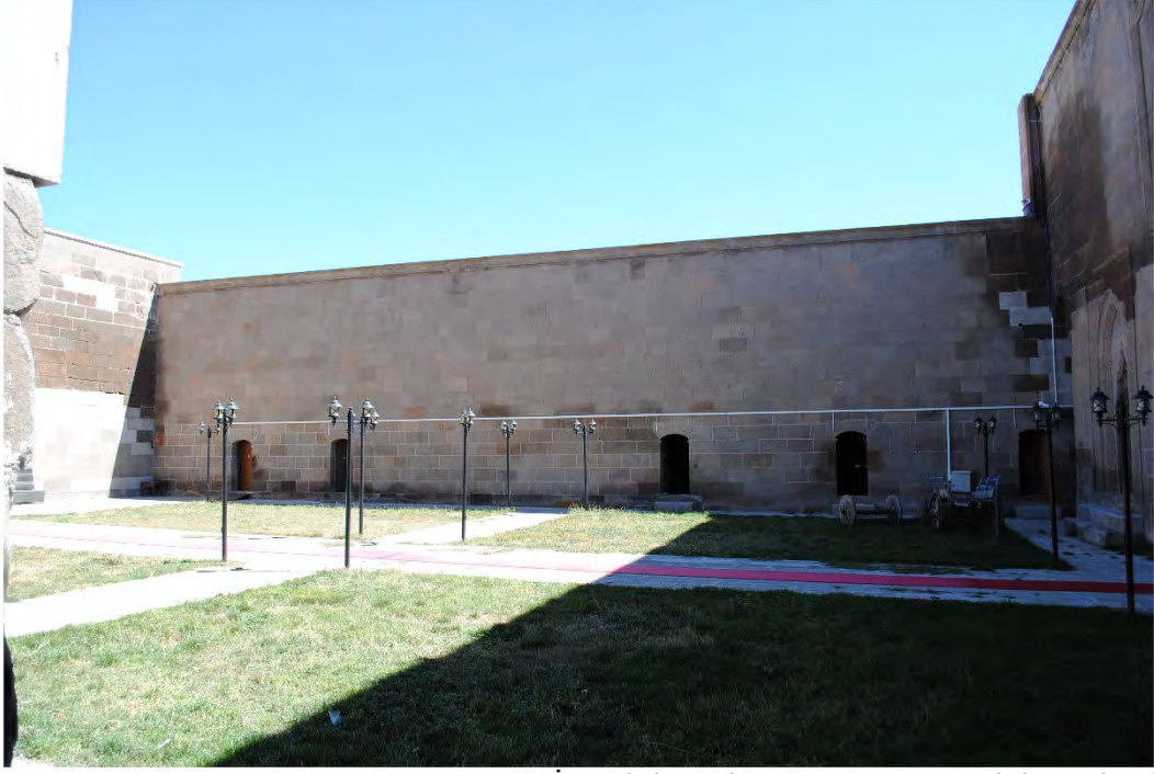
Fotoğraf 65: Karatay Kervansarayi'nin İç Avlulu Bölümünün Doğusundaki Mekanlar (Oğulcan AVCI)
