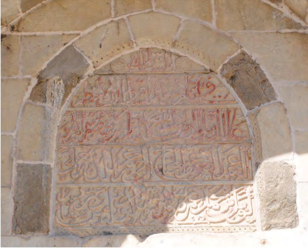
Fotoğraf 87: Zazadin Han 'ın Kapalı Bölümünün Portal Kitabesi (Oğulcan AVCI)
