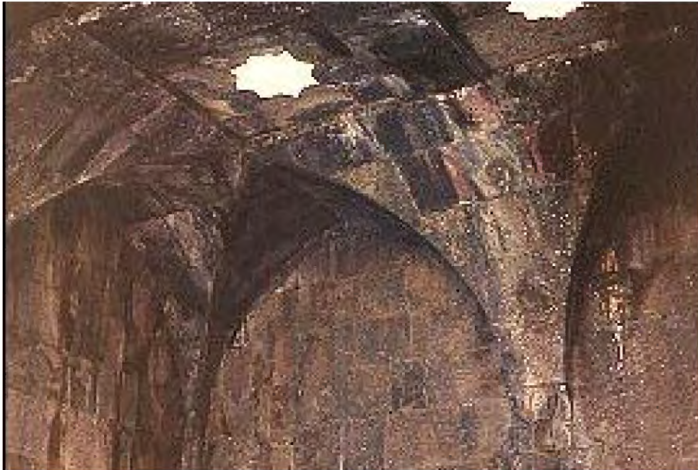
Fotoğraf 172: Şerafeddin Ejder Kervansarayı Giriş Mekanını Örtten Tonoz Kaynak: http://www.virtualani.org/zor/index.htm (Erişim Tarihi: 17.06.2016)
