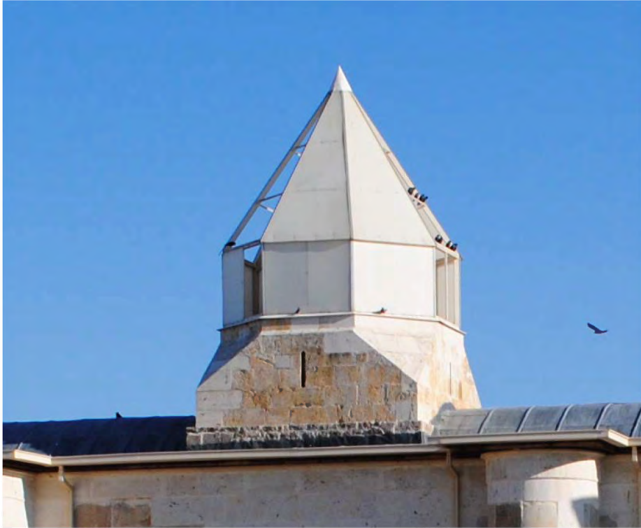
Fotoğraf 96: Zazadin Han'ın Kapalı Bölümünün Orta Sahınındaki Aydınlık Açıklığının Kûlah Kısmı (Oğulcan AVCI)
