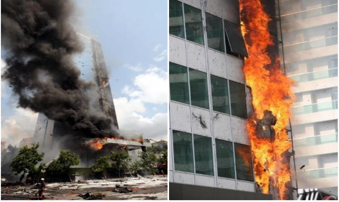
Görsel 2.31. Şişli, Polat Kule'de yangından görünüm [44]
