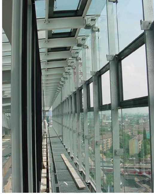
Görsel 2.17. Bir ofis binasının çift cidarlı cephe kuruluşu arasındaki boşluk, Frankfurt, Almanya, 2001 (Bayram, A. 2003)
