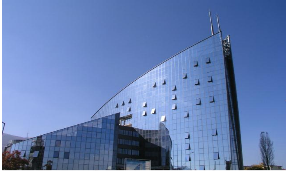
Görsel 2.14. Dört taraflı geleneksel alüminyum giydirme cephe sistemi örneği (Feniş sistemi, 2012)
