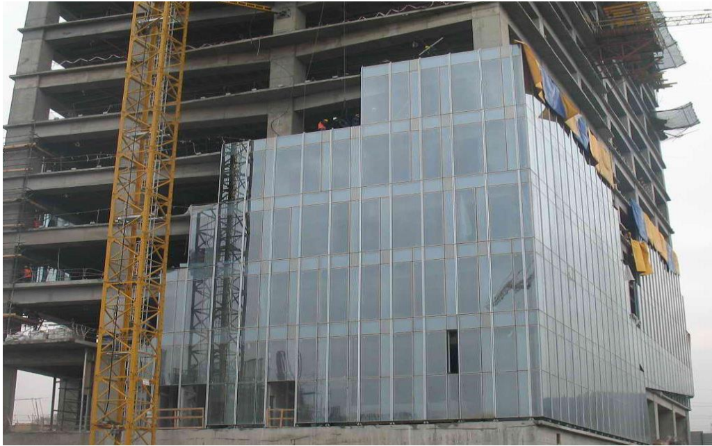
Görsel 2.20. Alttan üste, Esentai Kulesi'ne ünitelerin kurulması (Feniş sistemi, 2012)
