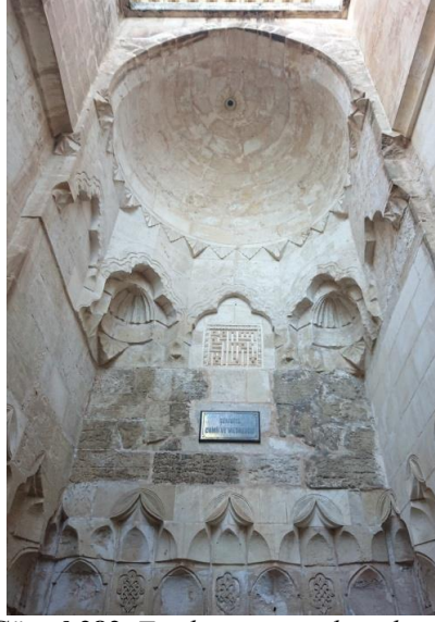
Görsel 282. Taç kapı nişinin batı duvarı
