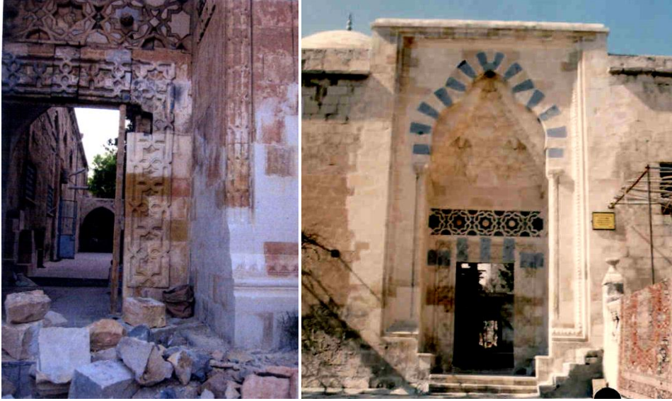
Görsel 162. Taç kapının 2004-2006 yılları arasında geçirmiş olduğu onarımları ve onarım sonunu gösteren fotoğraflar (Ş.K.V.K.B.K.M. arşivi)
