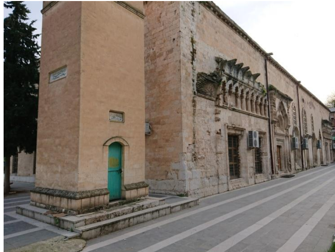
Görsel 408. Diyarbakır Silvan Ulu Cami'nin kuzeydoğu köşesi
