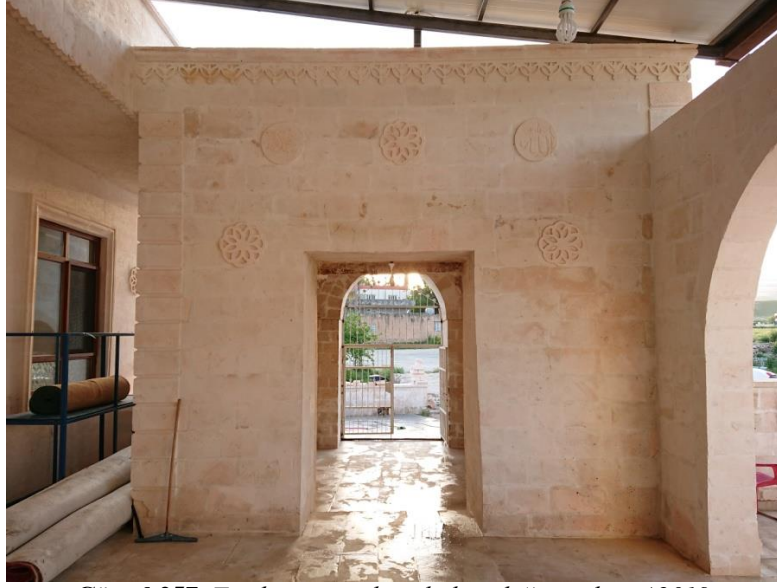
Görsel 257. Taç kapının avluya bakan doğu cephesi / 2019
