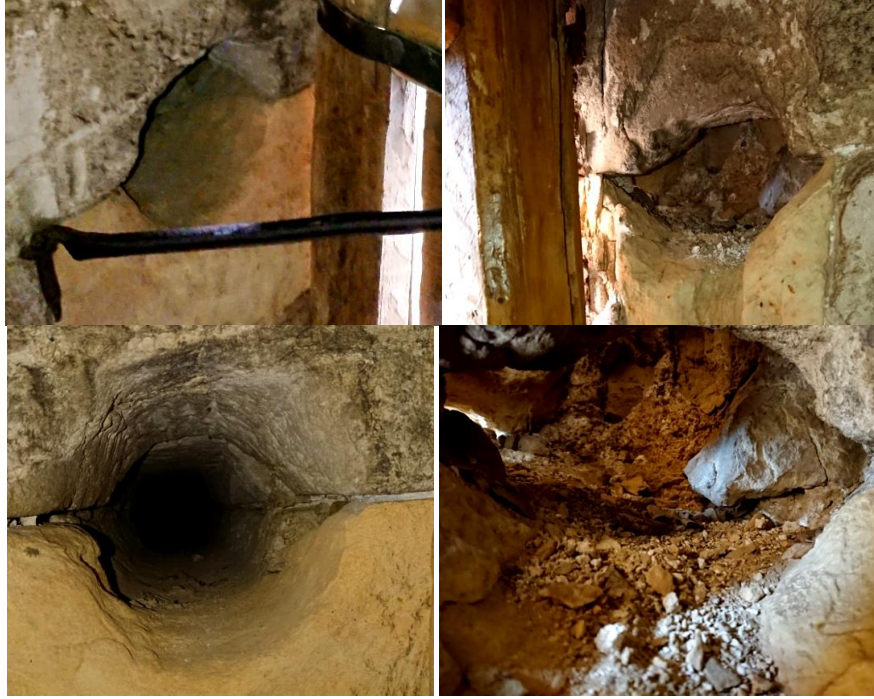
Görsel 399. Taç kapının iç cephe koridorunda, giriş açıklığının doğu ve batı yan duvarlarında bulunan derin nişler
