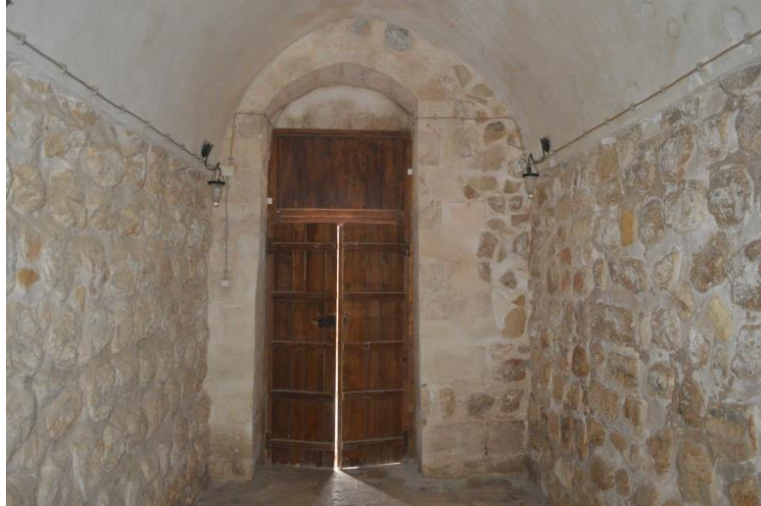
Görsel 240. Taç kapı giriş açıklığının kuzey koridorundan görünümü
