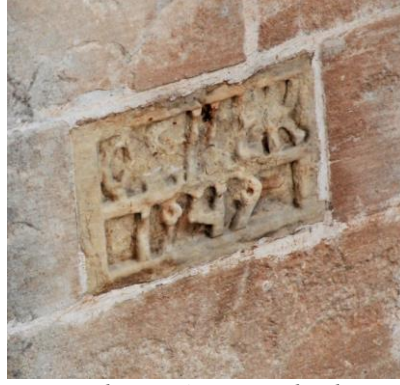
Görsel 341. Batı yan kanattaki onarım kitabesinin son durumu
