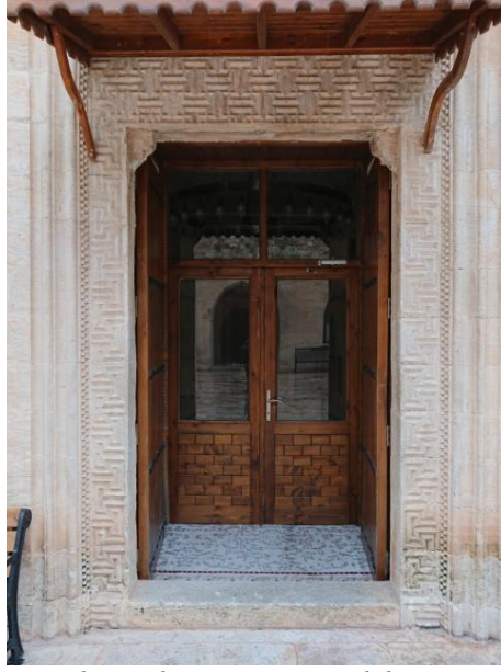
Görsel 204. Harimin kuzey duvarının ortasındaki giriş açıklığından detay
