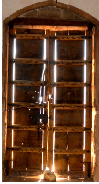
Görsel 374. Giriş açıklığını örten ahşap kapı kanatlarının arka yüzleri / 2015
