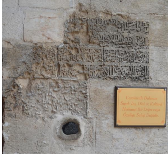
Görsel 9. Giriş eyvanının güney duvarındaki kitabe ve siyah taş
