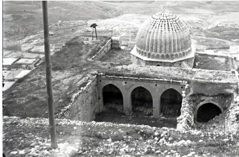
Görsel 347. Sultan İsa (Zinciriye) Medresesi'nin toprak kaplı damı (DVBM arşivi)
