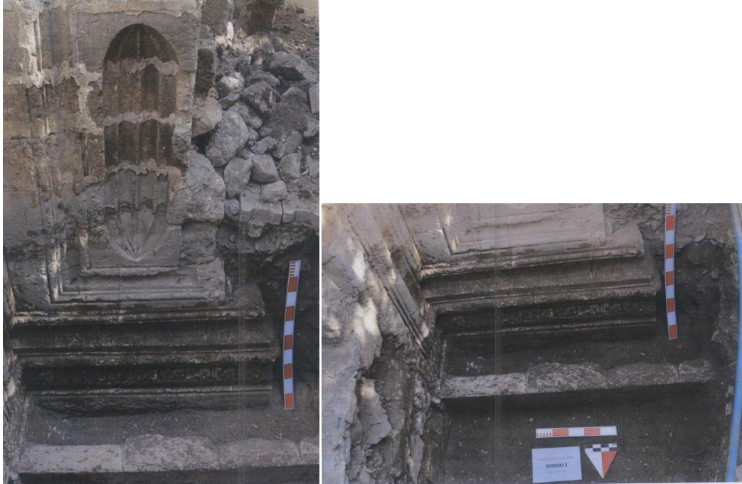
Görsel 62. Avlunun batısındaki taç kapının güney yan kanadı ve niş kalıntıları / 2017 (Ş.K.V.K.B.K.M. arşivi)
