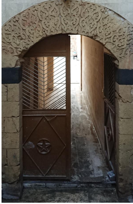
Görsel 310. Demir profilli kapı kanatları
