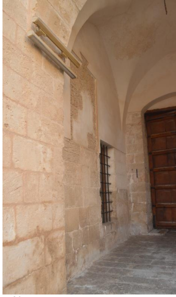
Görsel 42. Batı giriş eyvanının güney duvarı
