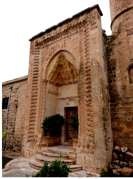
Görsel 97. Taç kapının kuzeydoğu köşeden görünümü
