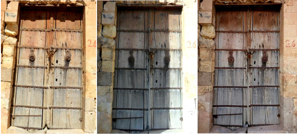
Görsel 373. Giriş açıklığını örten ahşap kapı kanatlarının ön yüzleri (soldan sağa; 2015, 2016, 2019 yılları)
