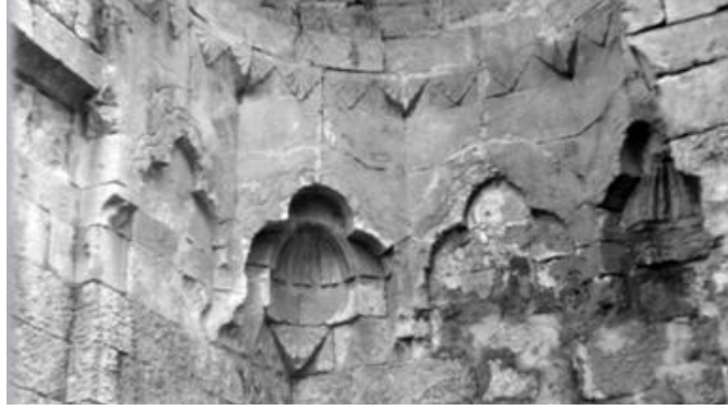
Görsel 281. Taç kapı nişinde yarım kubbeye geçişte yer alan üç dilimli kemere sahip içbükey yüzeyli iki küçük tromp ve niş düzenlemeleri / 1967 (Altun, 2011, s. 80)
