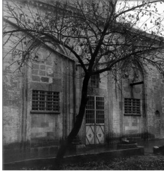
Görsel 201. Harimin kuzey duvarının kuzeydoğudan çekilmiş görünümü / 1968 (Altun, 2011, s. 43)
