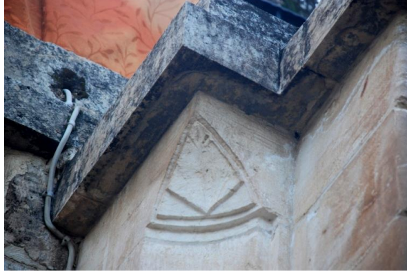
Görsel 294. Güney yan kanadın dış cephesinin üst kodundaki mukarnas parçası
