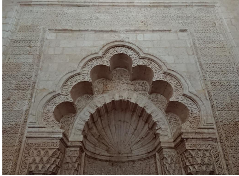
Görsel 46. Mihrabın dilimli kemeri üzerine işlenmiş inşa kitabesi
