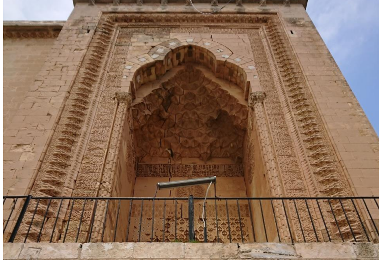
Görsel 356. Taç kapı yan kanatları
