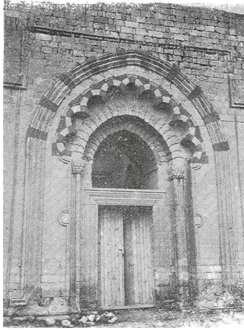
Görsel 70. Harimin kuzey duvarının ortasında bulunan taç kapının avludan görünümü / 1982 (Ünal)
