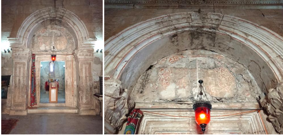
Görsel 423. Mor Yakup Manastırı 'nin, naos bölümünden apsis bölümüne geçişte inşa edilmiş taç kapısı
