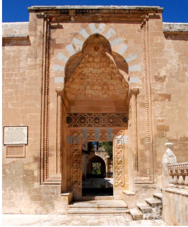
Görsel 142. Caminin iç avlusunun doğu duvarındaki taç kapı
