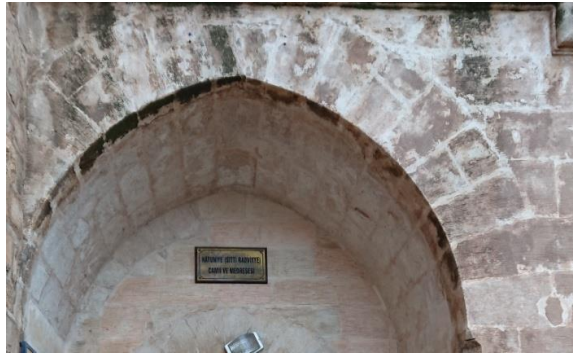
Görsel 238. Giriş eyvanının sivri kemeri
