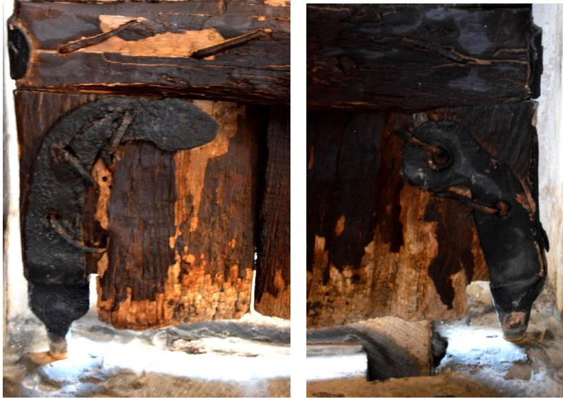
Görsel 117. Ahşap kapı kanatlarını zemine sabitleyerek, açılıp kapanmasını sağlayan ökçe demiri ve ahen-i ökçe
