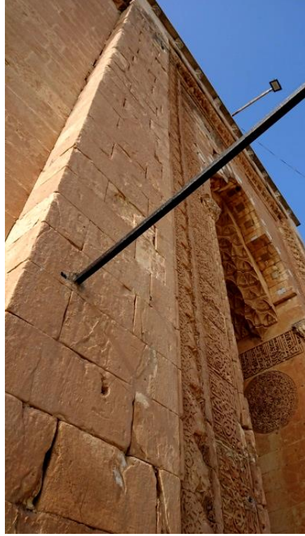
Görsel 358. Taç kapı yan kanadının batı cephesi
