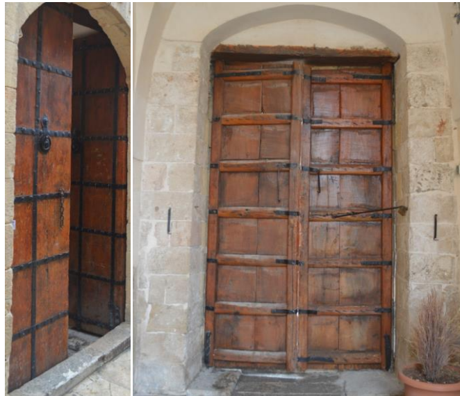
Görsel 35. Avlunun batı giriş açıklığını örten ahşap kapı kanatları
