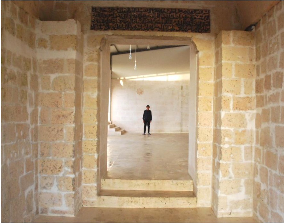
Görsel 265. Taç kapı giriş açıklığı ve inşa kitabesi
