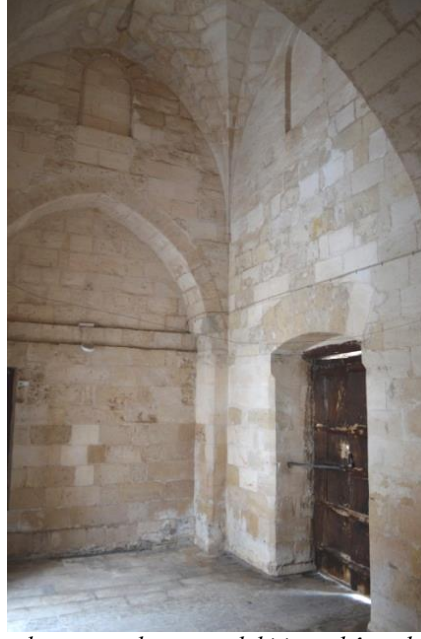
Görsel 124. Taç kapının arka yüzündeki iç mekânın kuzeydoğu köşesi
