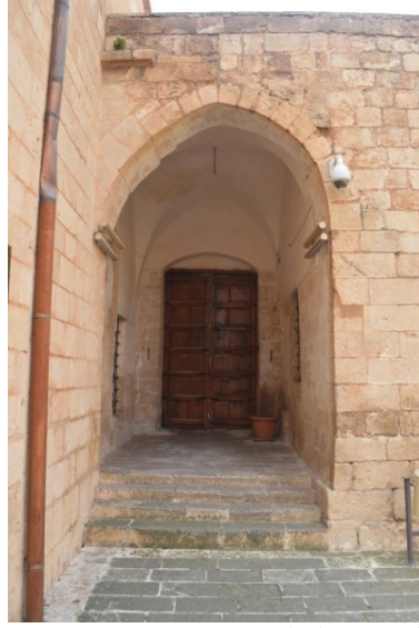
Görsel 40. Batı giriş eyvanının avludan genel görünümü
