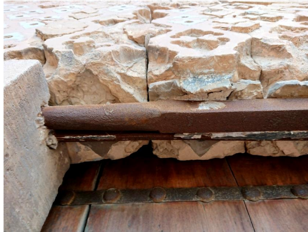
Görsel 372. Giriş açıklığının üzerindeki kesme taşları destekleyen demir gergiler
