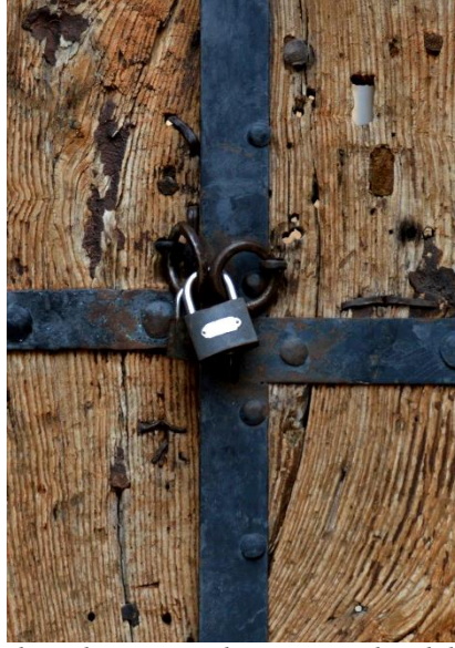
Görsel 118. Ahşap kapı kanatlarını zincirleme amacı ile takılan küçük demir halkalar
