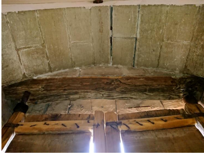
Görsel 398. Giriş açıklığı kemerinin iç cephe koridorundan görünümü
