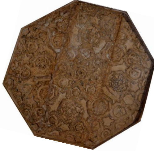
Görsel 133. Taç kapı iç mekânının üzerini örten yıldız tonozun çökertme kenarlı aynalığının genel görüntüsü
