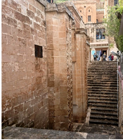
Görsel 275. Taç kapı ve caddeden sahanlığa dođru inen merdiven kuruluşu
