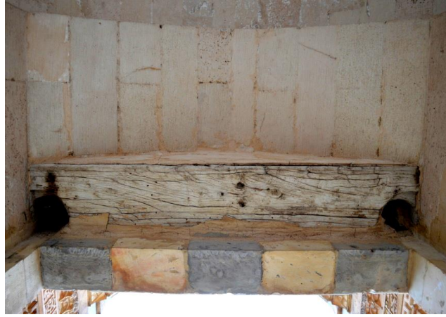
Görsel 150. Taç kapının giriş açıklığını örten ahşap kapı kanatlarının sabitlendiği ahşap hatıl ve sövelerin geçtiği delikler
