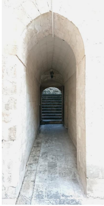
Görsel 334. Giriş koridorunun batı cephesi
