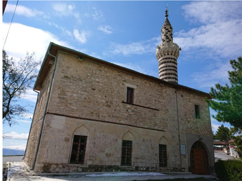
Görsel 405. Harput Alacalı Cami 'nin kuzey cephesi
