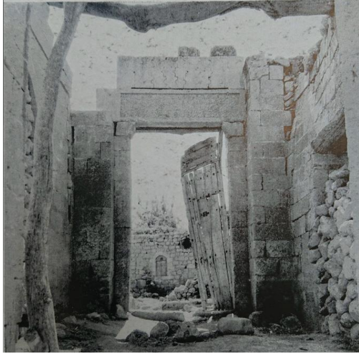
Görsel 254. Giriş eyvanı içindeki doğu giriş açıklığının batı cephesi / 1960'lı yıllar (Kuran, 1969, c.1)
