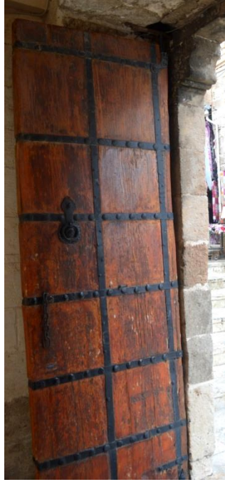
Görsel 15. Ahşap kapının kuzey kanadının ön yüzü
