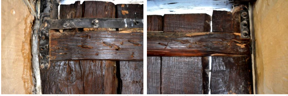
Görsel 116. Ahşap hatılın kuzey ve güney kenarına yerleştirilmiş, ahşap kapı kanatlarının açılıp kapanmasını sağlayan silindirik formundaki demir elemanlar
