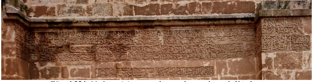
Görsel 234. Medresesinin güney duvarında yer alan vakıf kitabesi
