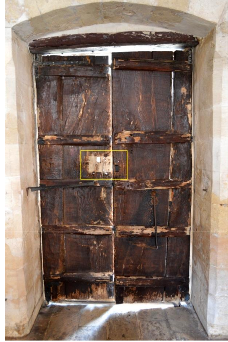
Görsel 115. Ahşap kapının arka yüzü / 2019
