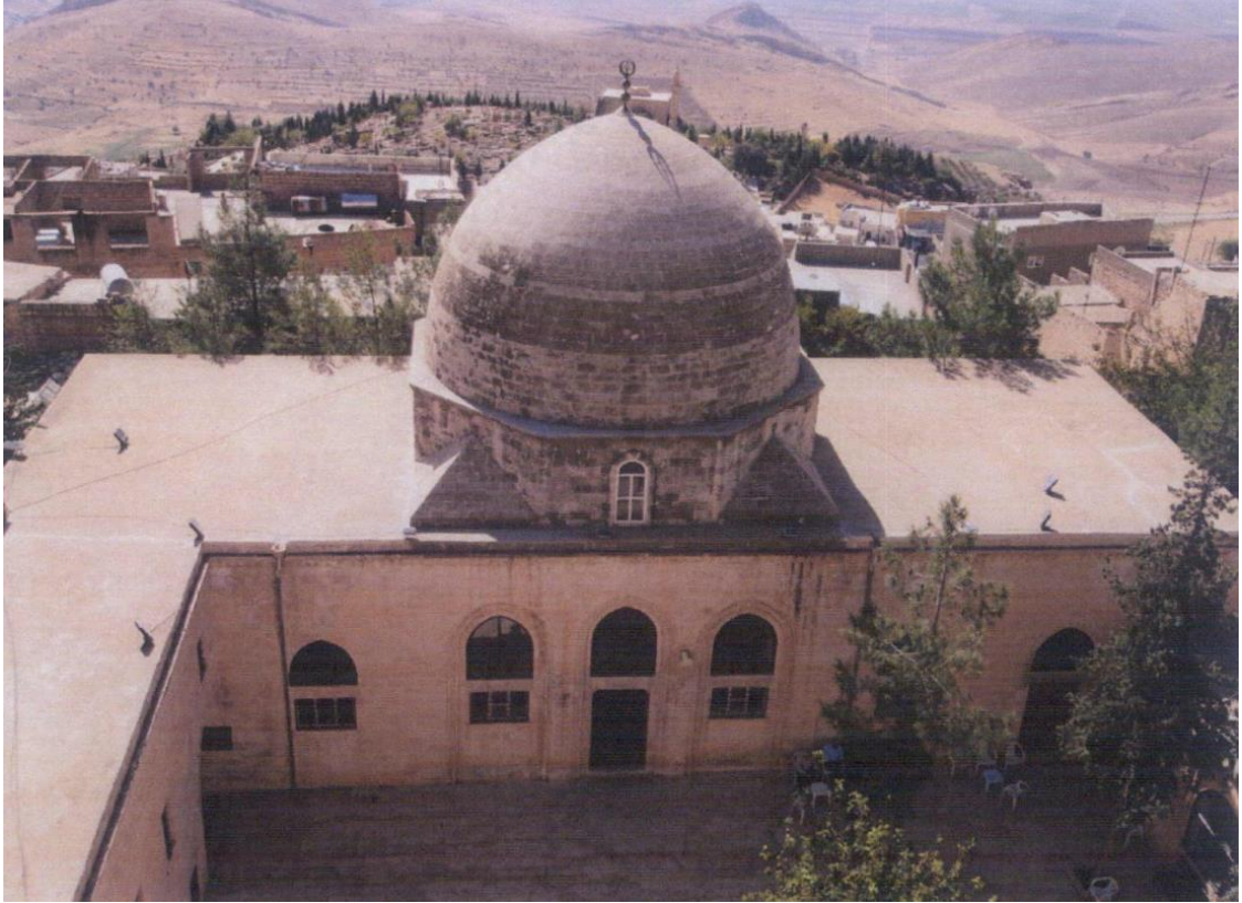
Görsel 202. Harim kuzey duvarının, yapılan onarımlardan sonra kuzeyden çekilmiş görünümü / 2003 – 2006 (Ş.K.V.K.B.K.M. arşivi)
