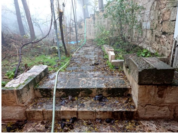
Görsel 194. Abdüllatif Cami avlusunun batı girişinin karşısındaki bahçe merdivenleri
