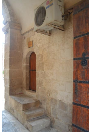
Görsel 26. Giriş eyvanının kuzey duvarı
