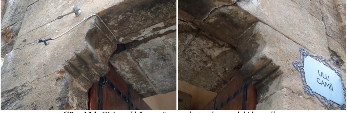
Görsel 14. Giriş açıklığının güney ve kuzey duvarındaki konsollar
