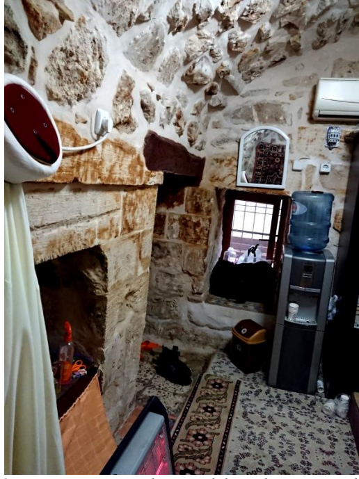
Görsel 187. Giriş eyvanının kuzeyindeki mekânın güneybatı köşesi
