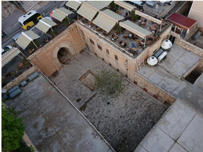
Görsel 274. Minareden genel görünüm
