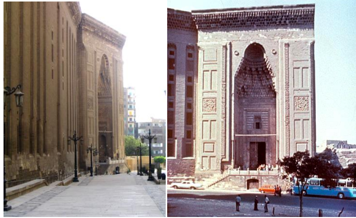
Görsel 422. Mısır / Kahire- Sultan Hasan Medresesi taç kapısı ( http://archnet.org/media_contents/7128 ; http://archnet.org/media_contents/6603 )
