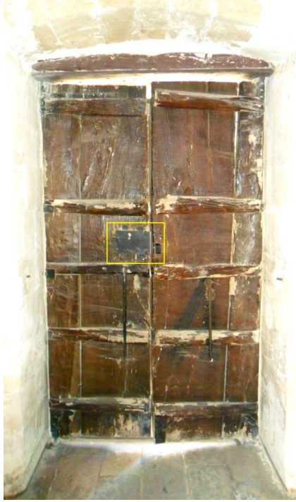
Görsel 114. Ahşap kapının arka yüzü / 2016
