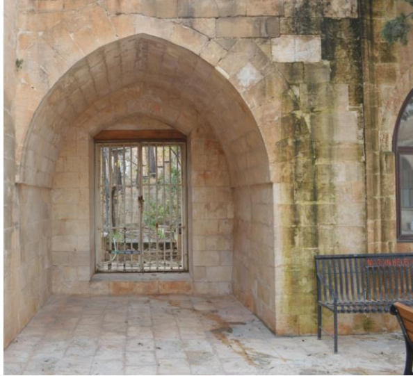
Görsel 188. Avlunun batı girişi eyvanının günümüzdeki görünümü
