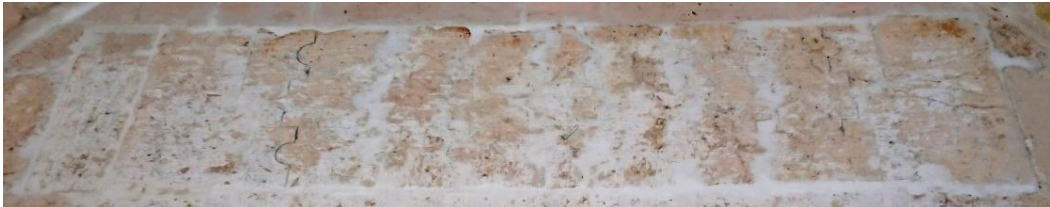
Görsel 267. Taç kapıdaki şerit kitabenin üzerinde yer alan zıvanalı geçmeler / 2019
