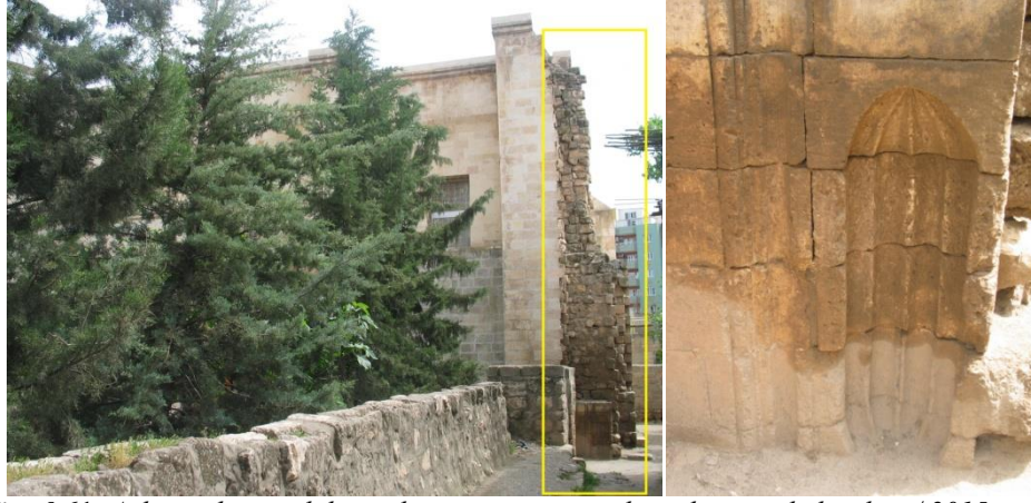
Görsel 61. Avlunun batısındaki taç kapının güney yan kanadı ve niş kalıntıları / 2015 öncesi (Ş.K.V.K.B.K.M. arşivi)
