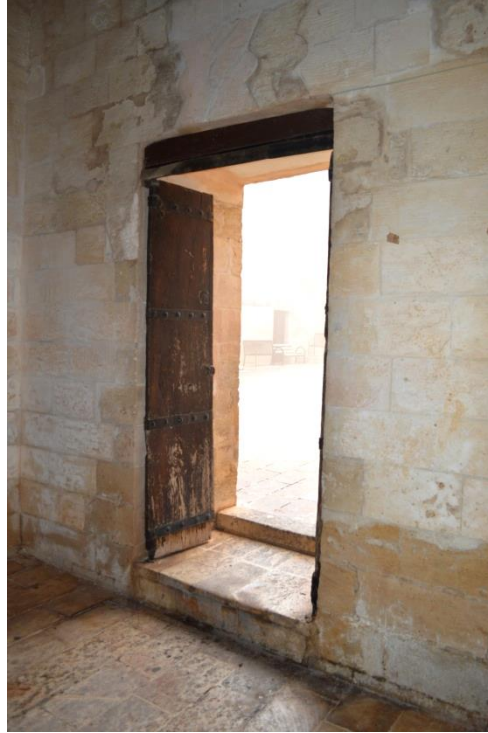
Görsel 126. Taç kapı iç mekânının batı cephesi
