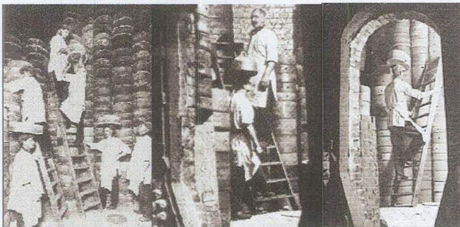
Resim 31 : Sagar Kutularının Fırın İçerisine Yerleştirilmesi. http://www.netcentral.co.uk/steveb/bottle_kiln/saggar.html http://www.netcentral.co.uk/steveb/postcards/wedgwood/8.html
