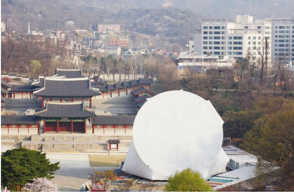
Şekil 7.22: Transformer'ın bir görüntüsü (Prada, 2009)
