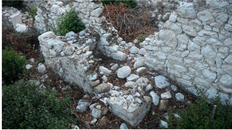
Şekil 52. Kuzey köşe odasının doğusundaki tonozlu mekân, doğudan bakış
