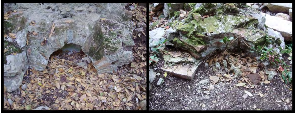
Şekil 112. Mekân F duvarlarında görülen nişler
