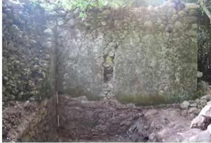
Şekil 54. Güney ek mekân doğu duvar
