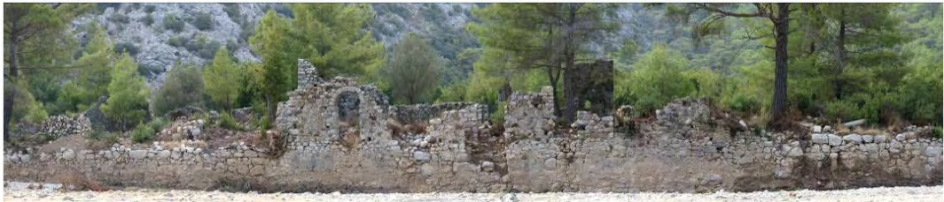
B) Giriş Kompleksi güney cephe genel görünüşü.
