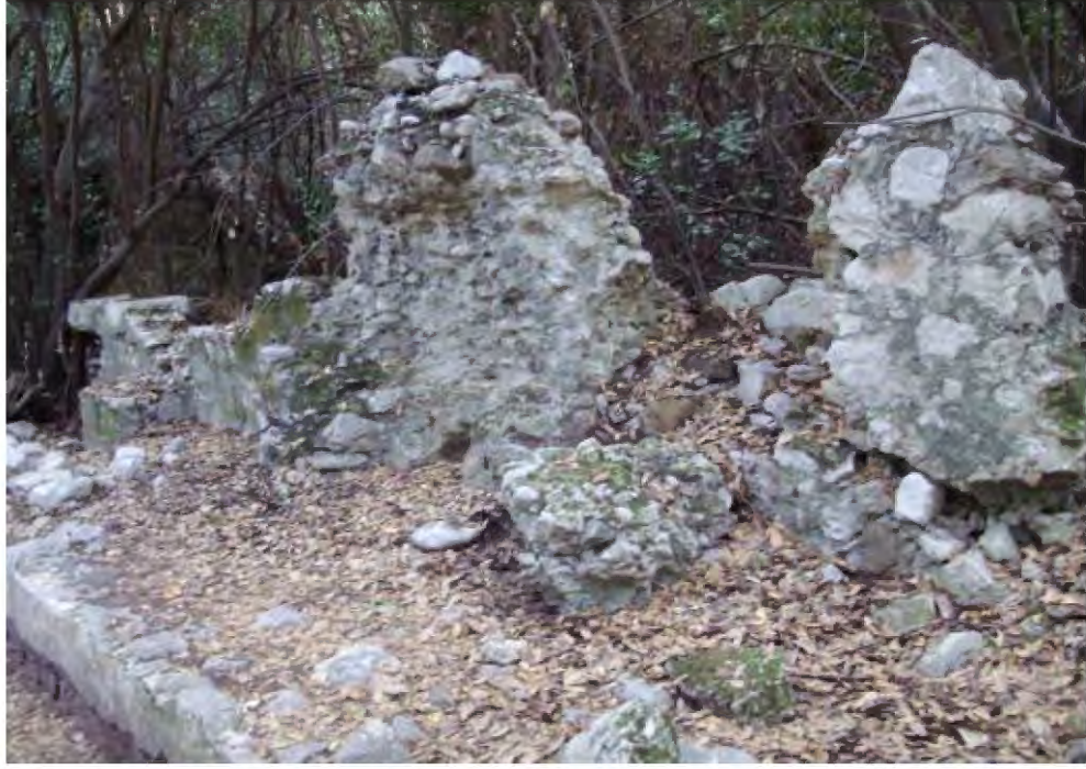
Şekil 111. Mekân F, kuzeyden bakış
