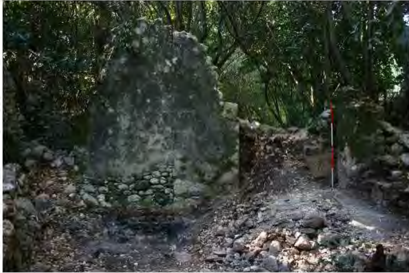
Şekil 72. Atrium güney duvar, kilisenin kuzey köşe odası ve transept kolu bağlantısı
