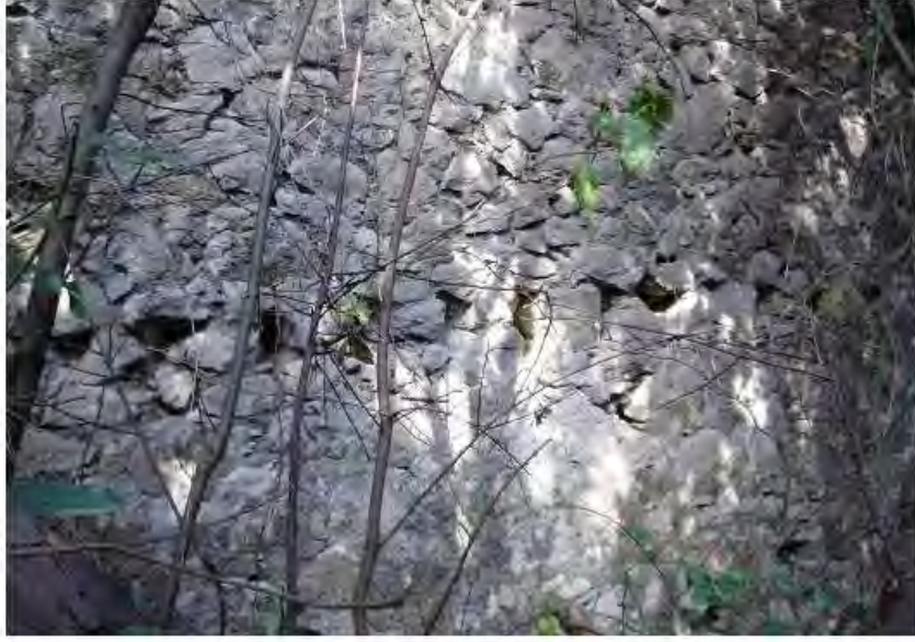
Şekil 71. KEM4'ün kuzey duvarında görülen hatıl delikleri
