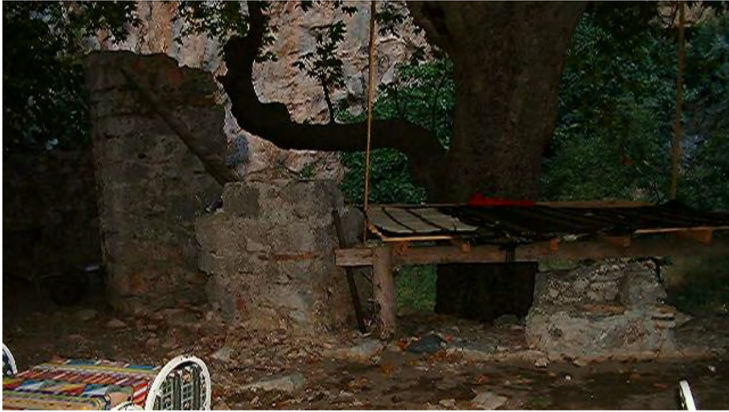
B) S11-V sektöründe yer alan kilise, apsis duvarı dış cephe.
