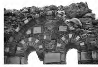
E) Latmos 8 Nolu Kilise Kuzey Cephe
