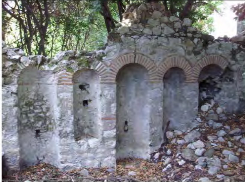
Şekil 63. Vaftizhane vestibulum 'u batı duvarda yer alan çeşme
