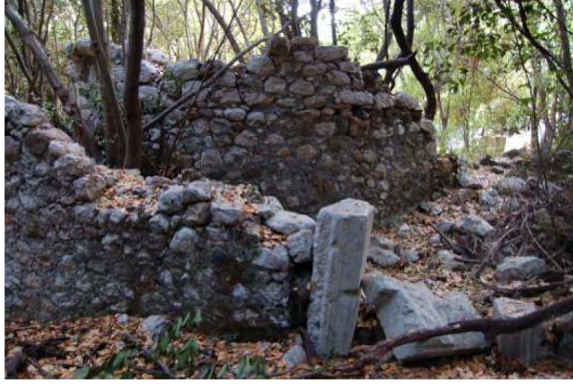
Şekil 51. Kuzey köşe odası doğu duvarındaki kapı açıklığı ve arkada apsis duvarı, doğudan bakış
