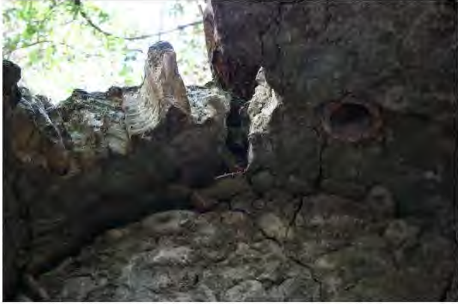
Şekil 69. KEM2 tonoz içerisinde dikey olarak yer alan pişmiş toprak künkler
