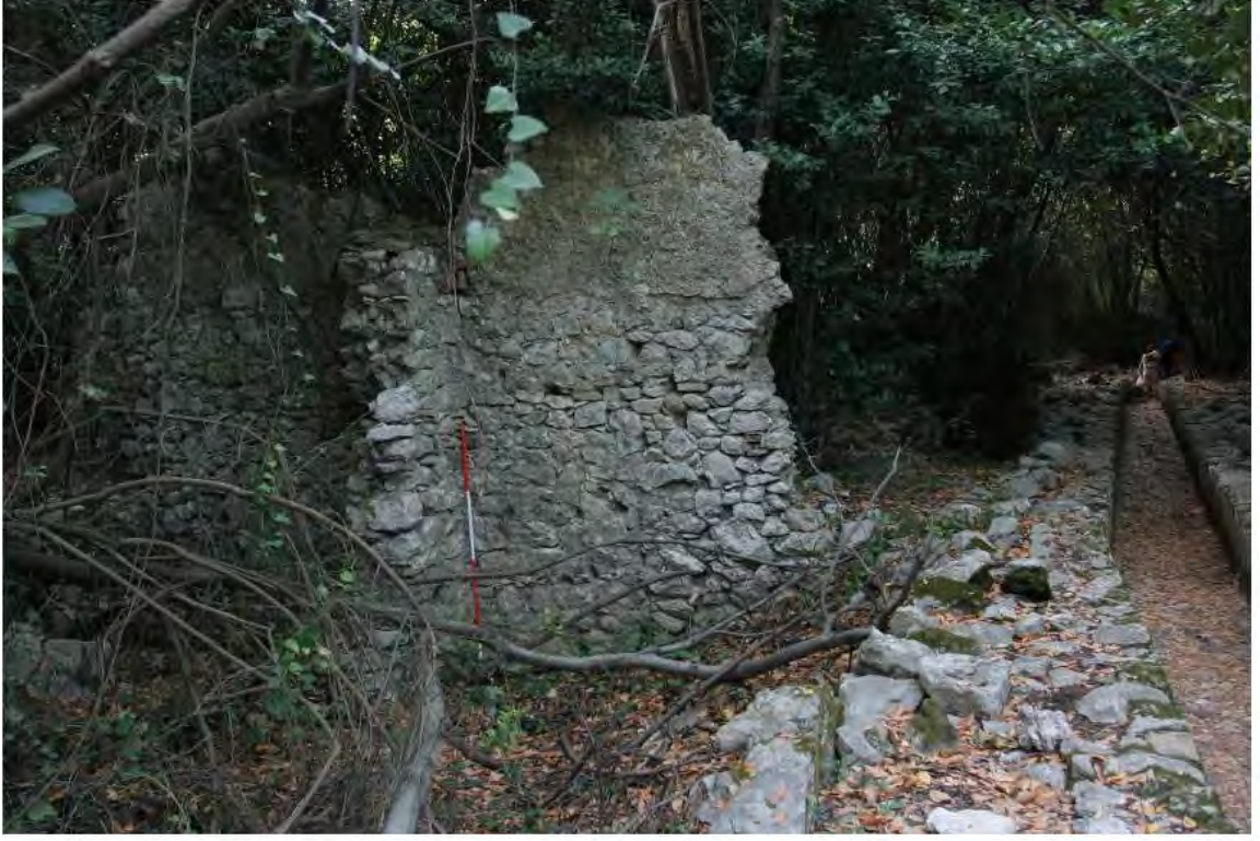
Şekil 110. Mekân G kuzey duvar
