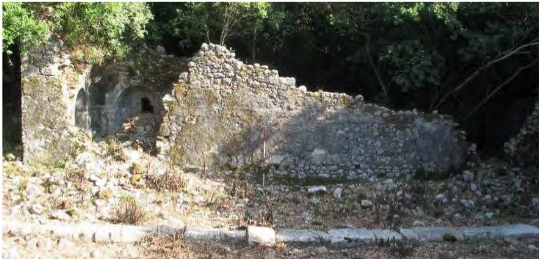
Şekil 49. Naos güney duvar ve güney nef
