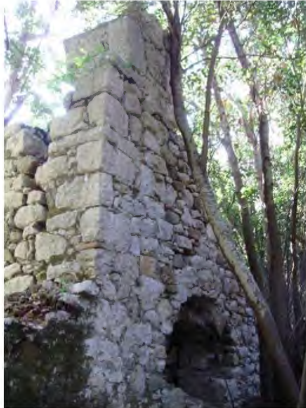
Şekil 86. Triclinium kuzey cephe batı bölümü ve kapatılmış kapı açıklığı
