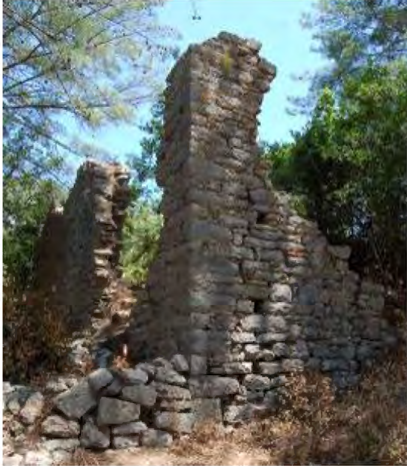
Şekil 30. Episkopeion güney cephe batı köşesi
