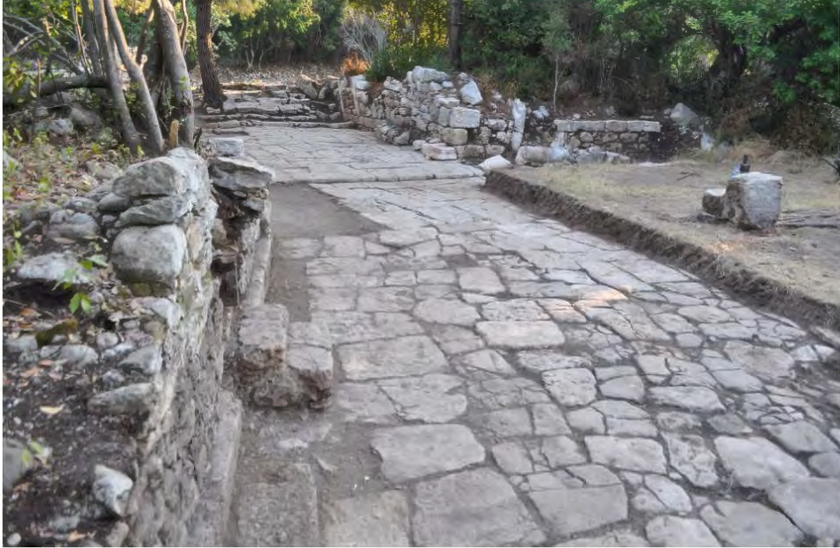
Şekil 11. Köprü Caddesi ve köprü bağlantısı sağlayan merdivenler, güneyden bakış.
