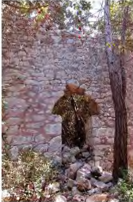
Şekil 35. Episkopeion batı cephe üzerinde M7'ye açılan kapı açıklığı
