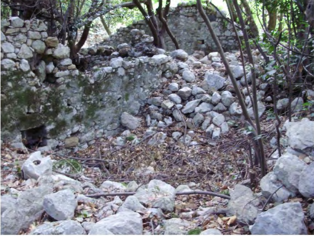
Şekil 122. M16 kuzeydoğudan görünüş
