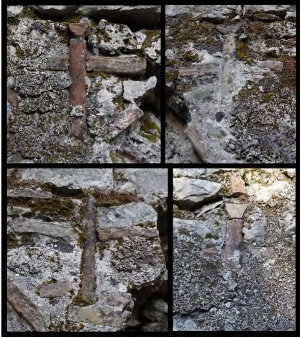
Şekil 104. Çeşme duvarında yer alan tuğla haç motifleri
