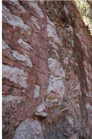
Şekil 42. Episkopeion kuzey cephe üzerinde görülen kesilmiş duvar izlerinden en batıdaki, detay
