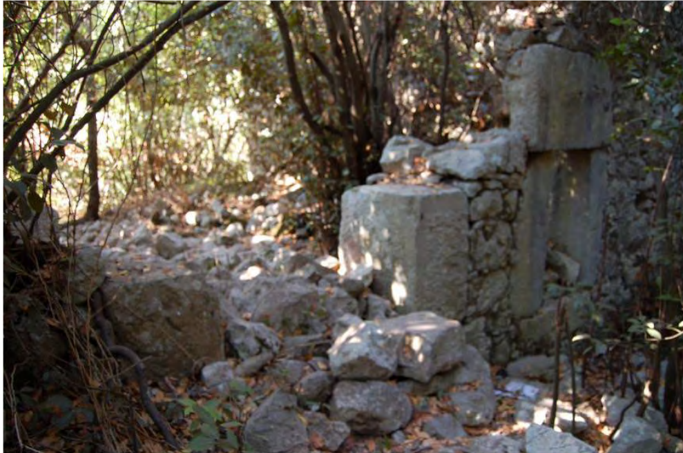
Şekil 119. M12'in kuzey duvarında görülen kapı ve pencere düzenlemesi
