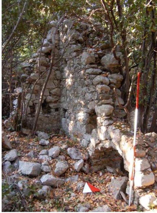
Şekil 118. M8 doğu duvar ve giriş kapısı
