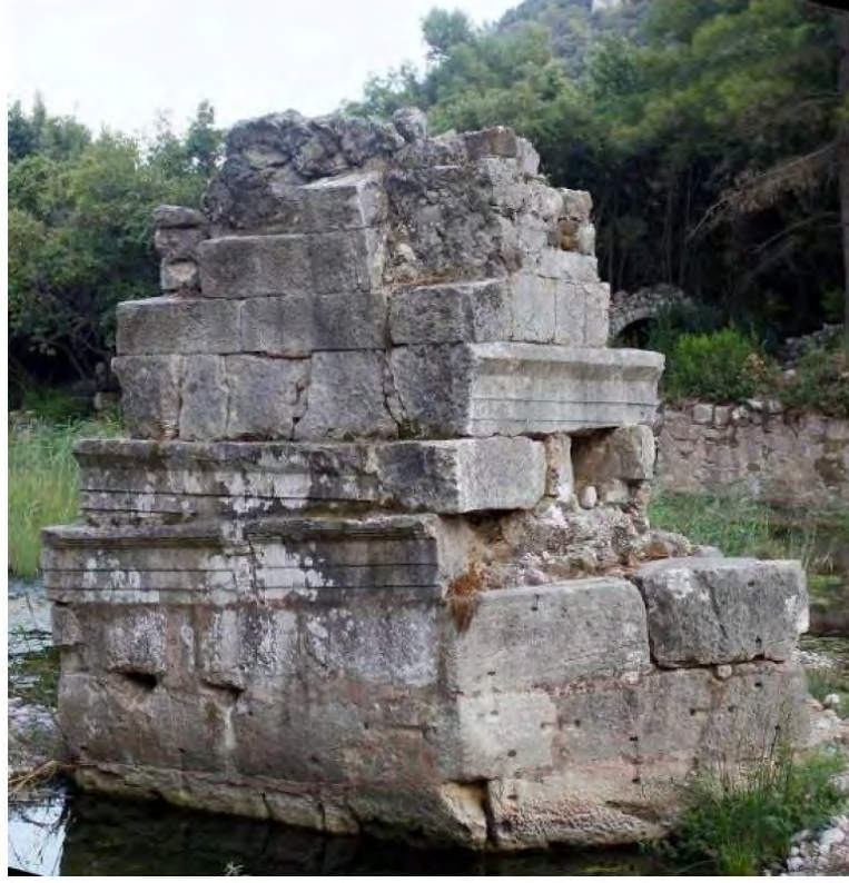
Şekil 10. Kuzey köprü ayağı, batıdan bakış
