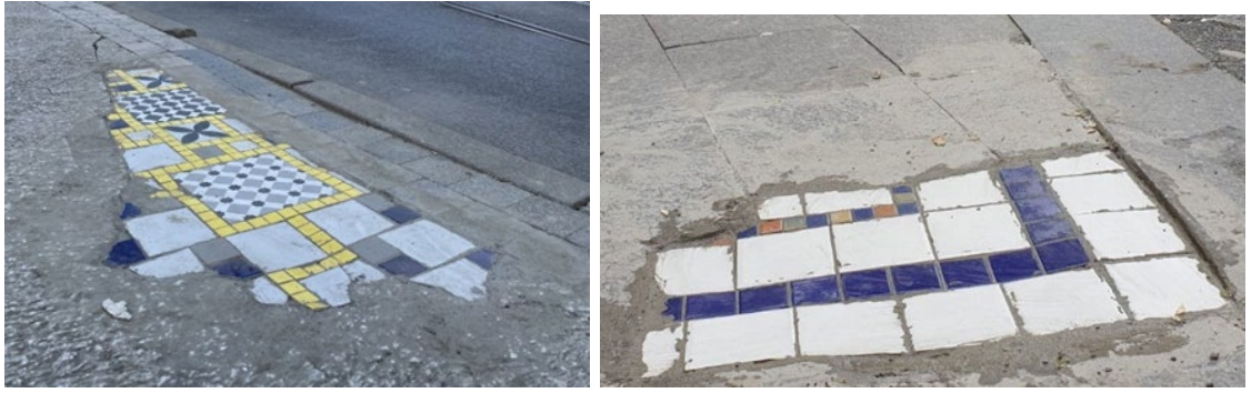
Görsel 2.44. (Solda) Kadıköy Belediyesi, kaldırım onarımı, 2021, İstanbul Görsel 2.45. (Sağda) Kadıköy Belediyesi, kaldırım onarımı, 2021, İstanbul
