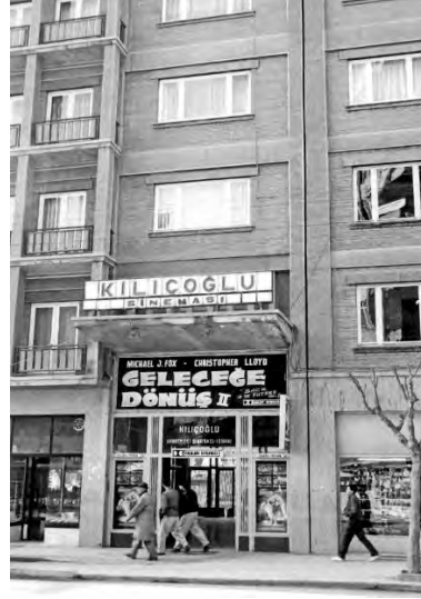
Görsel 7.4. Eski Kılıçoğlu Sineması Girişi ( http-99 )
