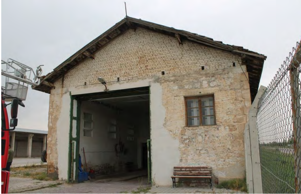
Görsel 3. 85. Fabrikanın güneydoğu cephesi (25.07.2018)
