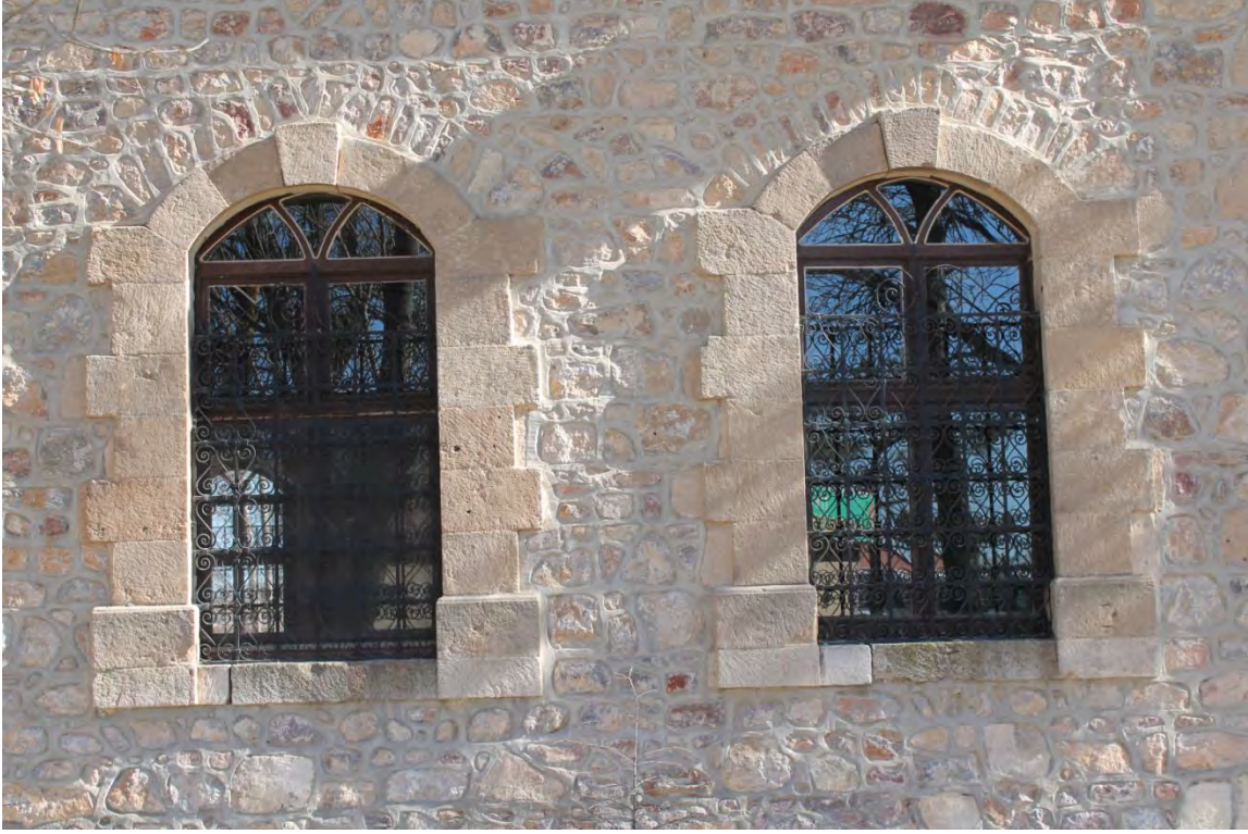
Görsel 3.104. Hâra (Karakışla ) Camii'nin batı cephesinde yer alan pencereler (26.03.2018)
