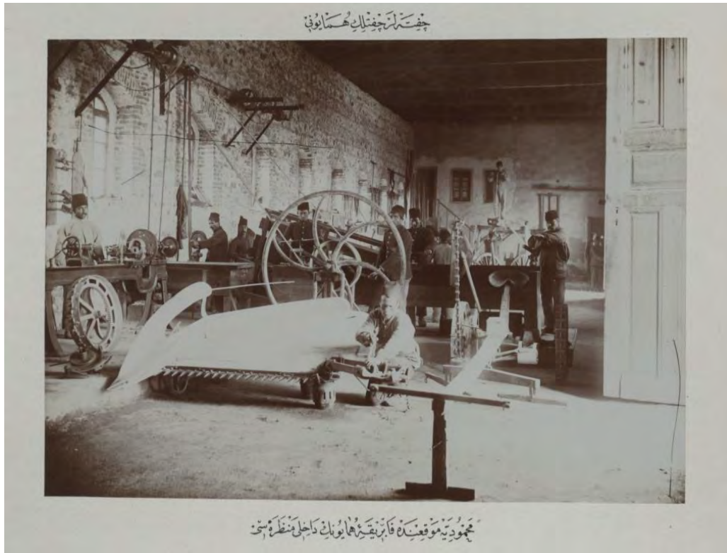
Görsel 3. 81. Mahmudiye mevkiinde bulunan fabrikanın içten görünüşü açıklamalı fotoğraf (İÜNEKA, 90603/21).
