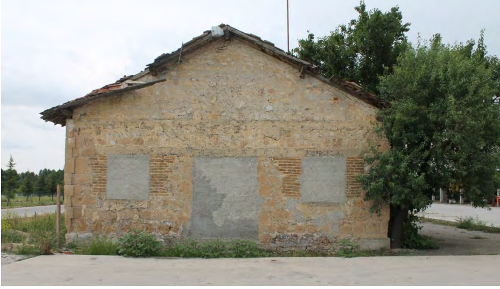
Görsel 3. 84. Fabrikanın kuzeybatı cephesi (25.07.2018)
