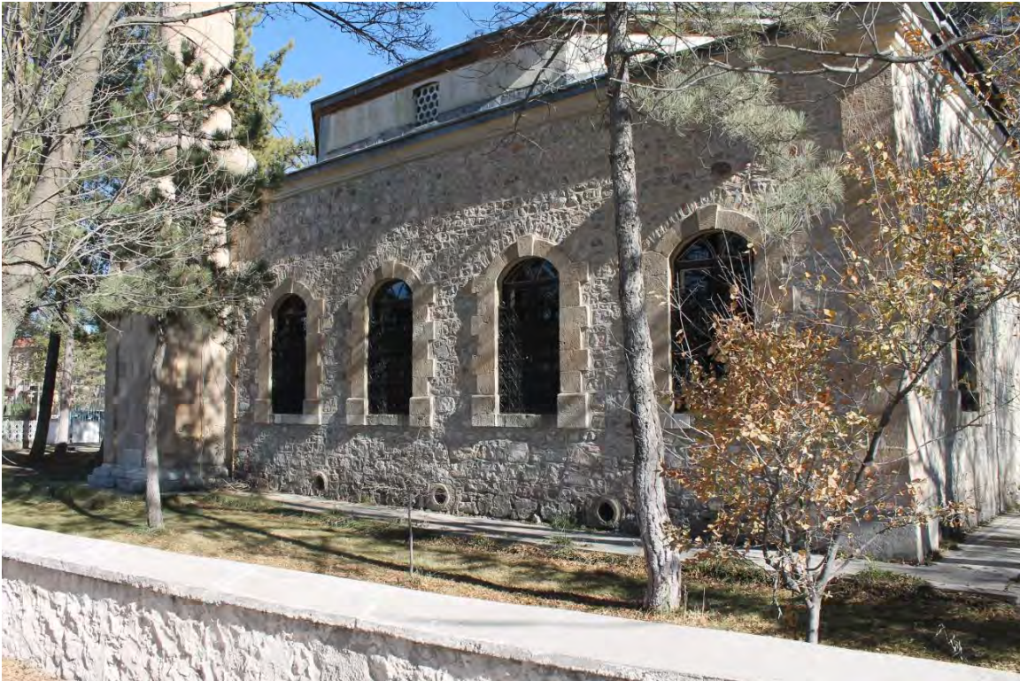
Görsel 3.103. Hâra (Karakışla ) Camii'nin batı cephesine güneybatıdan bakış (26.03.2018)
