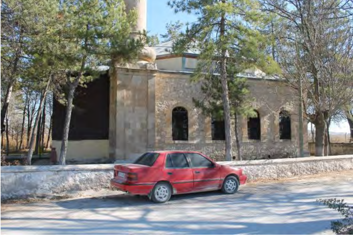
Görsel 3.102. Hâra (Karakışla ) Camii'nin batı cephesine kuzeybatıdan bakış (26.03.2018)
