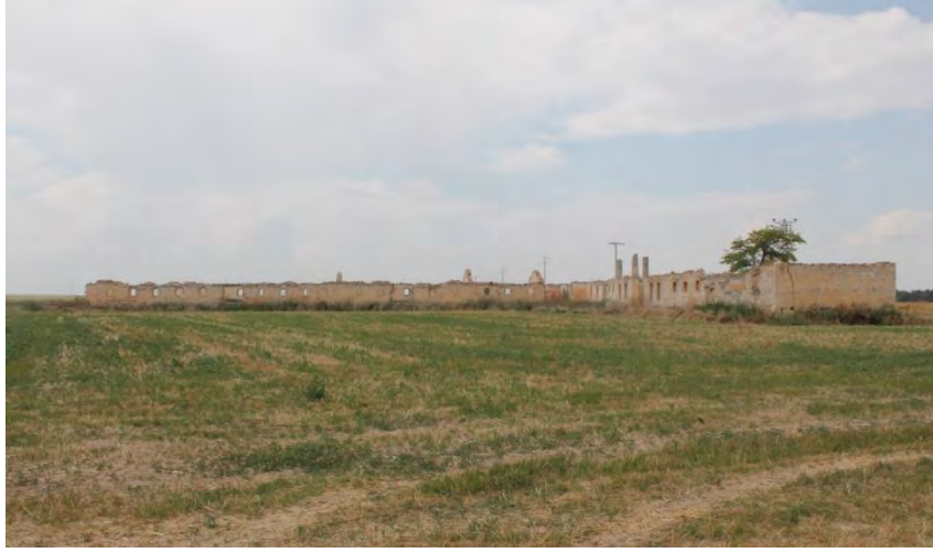
Görsel 3. 148. Mandıra Kışla-i Hümayunu'na güneyden bakış (güneydoğu ve güneybatı cepheleri) (25.07.2018)
