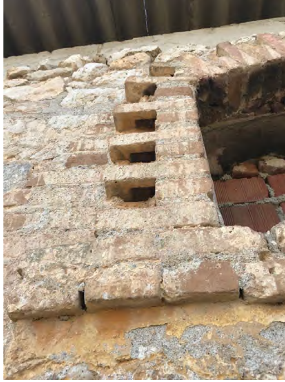
Görsel 3. 140. Hamidiye Kışla-i Hümayunu'nun güneydoğu duvarında bulunan pencere söve detayı (25.07.2018)
