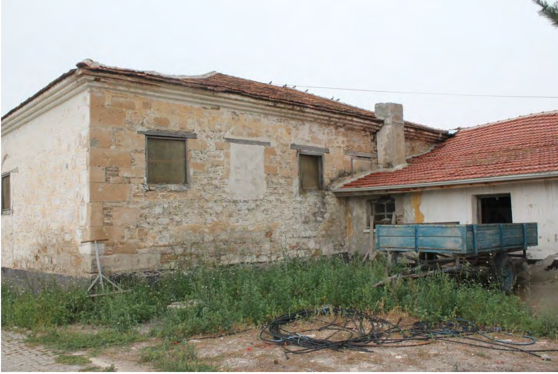
Görsel 3. 75. Kuzeybatı cephesinde bulunan pencerelerin yakından görünümü (2) (25.07.2018)
