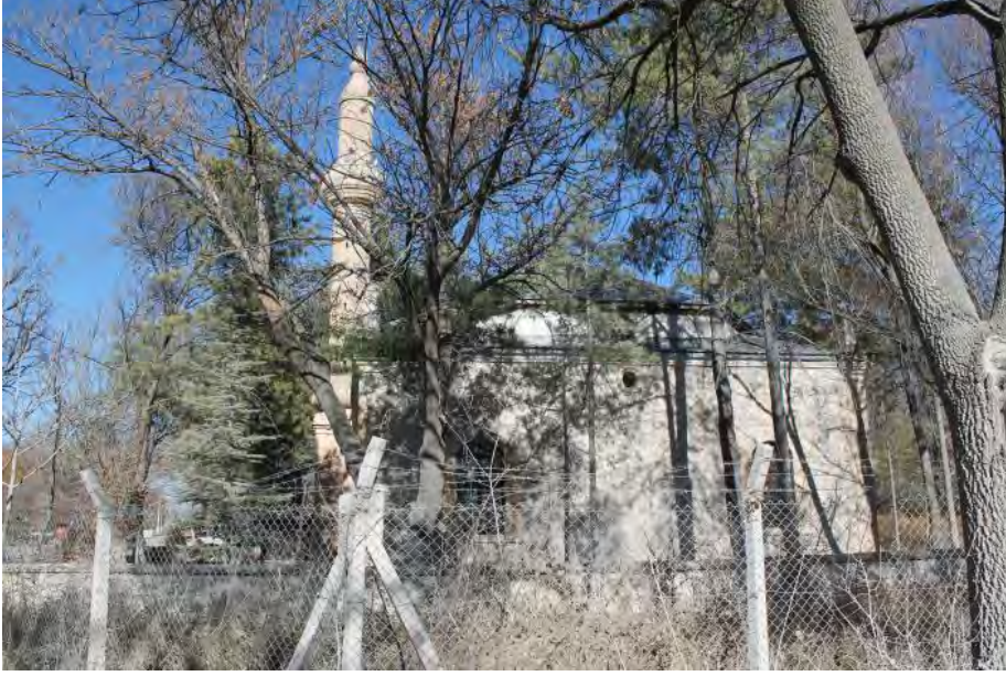
Görsel 3. 106. Hâra (Karakışla) Camii'nin güney cephesi (26.03.2018)
