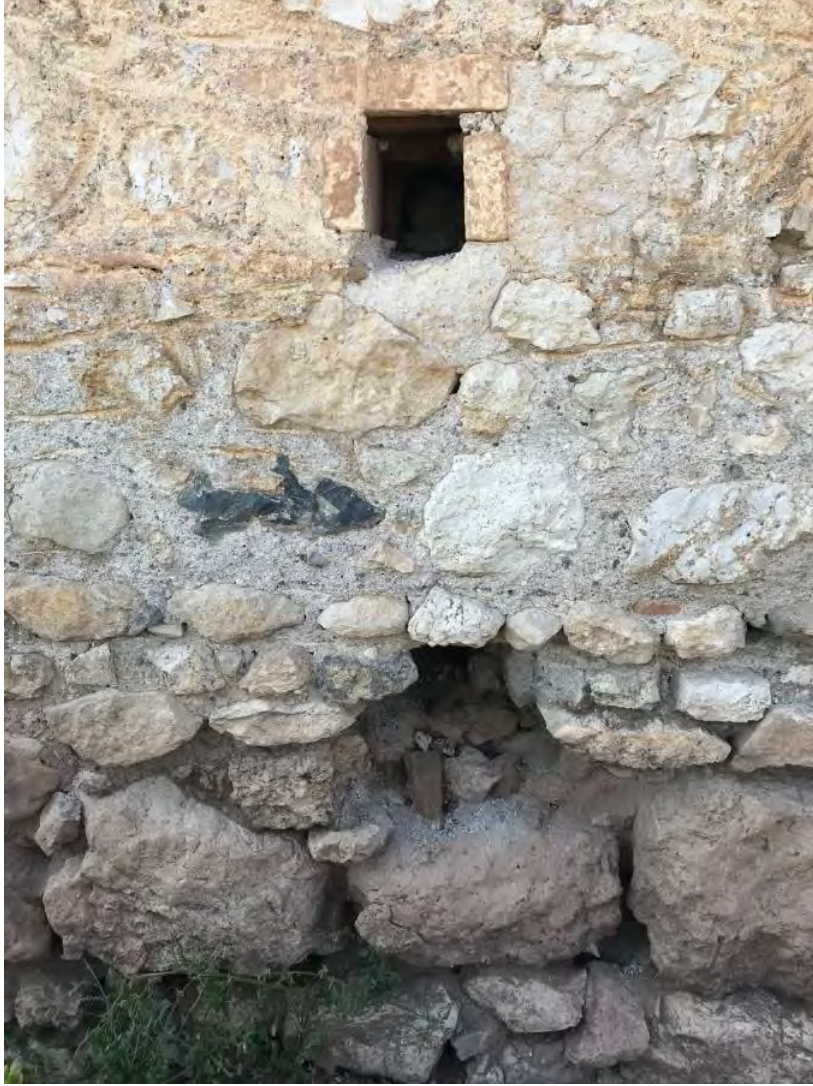
Görsel 3. 142. Hamidiye Kışla-i Hümayunu'nun güneydoğu duvarında bulunan büz (künk) detayı (25.07.2018)
