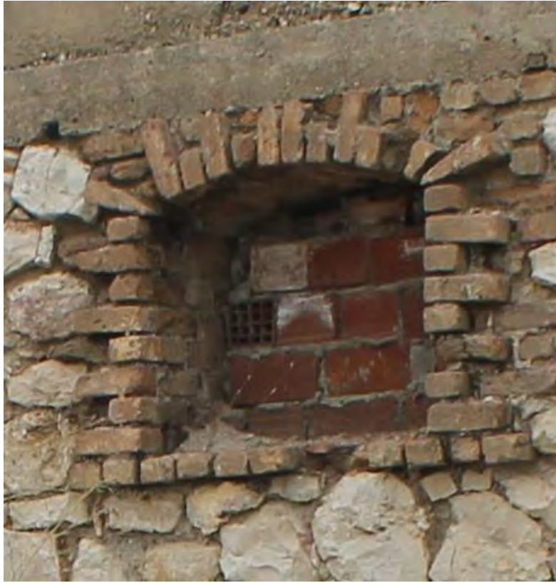
Görsel 3. 141. Pencere çevresinde kullanılan üçgen biçimli tuğlalar (25.07.2018)
