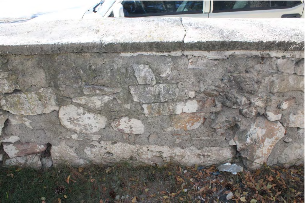
Görsel 3.96. Hâra (Karakışla) Camii'nin bahçe duvarı (26.03.2018)
