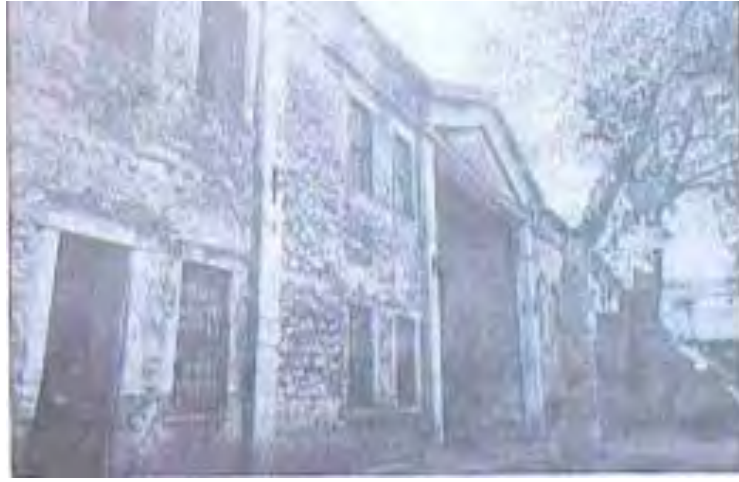
Görsel 2. 5. Dolmabahçe Sarayı İstabl-ı Amiresi'nin ön cephesinin eski bir fotoğrafı (Ünsal, 1969, s. 58)
