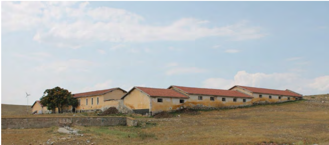
Görsel 3. 117. Aziziye Kışla-i Hümayunu'nun güneybatı ve güneydoğu cepheleri (25.07.2018)
