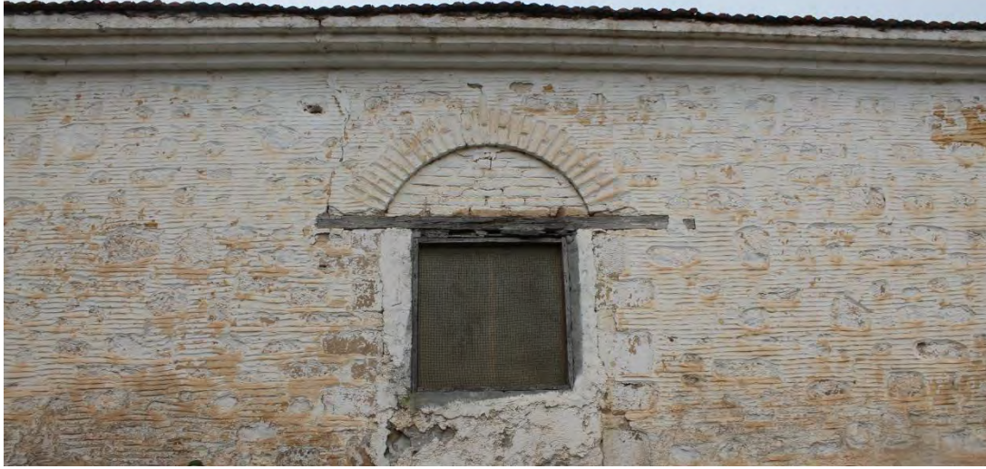
Görsel 3. 72. Güneydoğu cephesinde yer alan pencerenin yakından görünümü (25.07.2018)
