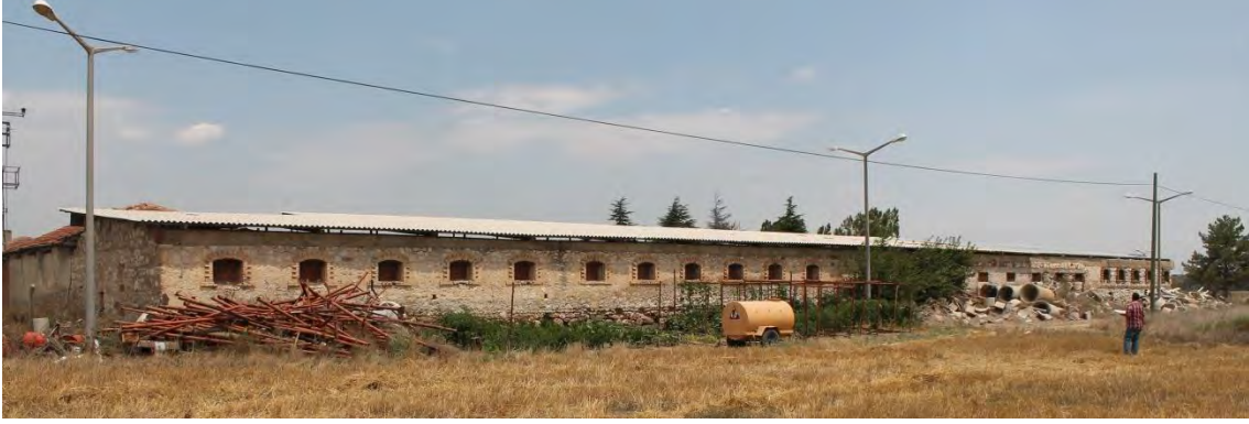
Görsel 3. 133. Hamidiye Kışla-i Hümayunu'nun güneydoğu duvarına güneyden bakış (25.07.2018)
