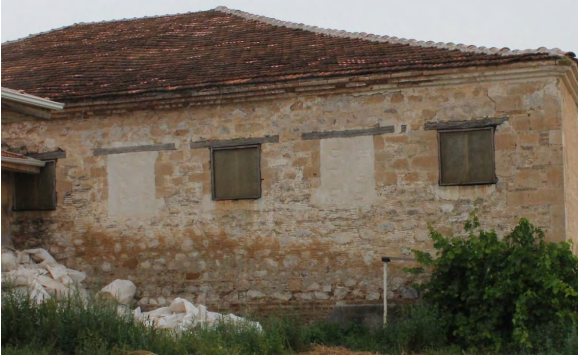
Görsel 3. 74. Kuzeybatı cephesinde bulunan pencerelerin yakından görünümü (1) (25.07.2018)
