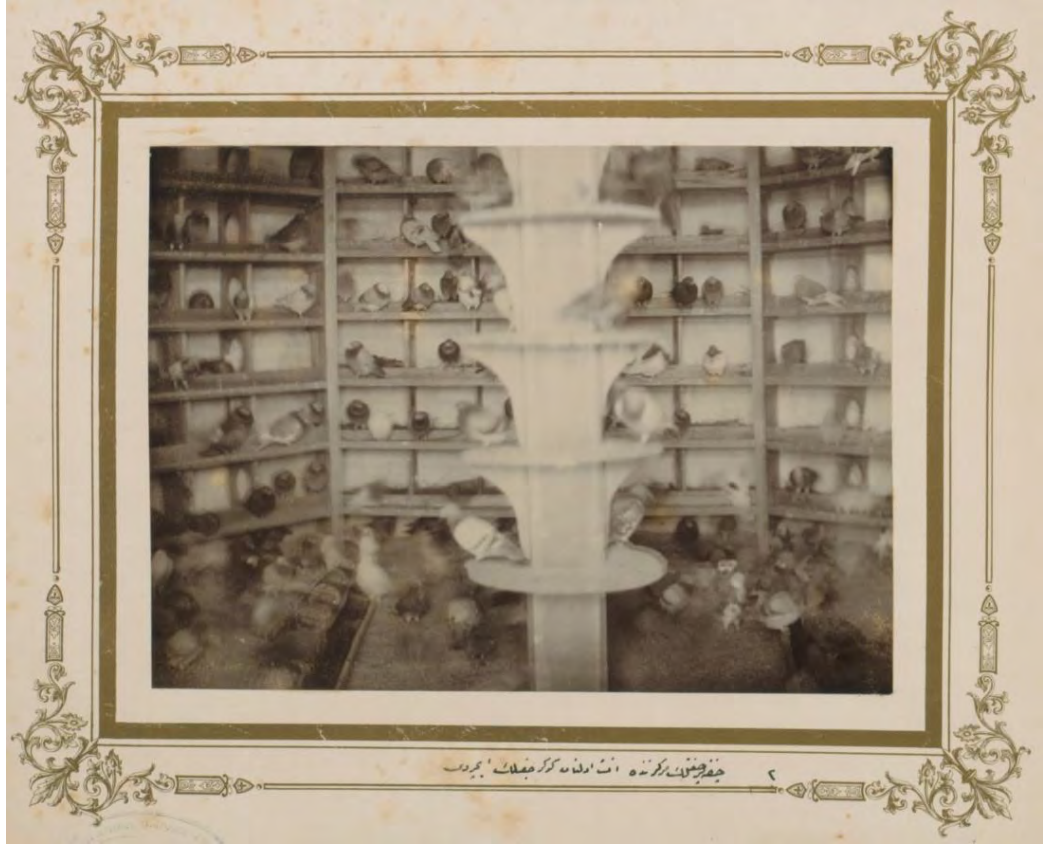
Görsel 3. 42. Çifteler çiftlik merkezinde inşa edilen güvercinliğin içeriden görünüşü açıklamalı fotoğraf (İÜNEKA, 90413/2).
