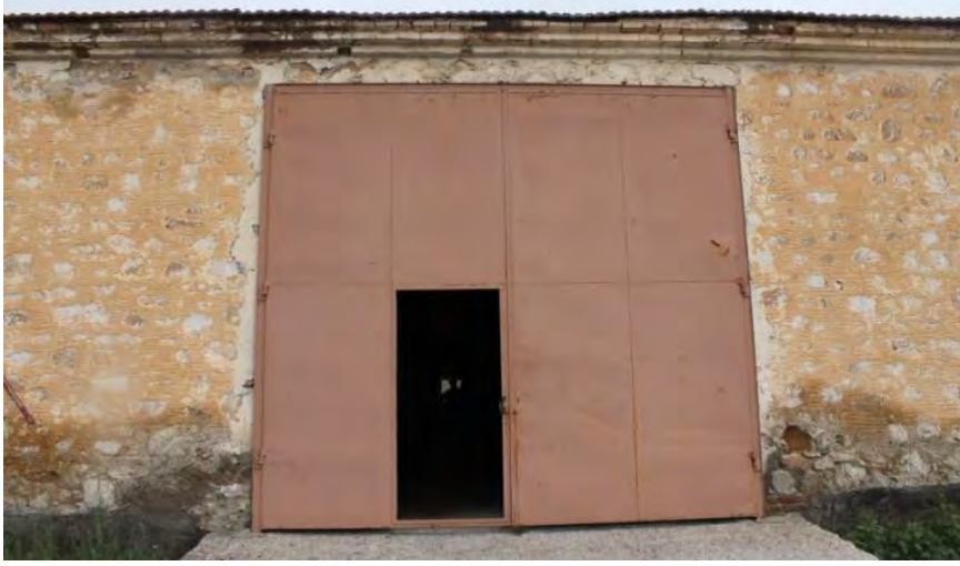
Görsel 3. 73. Güneybatı cephesinde bulunan kapının yakından görünümü (25.07.2018)
