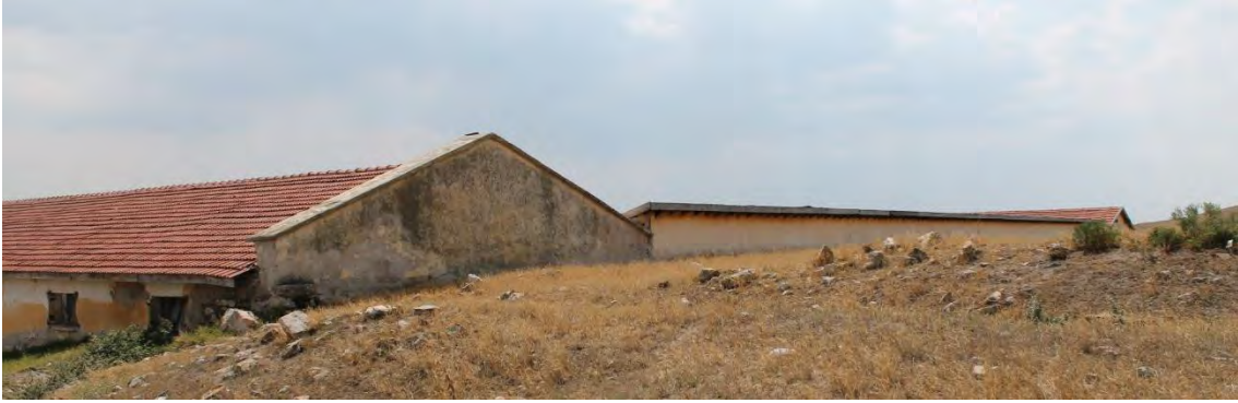
Görsel 3. 119. Aziziye Kışla-i Hümayunu'nun kuzeydoğu cephesi (25.07.2018)
