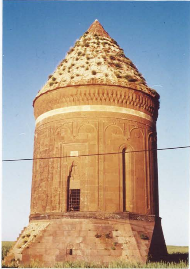
Resim 68: Usta Şagirt Kümbeti Genel Görünüşü
