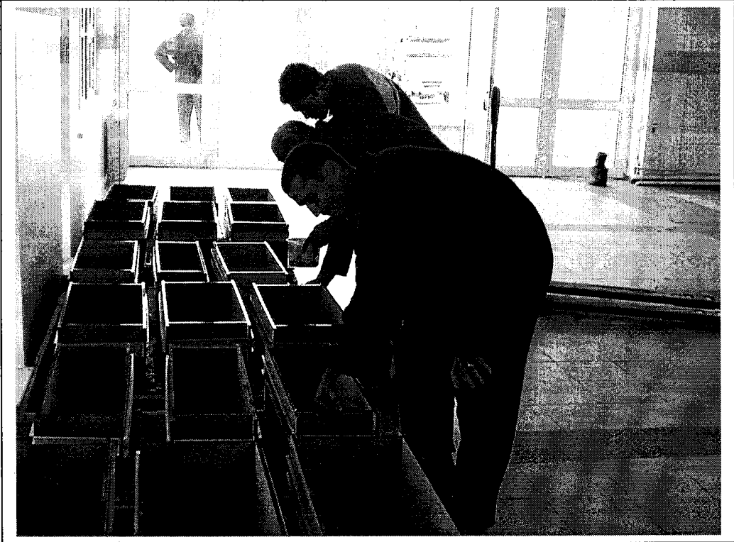
Şekil 6.4. Beton dökümü için kalıpların yağlanması işlemi
