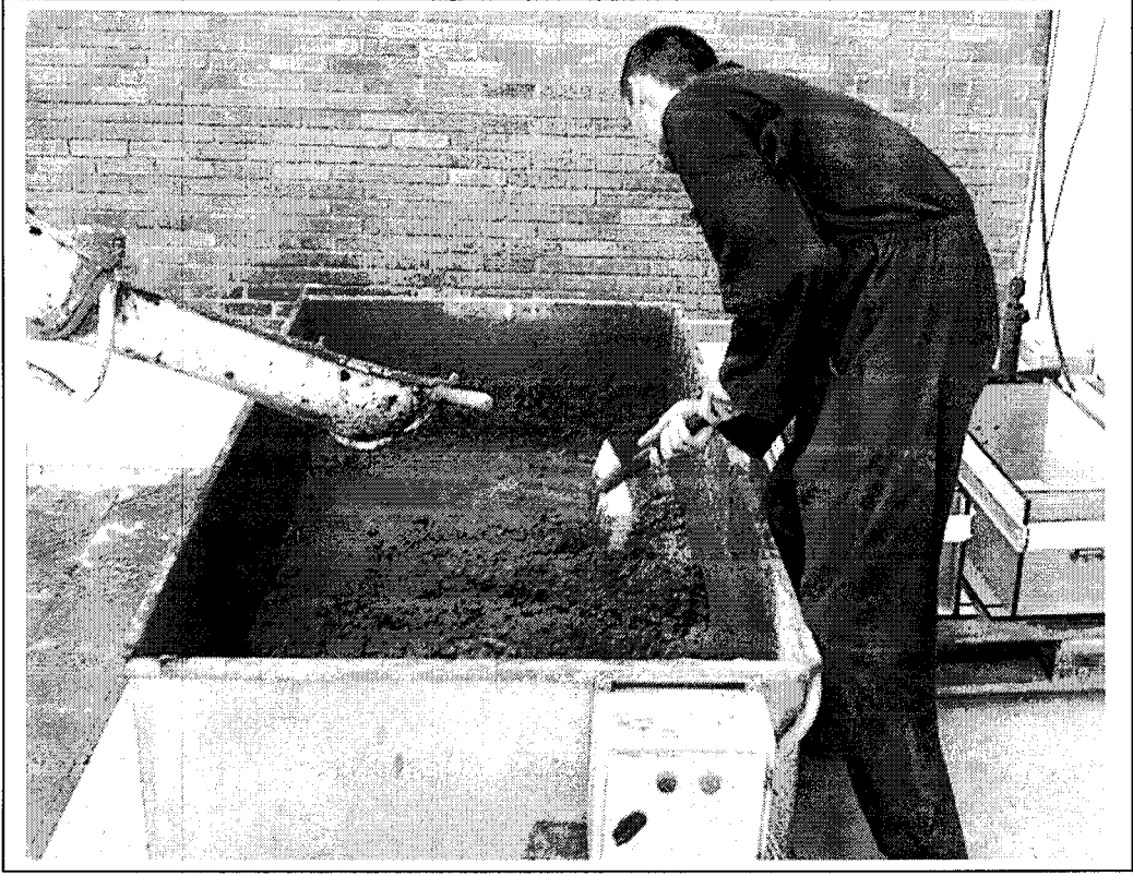
Şekil 6.5. Betonun üretildikten sonra metal hazneye dökülmesi işlemi
