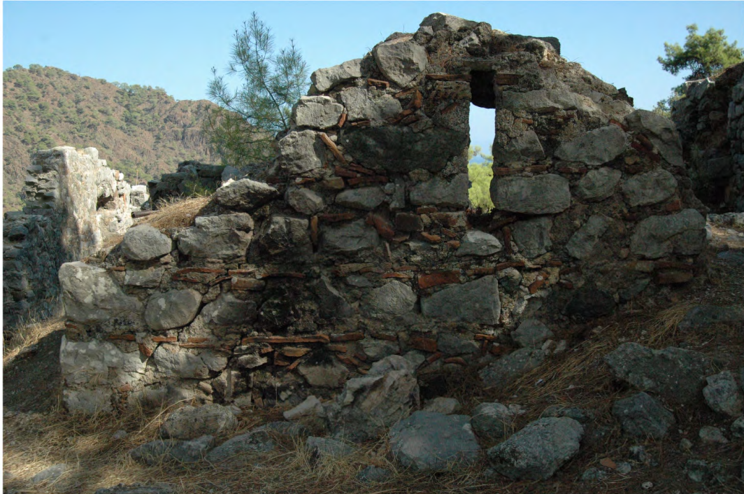
RESİM 65. Ek yapı; Mekan 1, batı cephe
