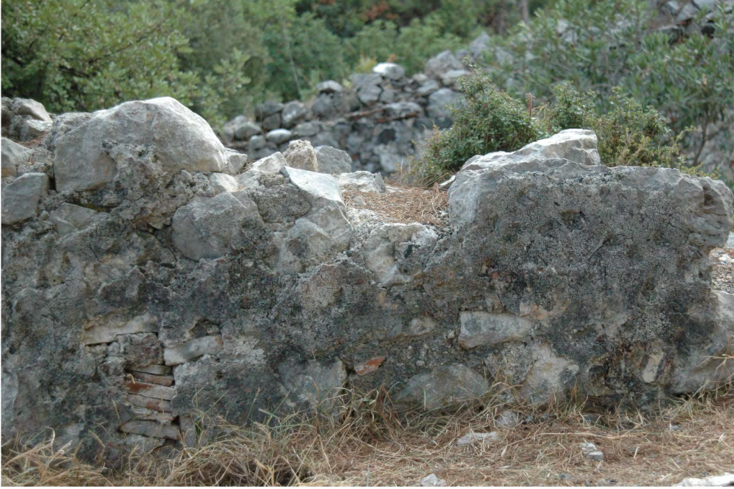
RESİM 26. Bazilika; Orta nef güney duvarı, ikinci ve üçüncü paye arası
