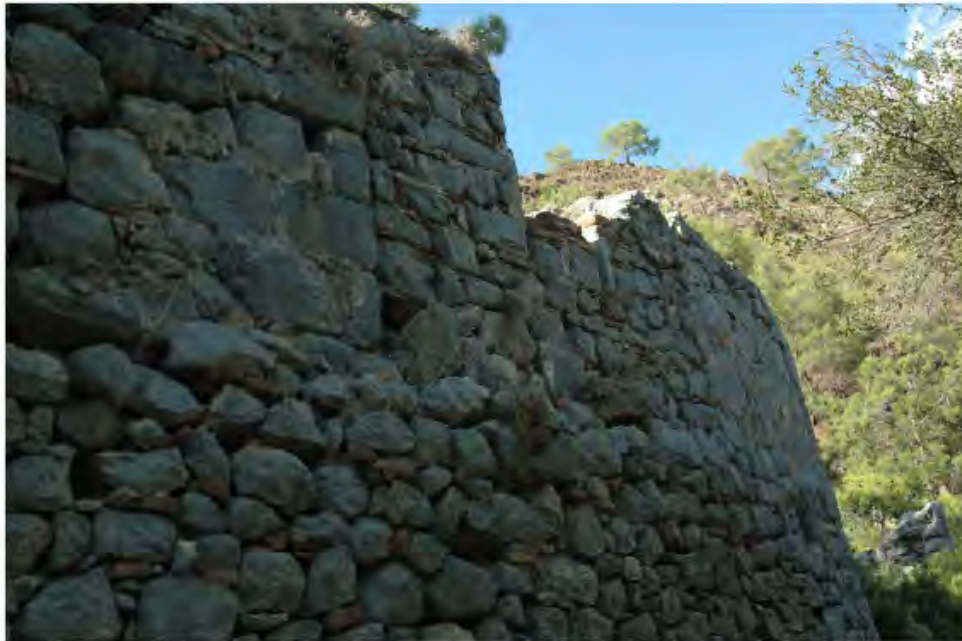
RESİM 13. Bazilika; Doğu cephe, naos duvarı
