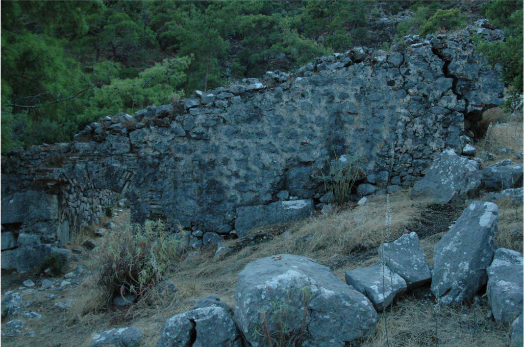
RESİM 4. Bazilika; Kuzey cephe, çevre duvarı
