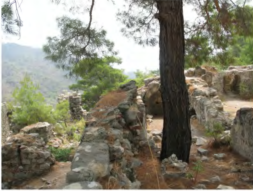
RESİM 52. Bazilika; Kuzey nef kuzey duvar üstten görünüş
