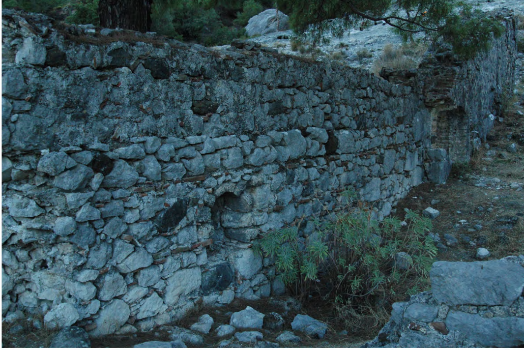
RESİM 5. Bazilika; Kuzey cephe, naos duvarı
