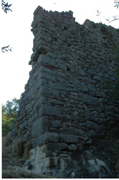
RESİM 70. Ek yapı; Mekan 3, kuzeydoğu köşe
