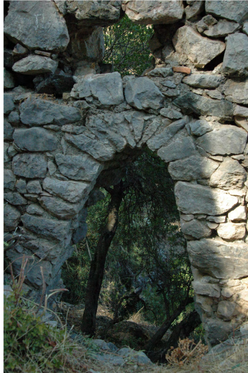
RESİM 71. Ek yapı; Mekan 3, kuzey cephe
