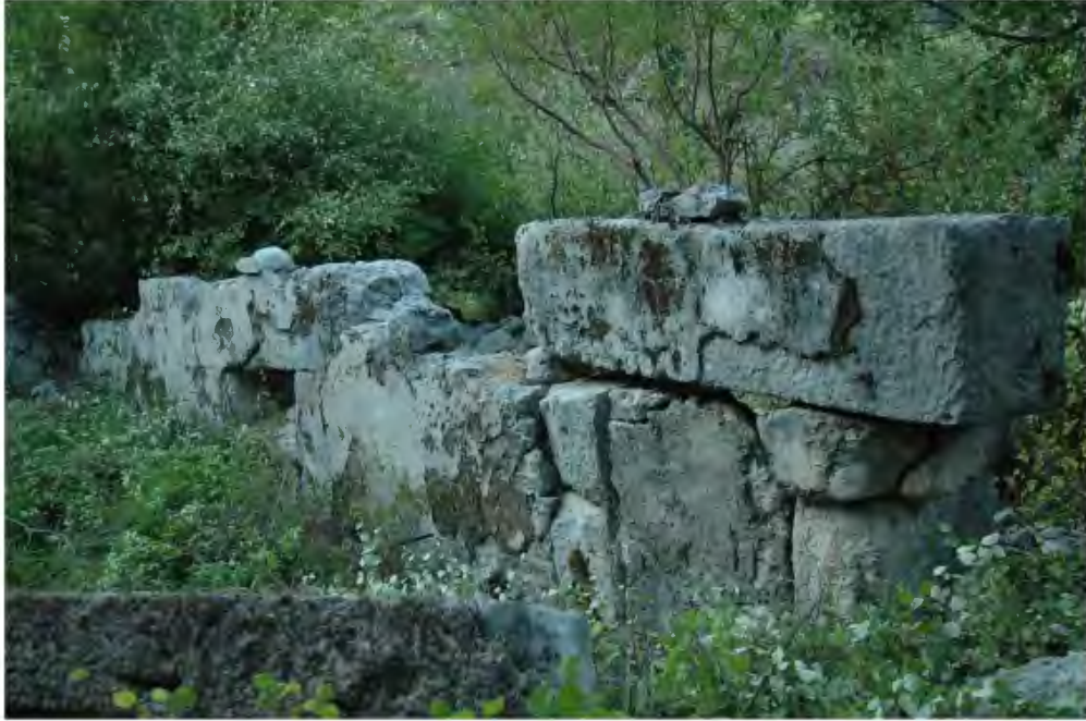
RESİM 77. Şapel, kuzey duvar
