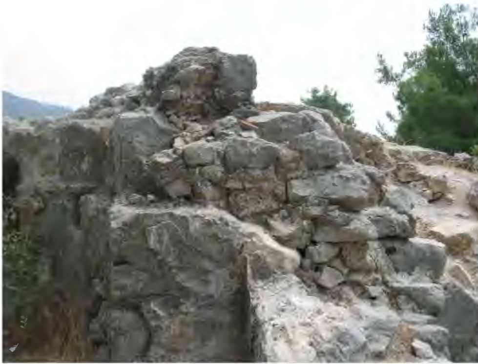
RESİM 63. Bazilika; Güney ve orta nef arasındaki tamirat izi
