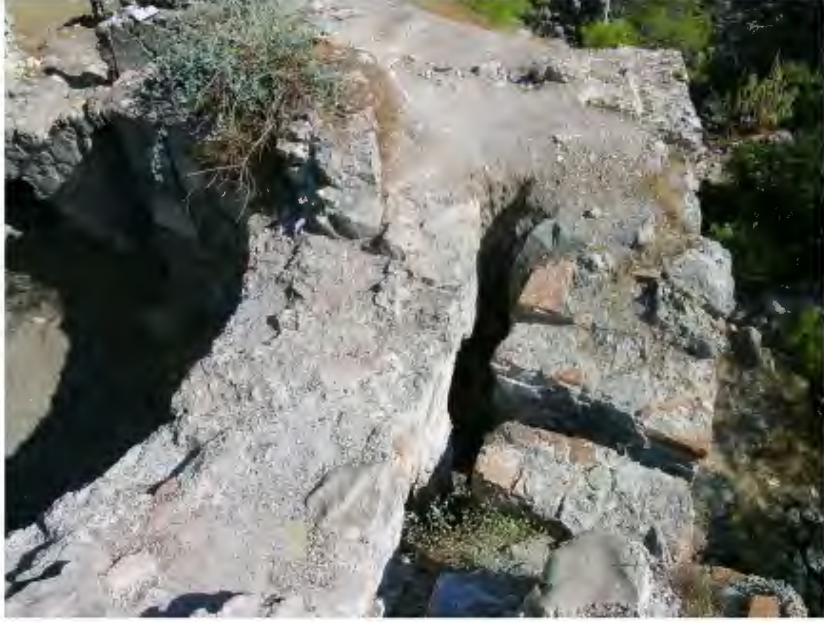
RESİM 56. Bazilika; Doğu duvar orta apsis bölümü üstten görünüş
