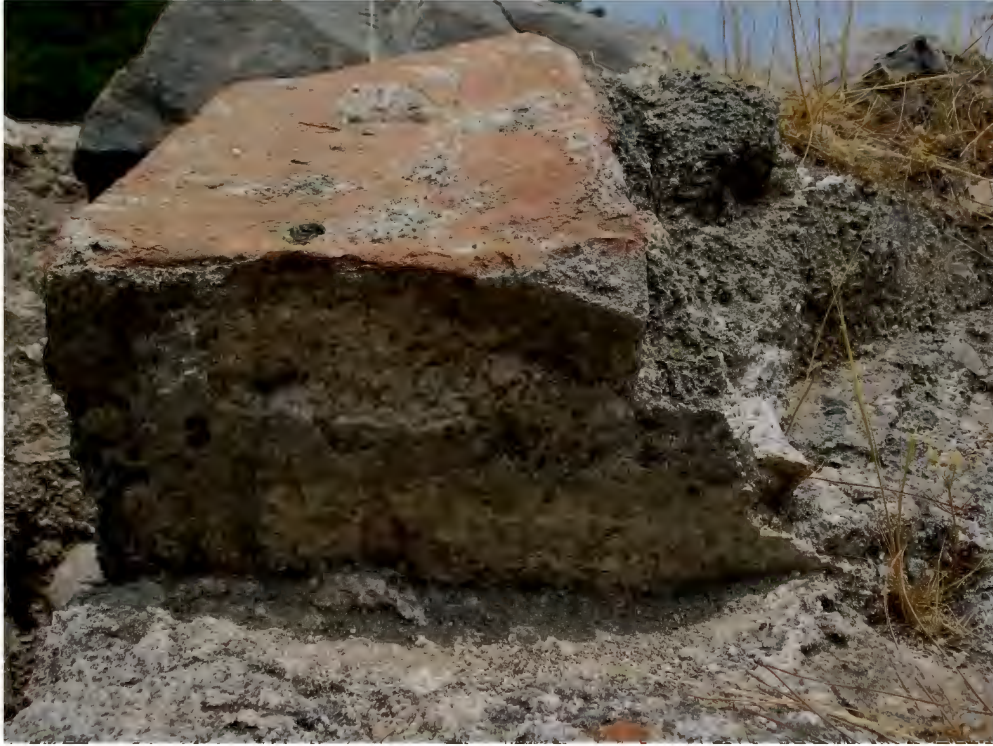
RESİM 57. Bazilika; Birinci evre orta nef pencere kemer başlangıcı
