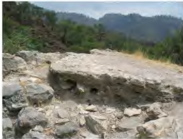
RESİM 51. Bazilika; Doğu duvar güney bölümü, üstten görünüş
