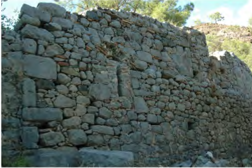
RESİM 10. Bazilika; Doğu cephe, naos duvarı
