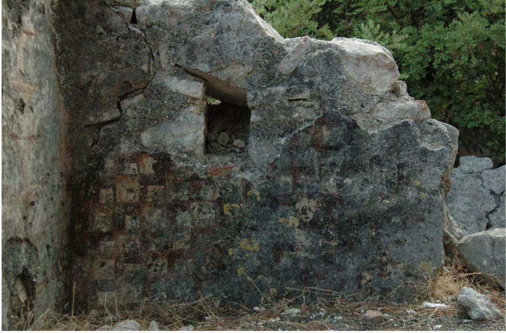
RESİM 30. Bazilika; Orta nef güney duvar, apsis ve birinci paye arası
