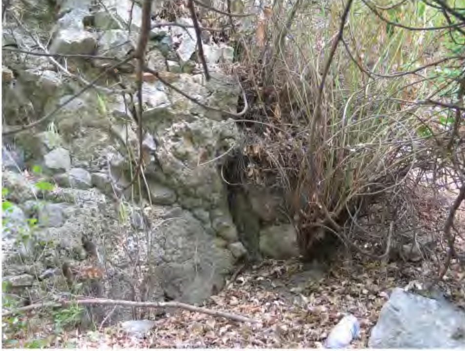
RESİM 62. Bazilika; Güney nef apsisi güney cephesi
