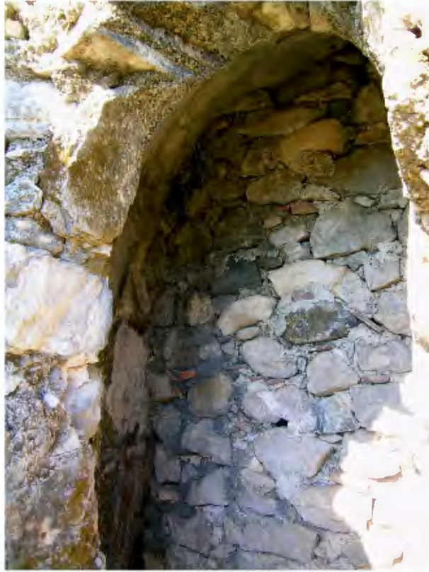
RESİM 16. Bazilika; Doğu cephe, kuzey apsis bölümü
