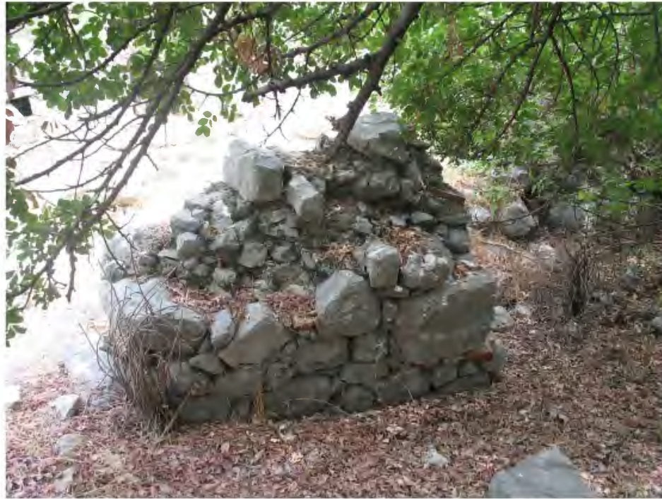
RESİM 61. Bazilika; Güney nef güney duvarı
