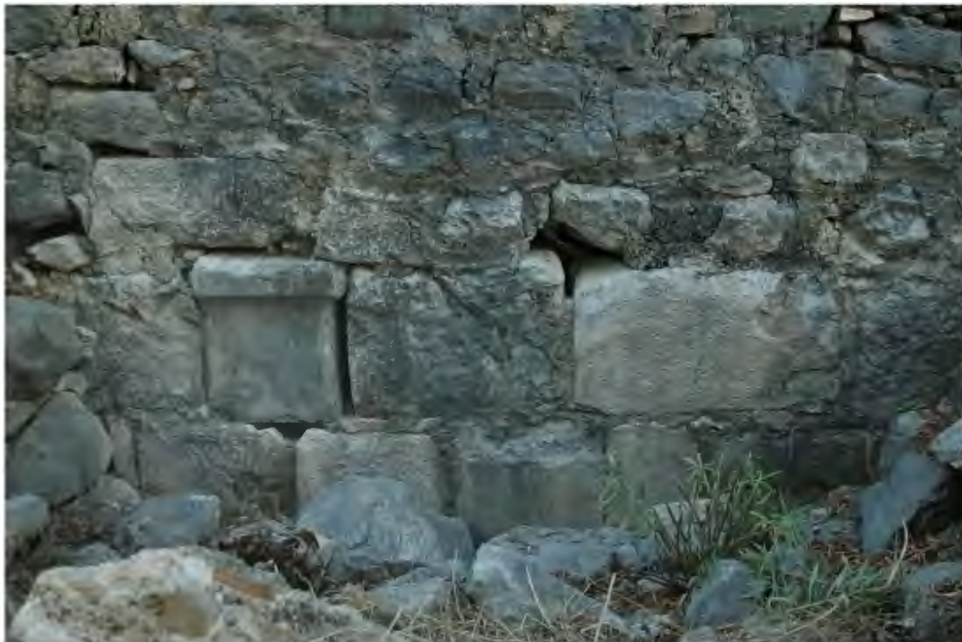
RESİM 11. Bazilika; Doğu cephe, devşirme taşlardan yapılan platform
