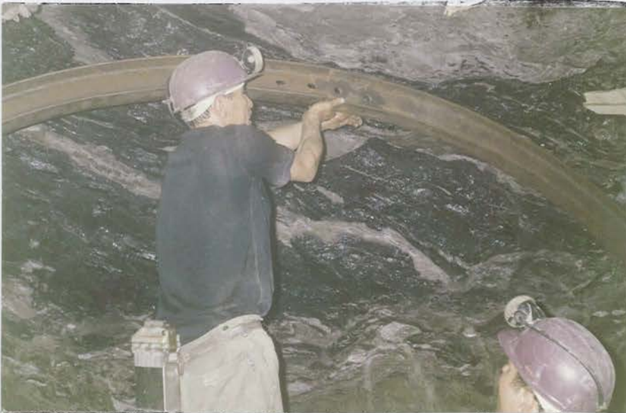
Resim: 7.7 Bağ bağlamak için yapılan çalışma
