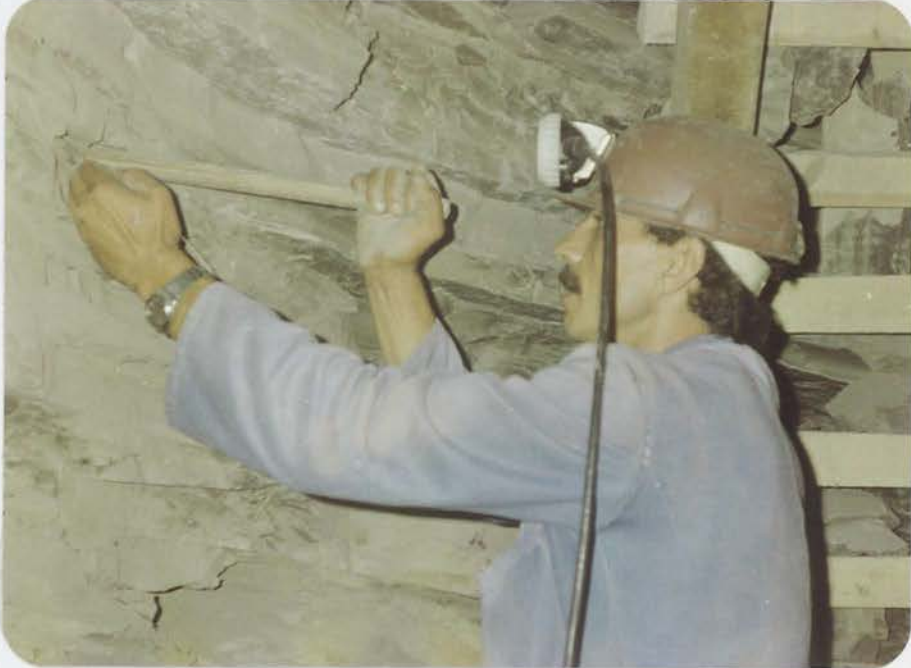
Resim: 7.2 Deliklere kartuş yerleştirilmesi
