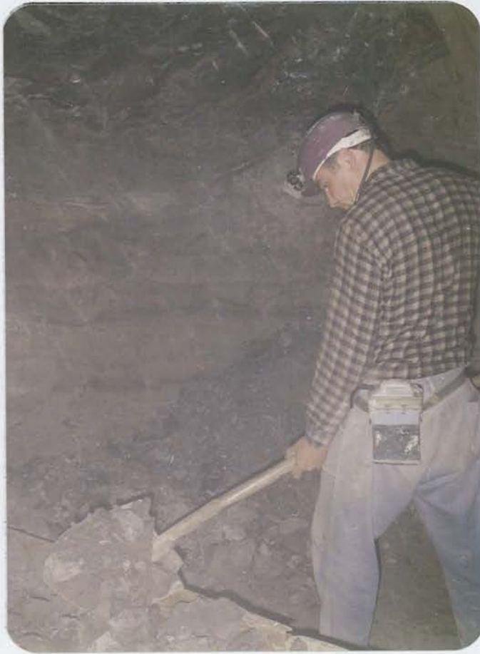
Resim:7.3 Ateşleme sonucu çıkan pasanın nakliyat ünitesine kürekle aktarılması
