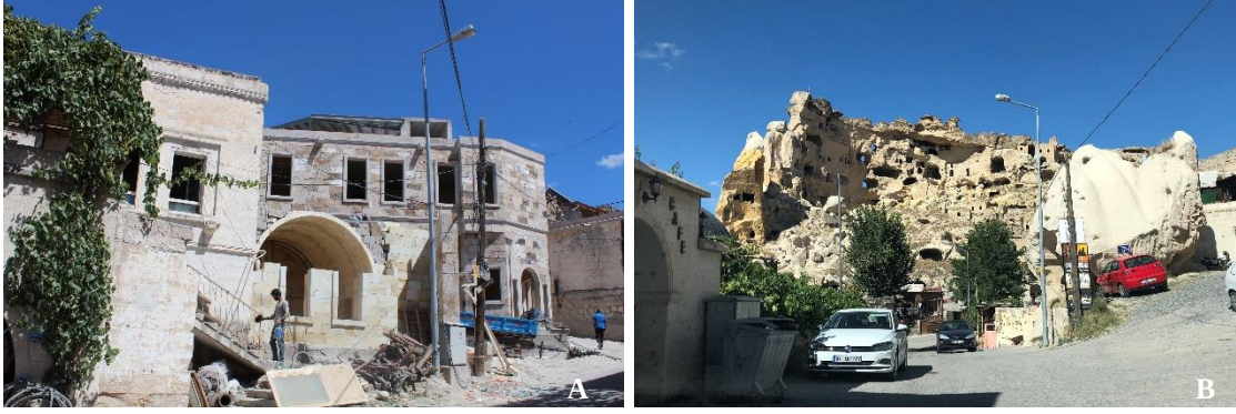
Görsel 3. 13. Kentsel sit alanlarındaki doku ile uyumsuz aydınlatma ve elektrik direkleri(A. Göreme, B. Çavuşin)
