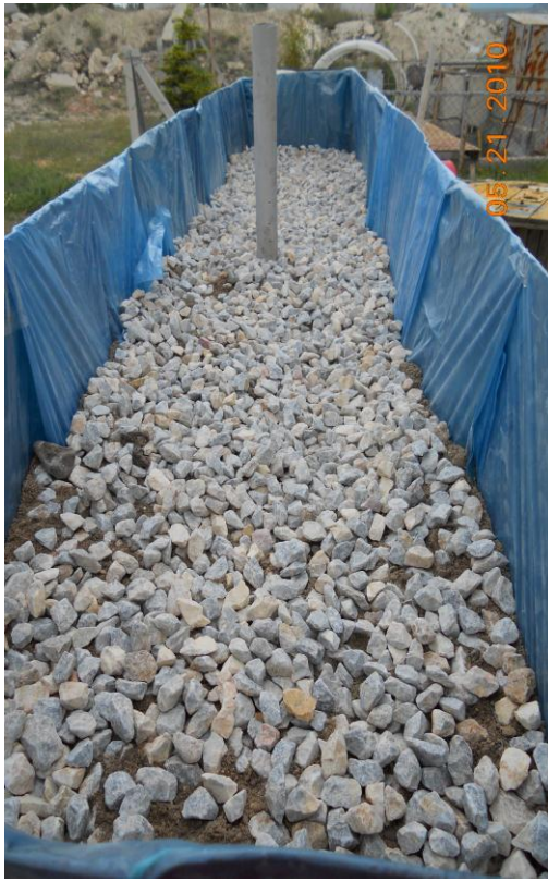
Şekil 2.4. (Devam) Bitkiler için hazırlanan yatak, dolgu malzemeleri, giriş ve çıkış yapıları
