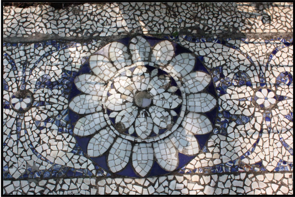
Görsel 110. Zeminde bulunan pişmiş kil mozaik uygulaması, detay, Parshwanath Tapınağı, Kalküta / Hindistan
