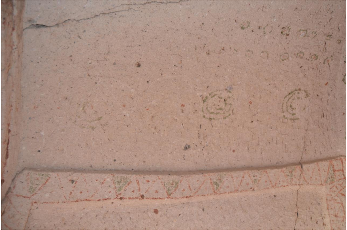
Resim 98. Şapel kuzey duvarı, silme kuşağı
