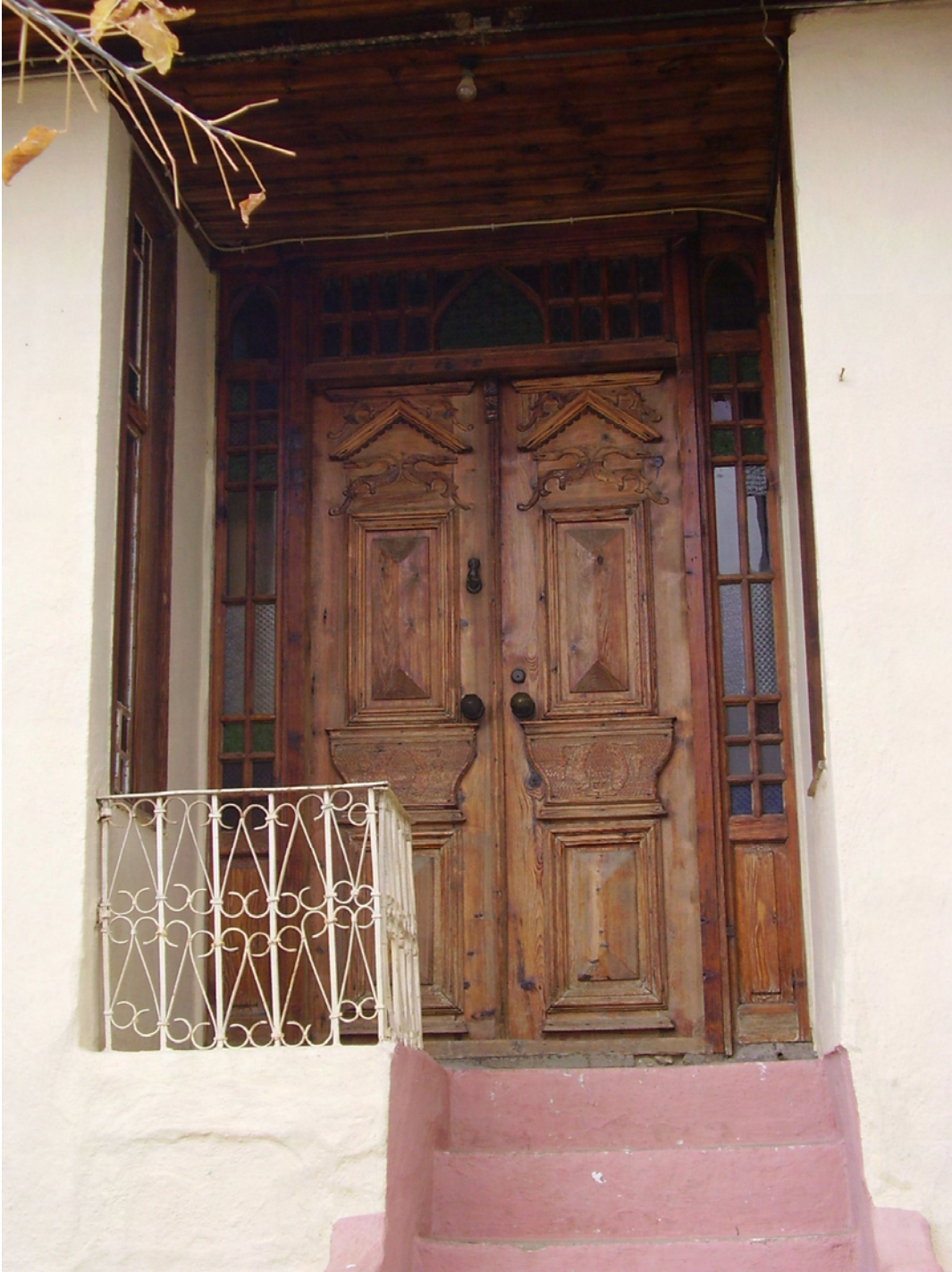
Resim 1- Pazaryeri – Yüzbaşı Mahallesi Bursa Sokak No: 29
