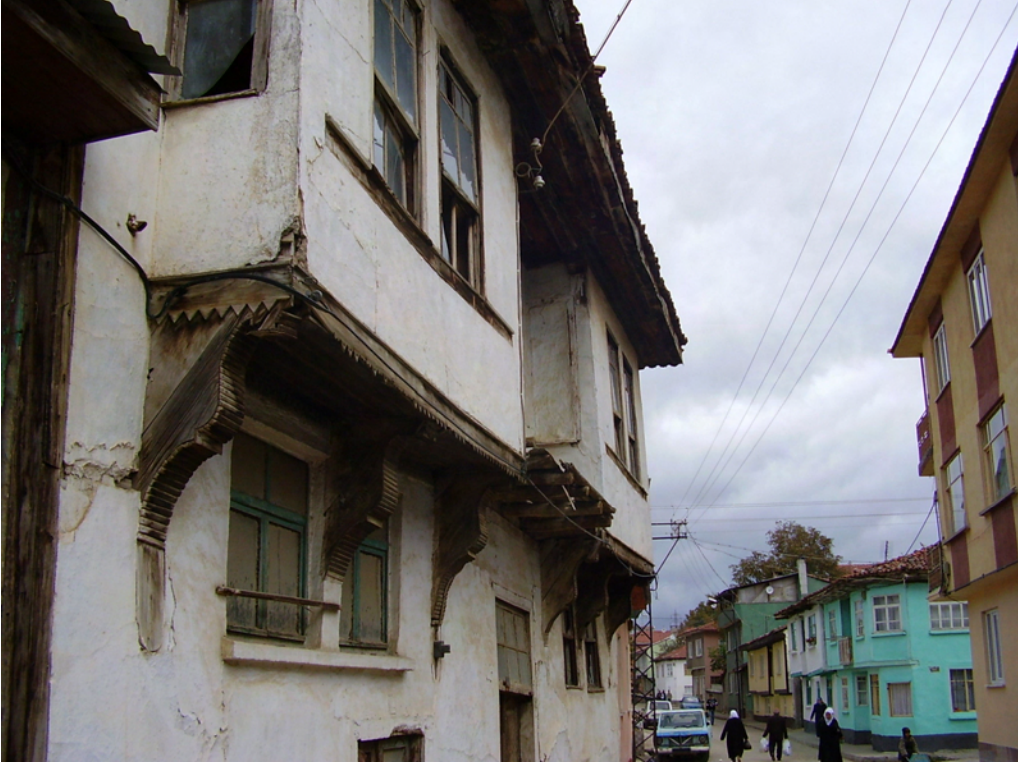
Resim 20 – Pazaryeri – Dereboğaz Mahallesi Çiçekliköy Sokak No : 6
