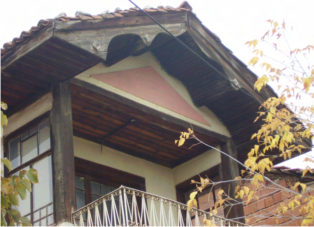
Resim 29 – Pazaryeri – Yüzbaşı Mahallesi Bursa Sokak No : 29
