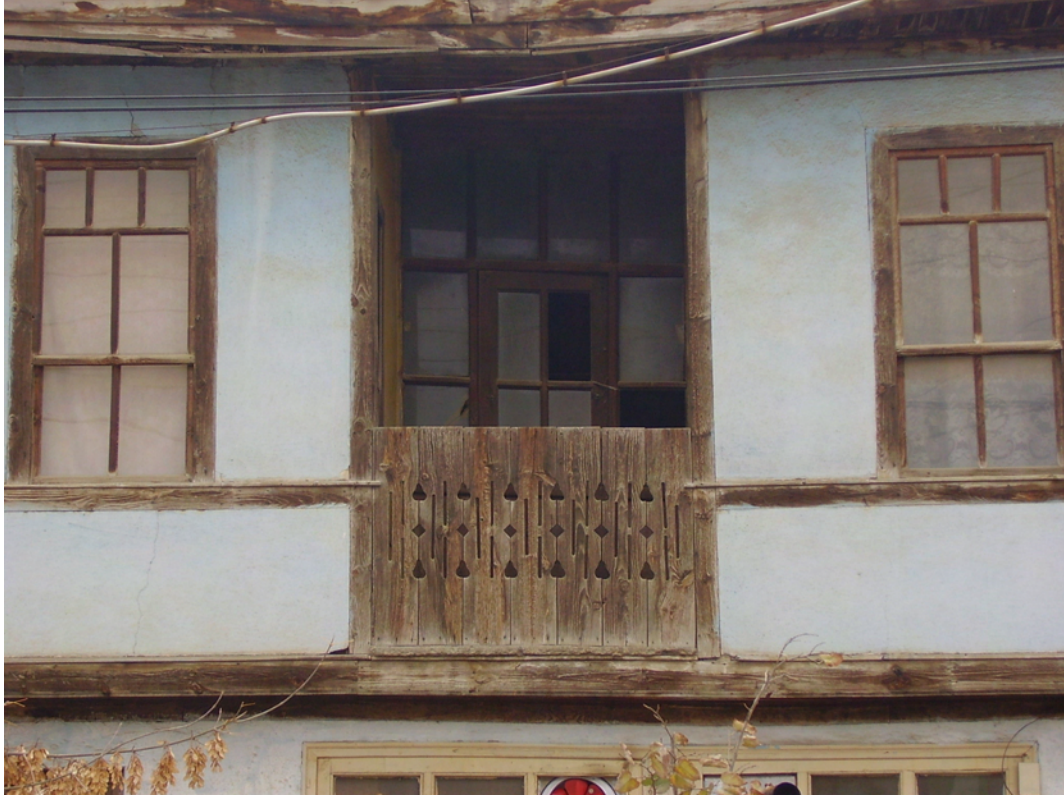
Resim 32 – Pazaryeri – Yüzbaşı Mahallesi Bursa Sokak No : 22
