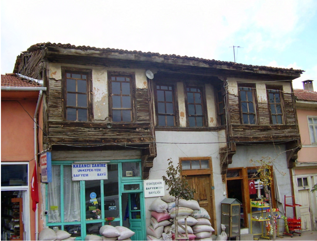
Resim 12 – Pazaryeri – Yùzbaşı Mahallesi Bursa Sokak No : 15
