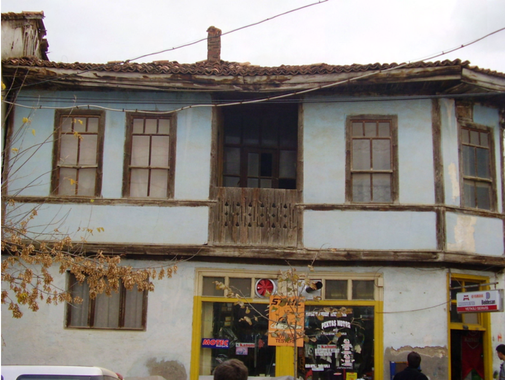
Resim 31 – Pazaryeri – Yüzbaşı Mahallesi Bursa Sokak No : 22
