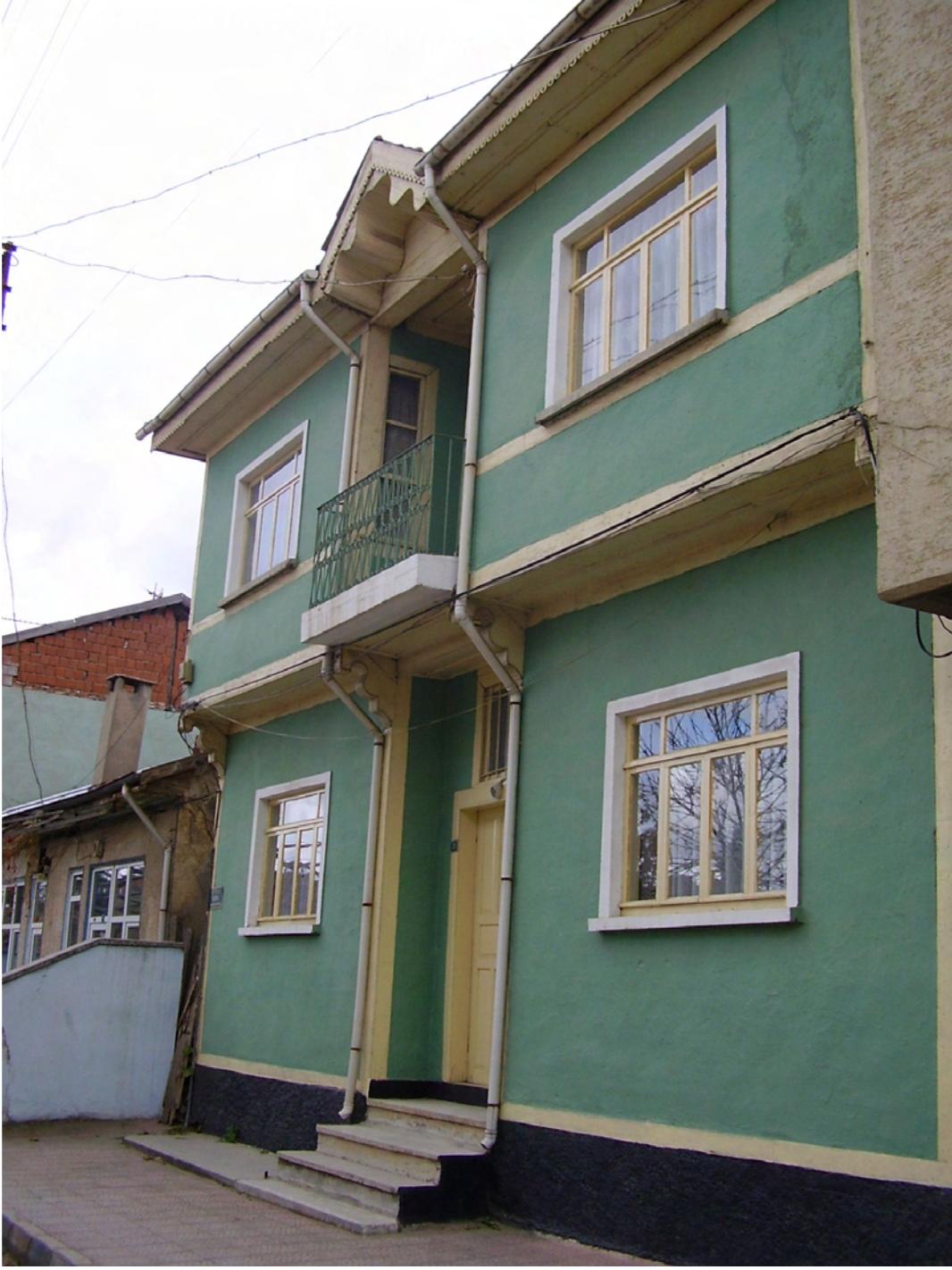
Resim 16 – Pazaryeri – Yüzbaşı Mahallesi Bursa Sokak No : 35
