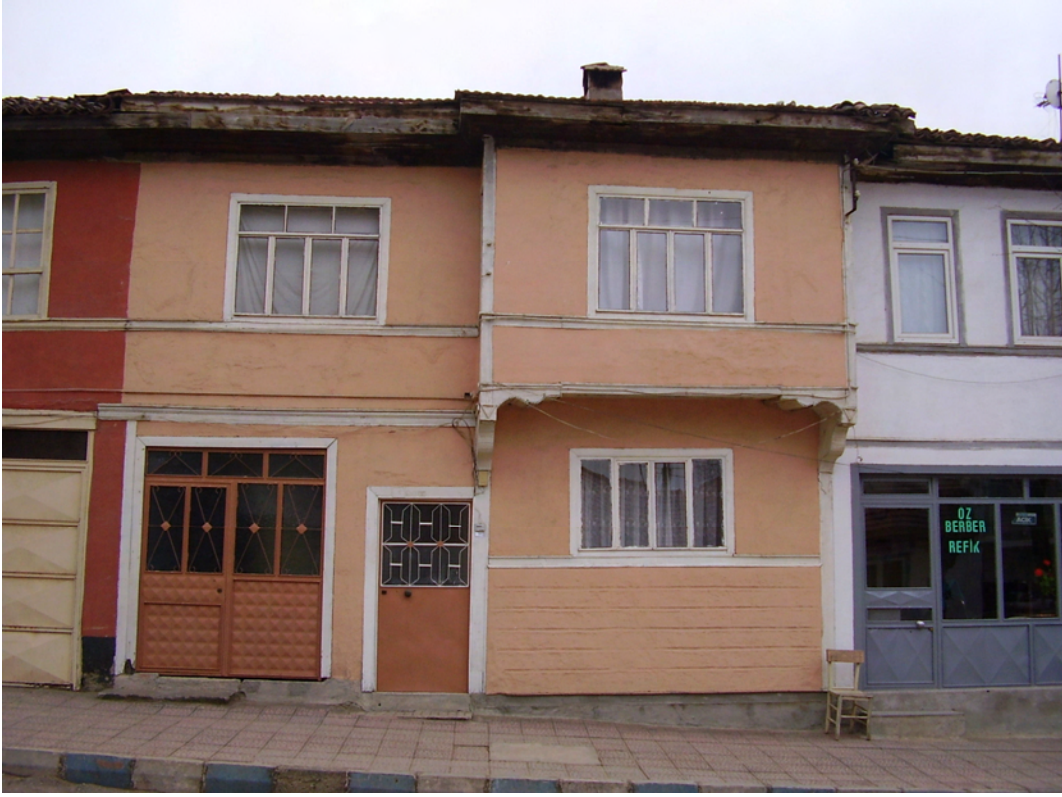
Resim 6 – Pazaryeri – Yüzbaşı Mahallesi Bursa Sokak No : 45
