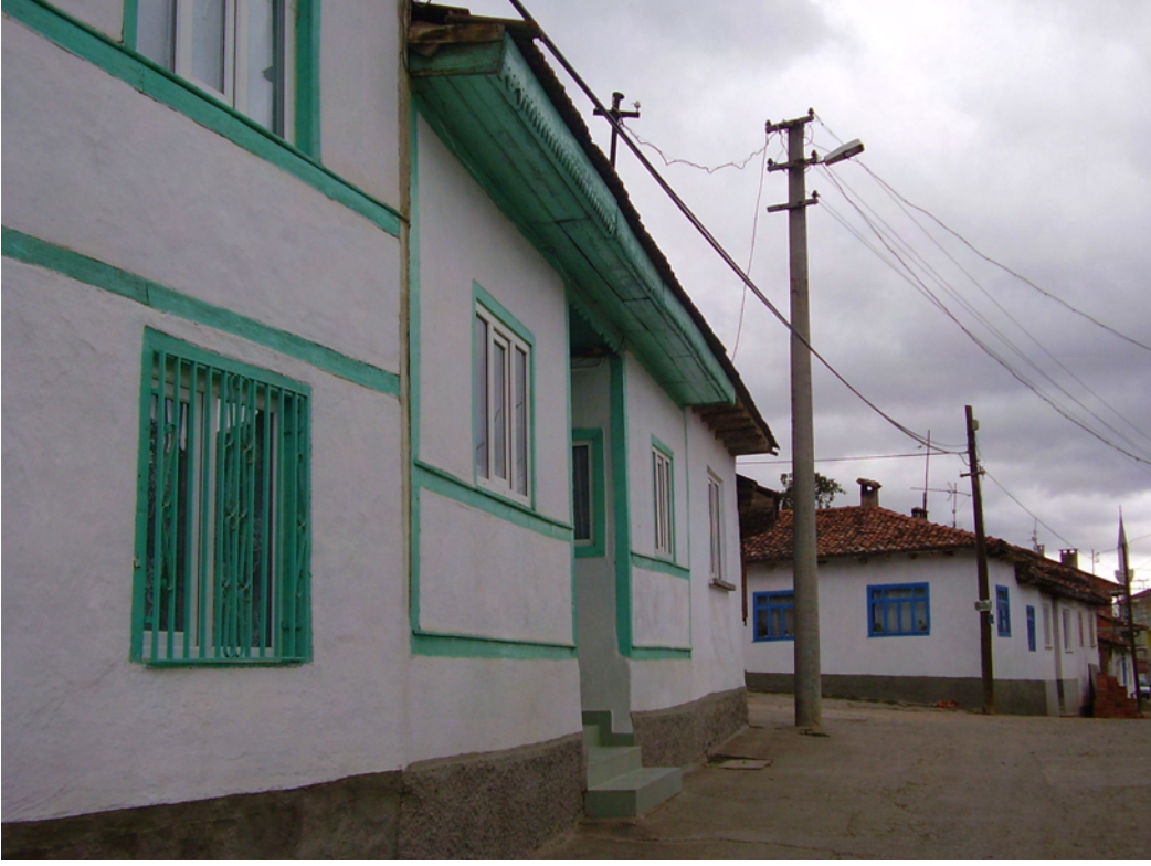
Resim 26 – Pazaryeri – Yüzbaşı Mahallesi Bursa Sokak No : 11
