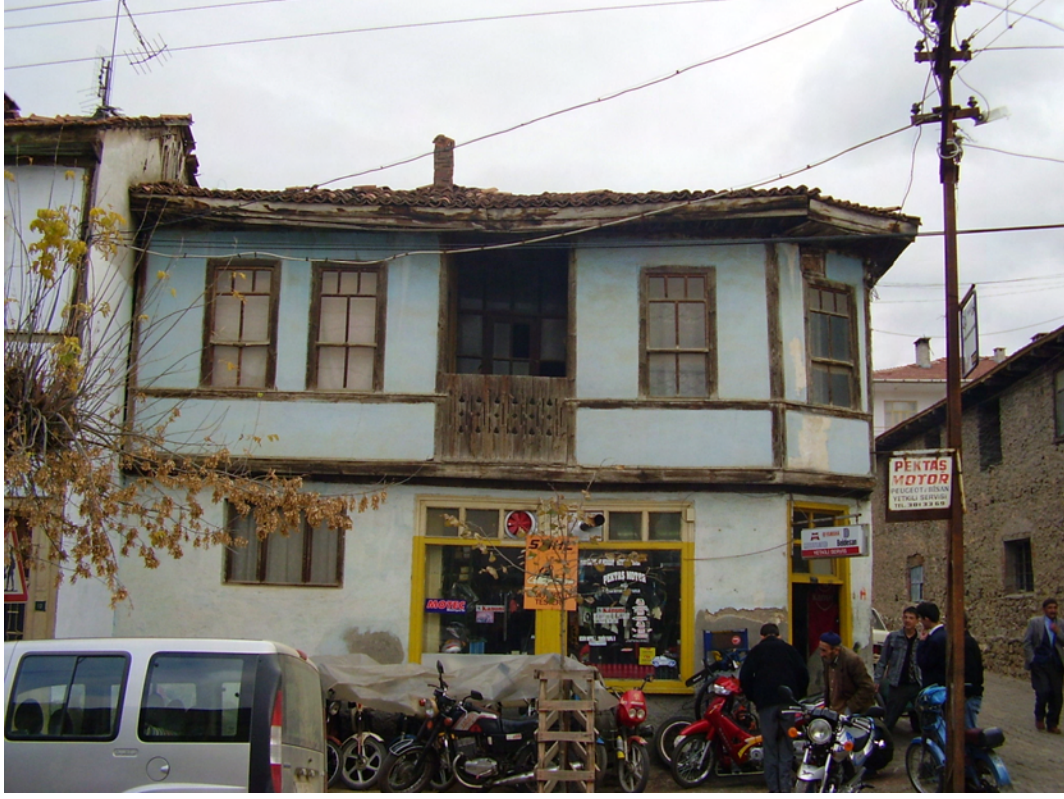
Resim 9 – Pazaryeri – Yüzbaşı Mahallesi Bursa Sokak No : 22
