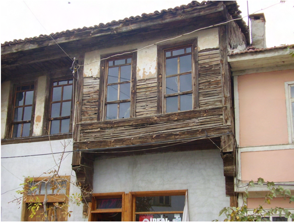
Resim 30 – Pazaryeri – Yüzbaşı Mahallesi Bursa Sokak No : 15
