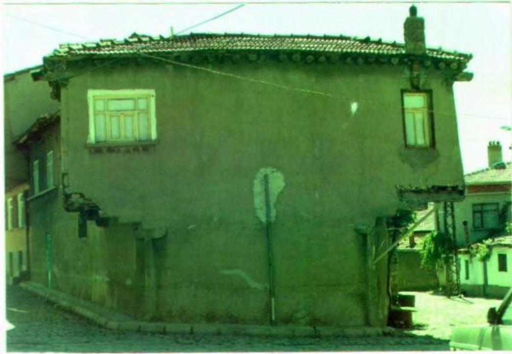
Resim 33 – Sivrihisar – Yenice Mahallesi Kavakdibi Sokak No : 6
