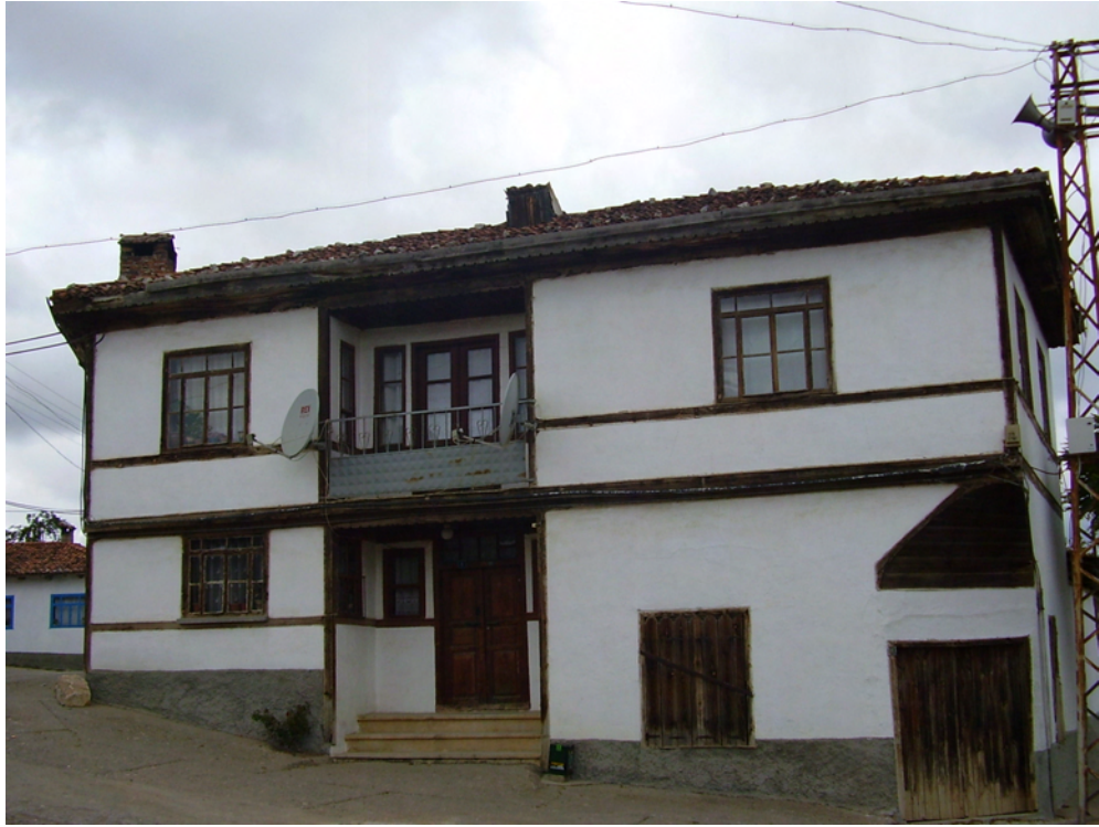
Resim 23 – Pazaryeri – Yüzbaşı Mahallesi Bursa Sokak No : 2
