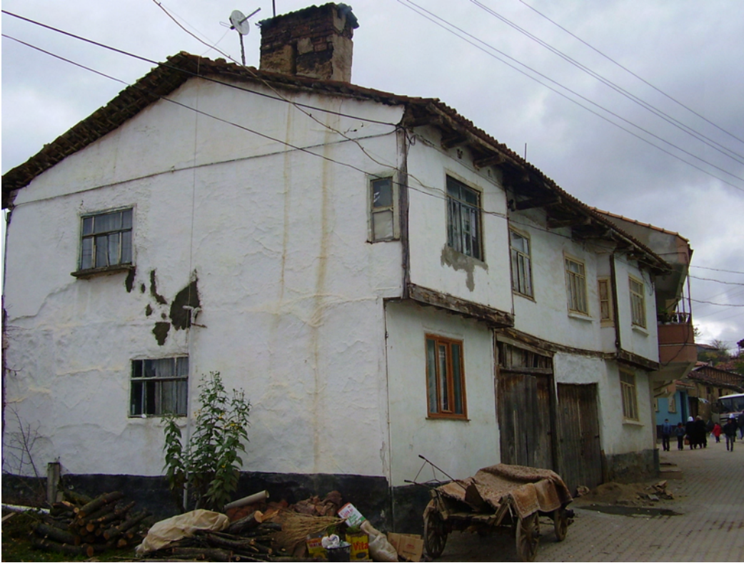
Resim 19 – Pazaryeri – Dereboğaz Mahallesi Cami Meydanı No : 23
