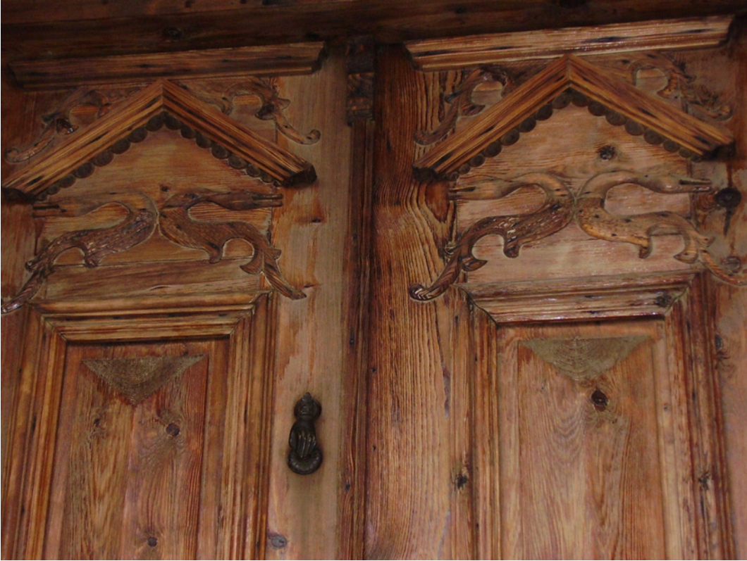
Resim 27 – Pazaryeri – Yüzbaşı Mahallesi Bursa Sokak No : 29
