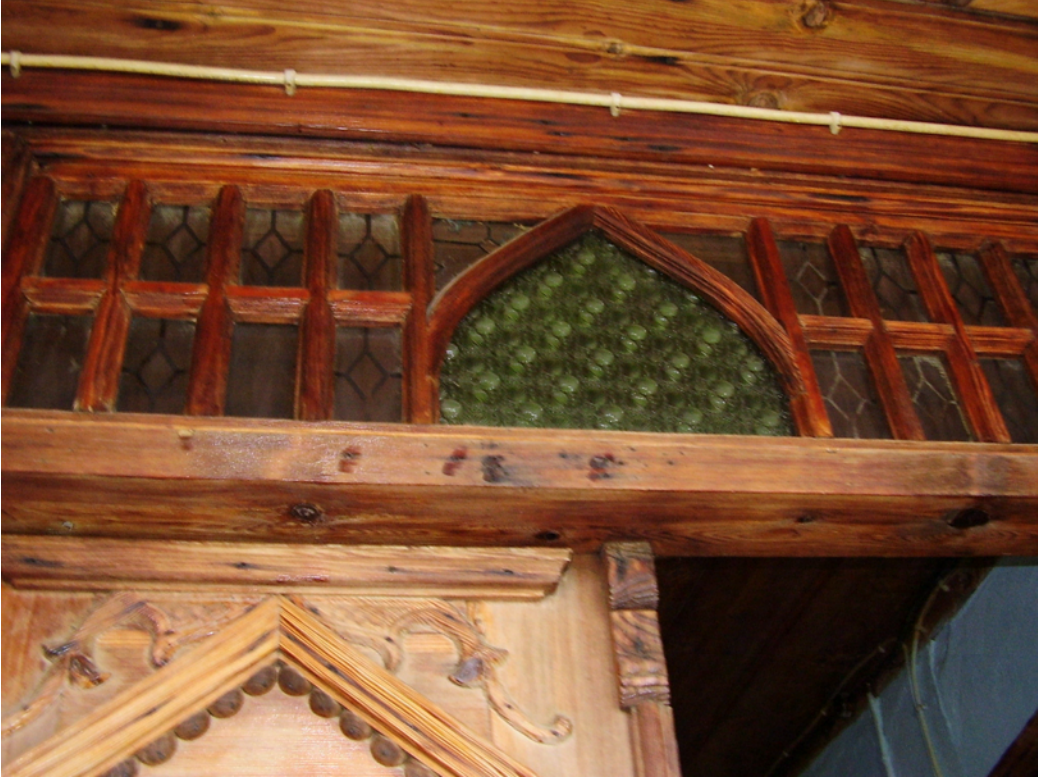
Resim 28 – Pazaryeri – Yüzbaşı Mahallesi Bursa Sokak No : 29
