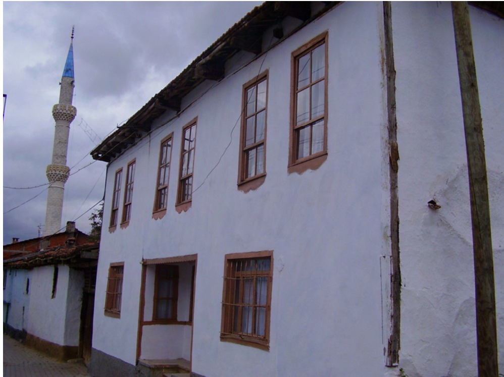
Resim 5 – Pazaryeri – Dereboğaz Mahallesi Taşlık Sokak No : 48
