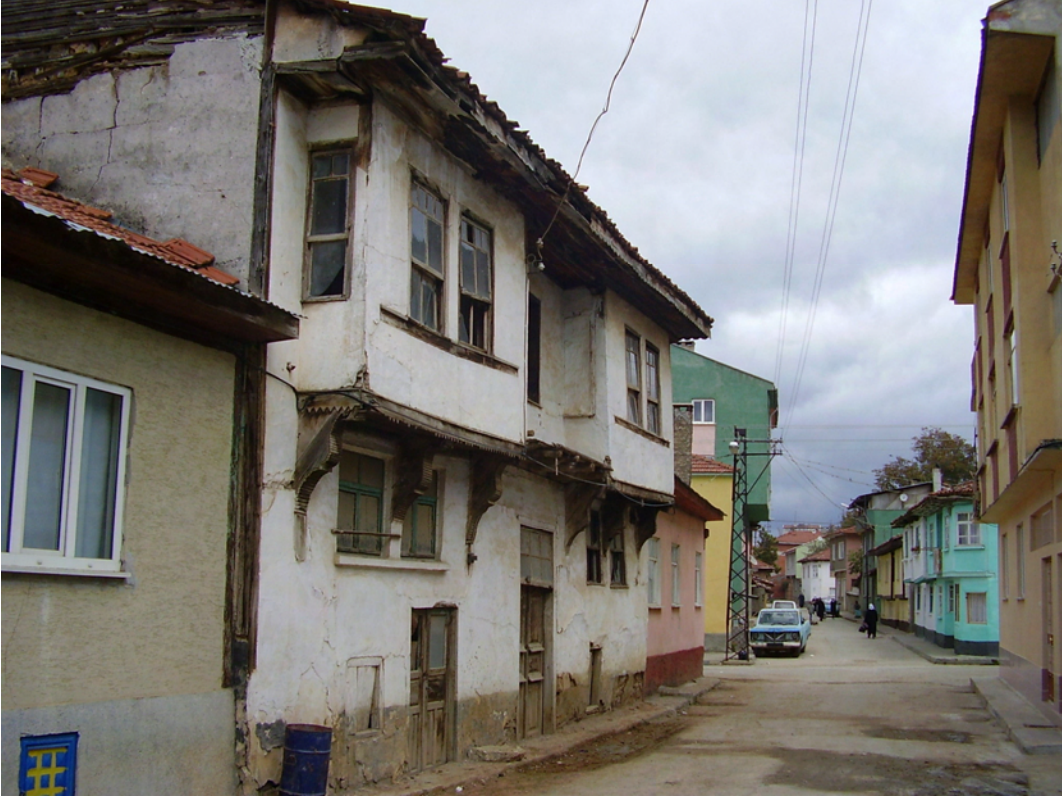
Resim 13 – Pazaryeri – Dereboğaz Mahallesi Çiçekliköy Sokak No : 6
