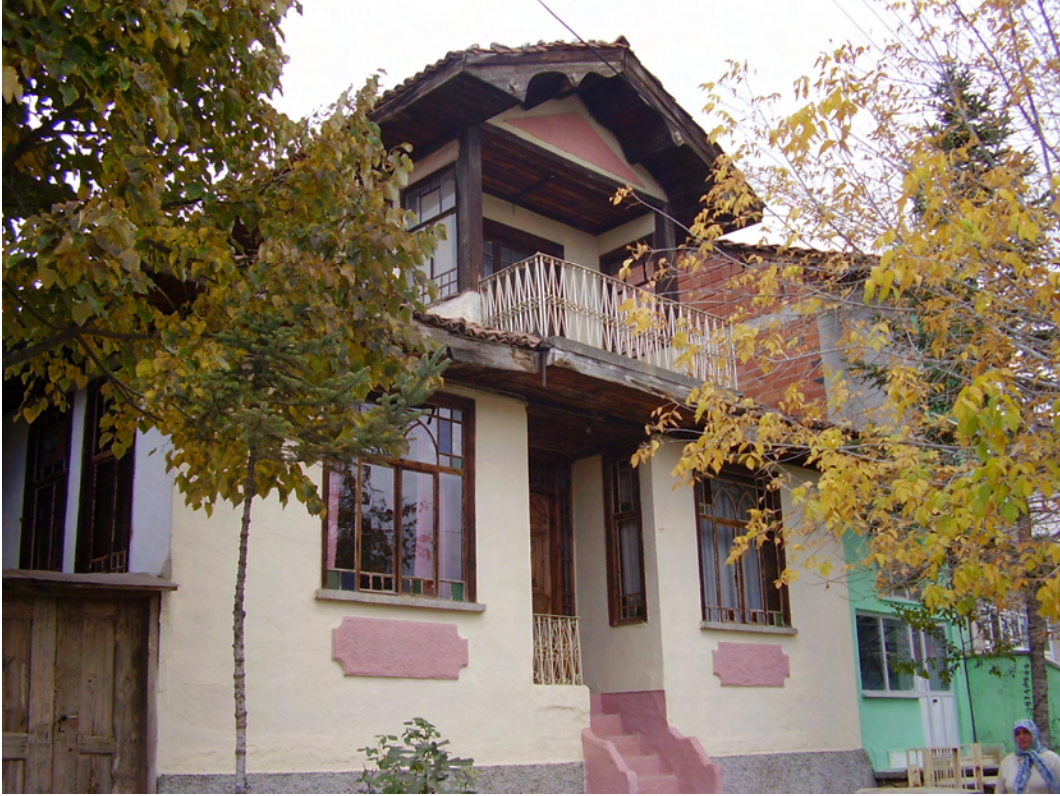
Resim 18 – Pazaryeri – Yüzbaşı Mahallesi Bursa Sokak No : 29
