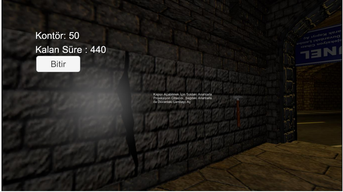
Görsel 2.12. Depremde çatlayan duvar
