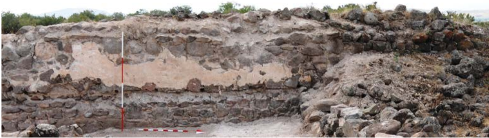
Resim 20. Y Alanı 4 Nolu Mekan Duvarındaki Ahşap Hatıl Yuvası ve Sıva Örneği 2012
