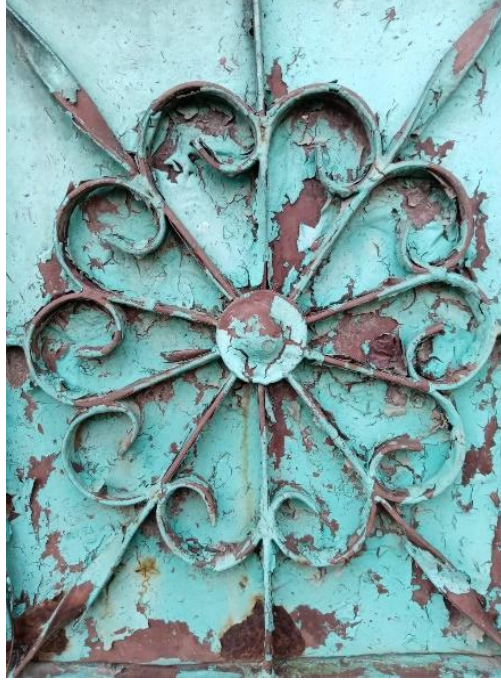
Görsel 3.99. Ahu'nun süslemelerden 10-katlı dönel simetrik çelik kapı örneği
