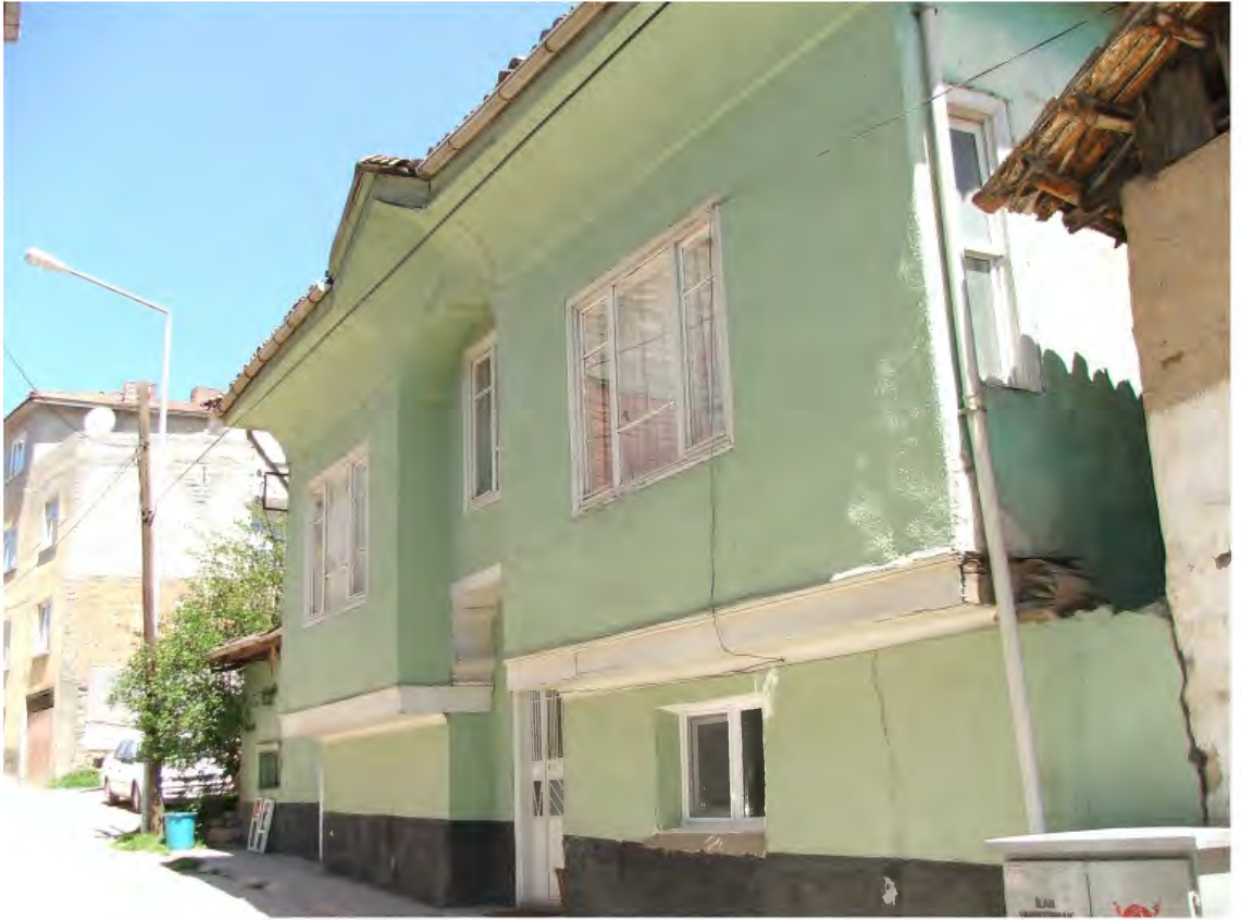
Resim 41: Bozüyük-Kasımpaşa Mah. Aşçılar Sok. No: 34
