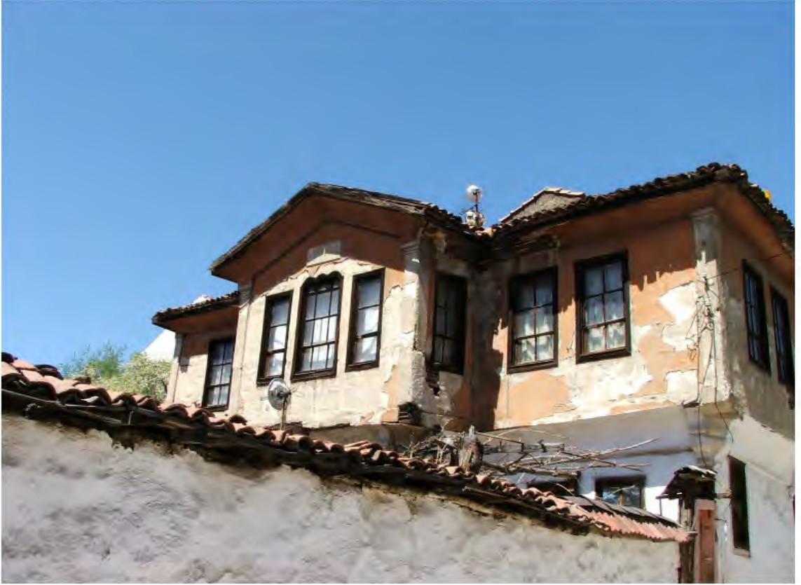
Resim 32: Bozüyük-Kasımpaşa Mah. Aşçılar Sok. No: 23
