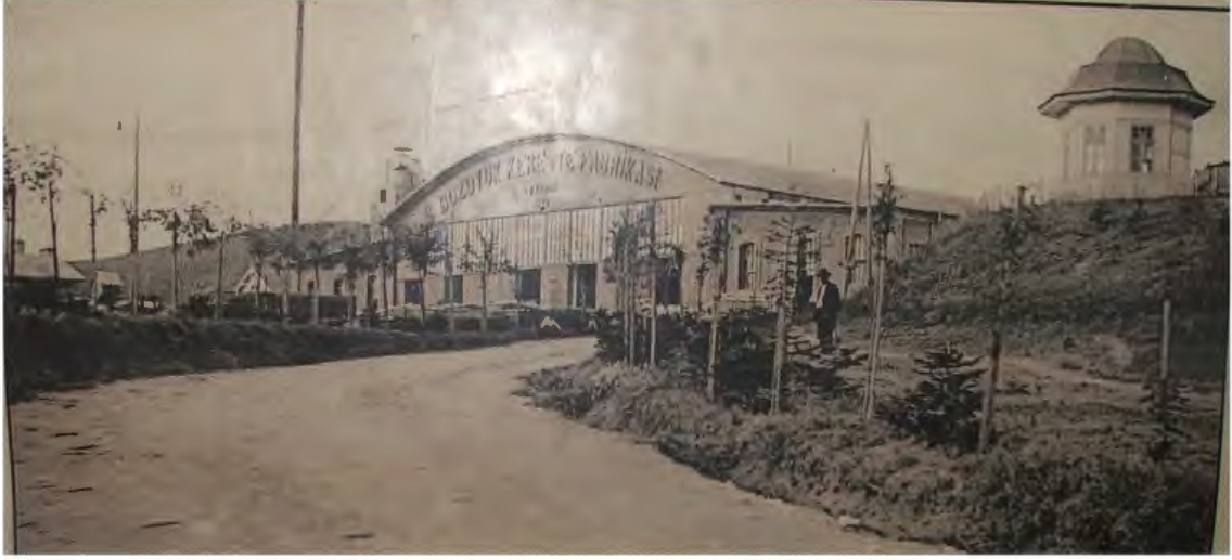
Resim 53: Bozüyük Kereste Fabrikası
