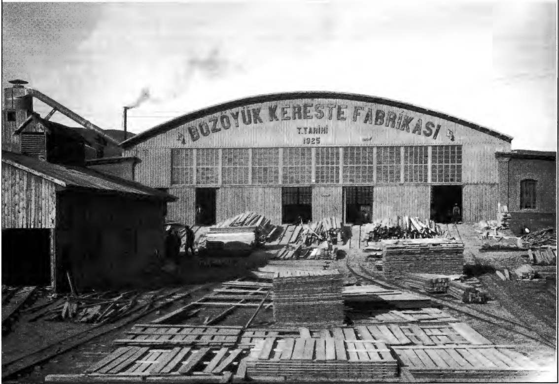
Resim 51: Bozüyük Kereste Fabrikası
