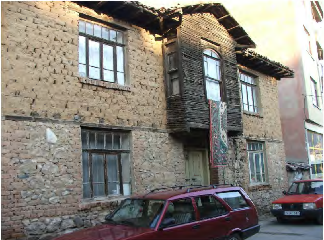
Resim 13: Bozüyük- Kasımpaşa Mah. Hacı İbrahim Sok. No: 2
