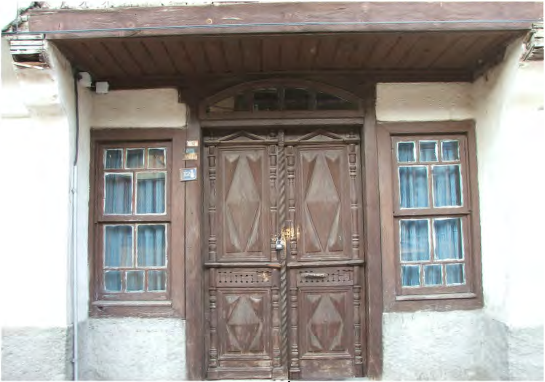
Resim 1: Bozüyük- Kasımpaşa Mah. Hacı İbrahim Sok. No:12
