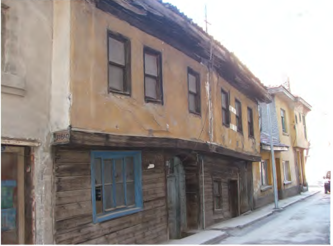
Resim 21: Bozüyük- Kasımpaşa Mah. Keşşaf Sok. No: 5
