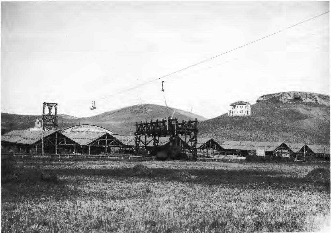
Resim 52: Bozüyük Kereste Fabrikası 105
